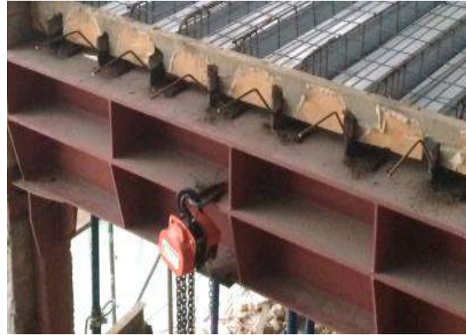
Балки перекриття прокатні 12 м, крок 2м
