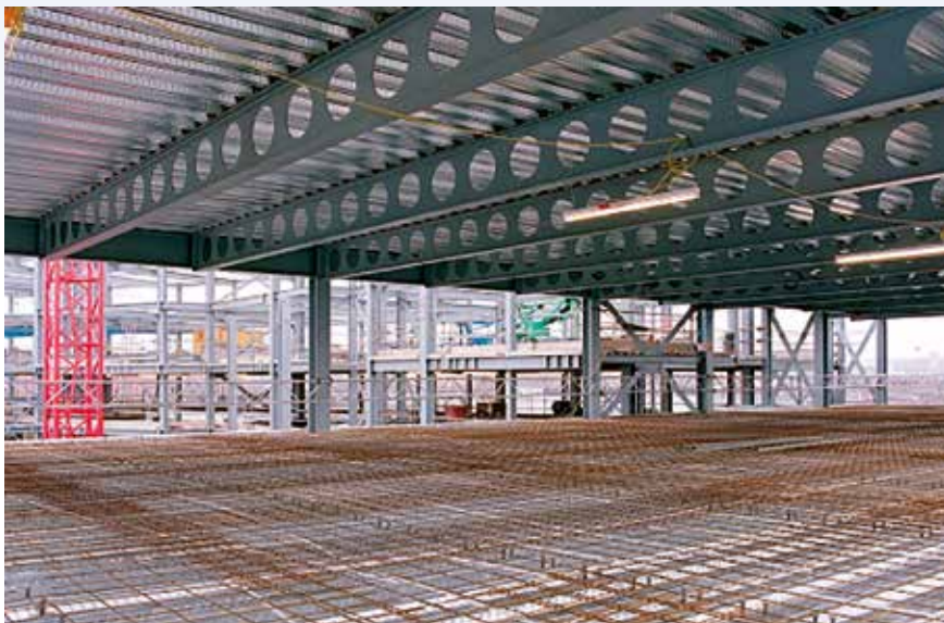
Рисунок 5.3 Композитное сталежелезобетонное перекрытие с применением перфорированных балок
