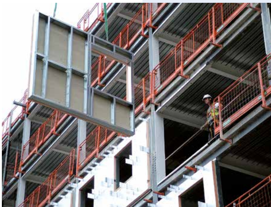
Рисунок 4.1 Монтаж лёгкой стены с внутренним утеплителем к несущему основному каркасу Kingspan Architectural
