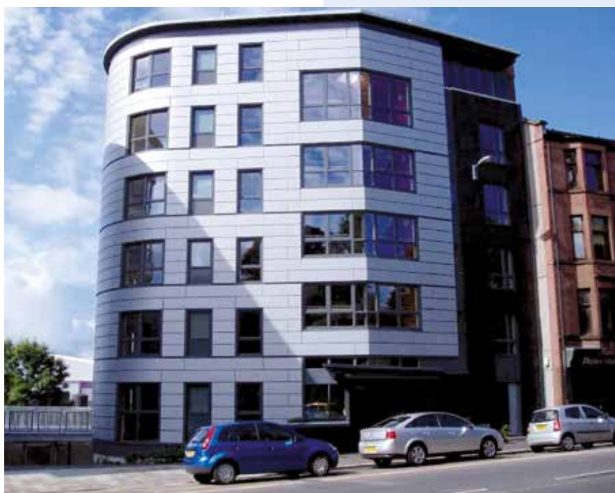
Рисунок 7.1 Жилое здание на основе каркаса из тонкостенных профилей с отделкой металлическими панелями в Глазго Peckand ReidArchitects&Metsec
