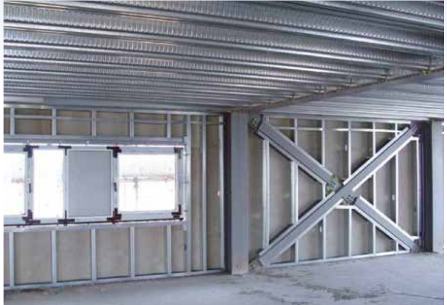
Рисунок 3.7 Стальной каркас с композитной плитой с высоким профилем настила, встроенные в плиту асимметричные двутавровые балки и каркасные стены с внутренней изоляцией
