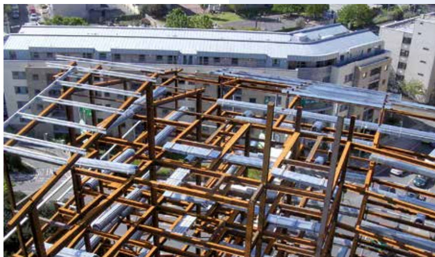
Рисунок 5.1 Стальной каркас из балок с профилем ASB и стальным настилом высокого профиля
