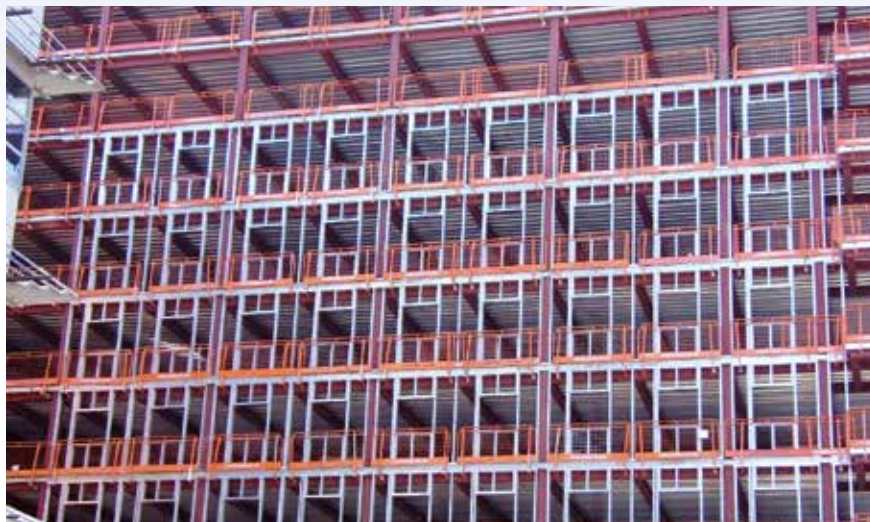
Рисунок 4.4 Стены с каркасом из тонкостенных стальных профилей
