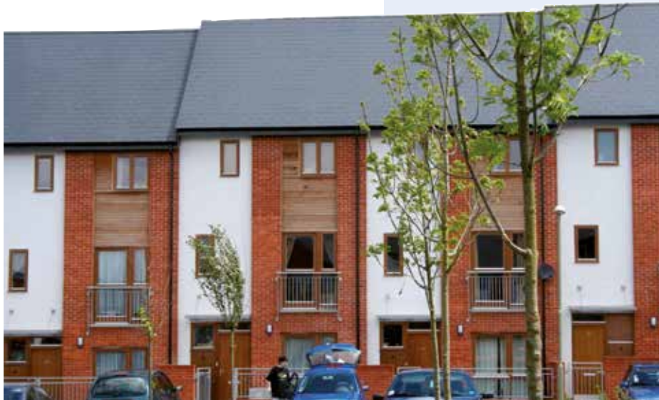
Рисунок 1.1 3-этажный жилой дом с террасой с применением лёгких тонкостенных конструкций (Басингстоук, Великобритания) HTAArchitects
