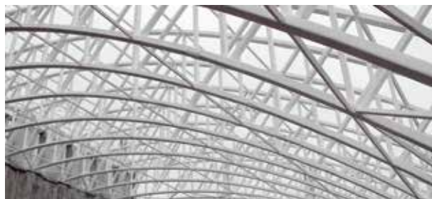
Рисунок 58. Стальные фермы с криволинейным абрисом пентаусов высотного жилого комплекса «Мегасити», Киев, Украина, архитектор Виктор Дубок, конструктив КНУСА, 2009 год
