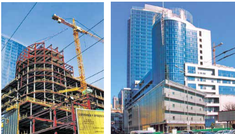
Рисунок 31. Компонировка балок перекрытий и внешний вид торгово-офисного центра Gulliver, Киев, Украина, архитектор Татьяна Григорова, конструктив «УкрНИИпроект – стальконструкция им. В.Н. Шимановского», 2013 год
