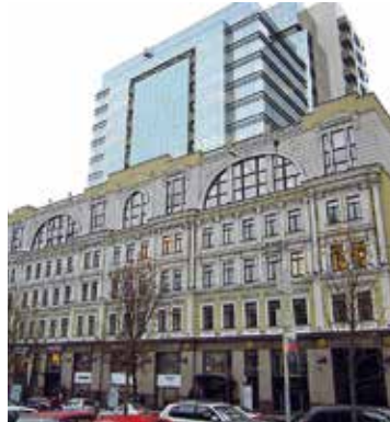
Рисунок 50. Открытые связи фасадной системы офисного центра «Леонардо», Киев, Украина, архитектурный и конструктивный проект бюро «С. Бабушкин», 2008 год
