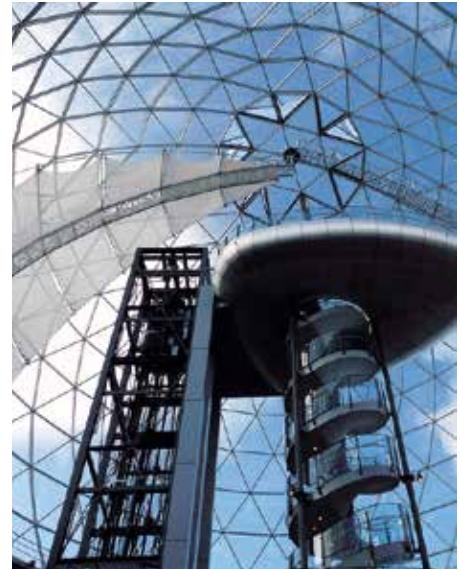
Рисунок 67. Система перекрестных ферм с треугольной ячейкой кровли пролетом 35 м в «Виктория-центр», Белфаст, Северная Ирландия, проект бюро Building Design Partnership, 2008 год
