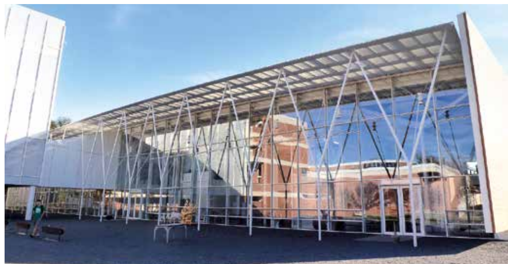
Рисунок 22. Наружные колонны с треугольными капителями здания университета Clemson, США, архитектурное бюро Thomas Phifer and Partners, конструктивный проект – бюро Skidmore, Owings & Merrill, 2013 год
