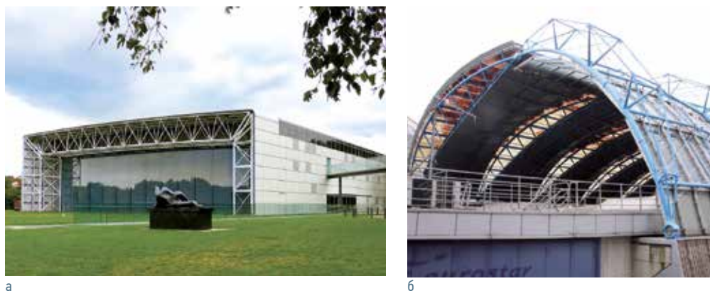
Рисунок 54. а – рамная ферменная конструкция Центра визуального искусства в Сэйнсбери, автор проекта Norman Foster; б – вантовые фермы покрытия железнодорожного терминала Waterloo, Лондон, Англия, проект бюро Nicholas Grimshaw
