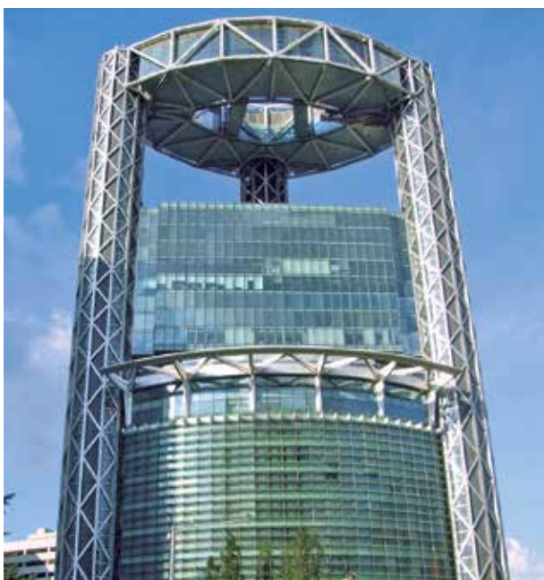
Рисунок 59. Решетчатые опоры и тяжелые фермы-аутригеры высотой в три этажа здания Jongno Tower высотой 132 м, Сеул, Южная Корея, проект бюро Samoo Architects & Engineers, 1999 год
