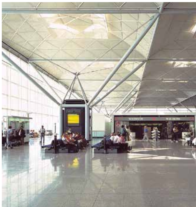
Рисунок 88. Сквозная опора из четырех ветвей трубчатого сечения структурного покрытия аэропорта Станстед, Англия, архитектурное бюро Foster + Partners, конструктивный проект Ove Arup & Partners, 1991 год
