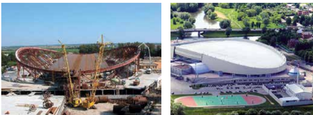
Рисунок 42. Мембрана, подкрепленная вантами покрытия главного зала стадиона, 90x87 м, Ангарск, Российская Федерация, архитектура «Сибирский «Оргстройпроект», конструктор «Курортпроект», 2006 год
