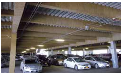
Рисунок 170. Применение плит для огнезащиты основных несущих конструкций
