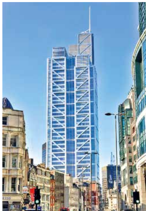
б б. Внешний каркас высотного здания Heron Tower, Лондон, Англия, архитектурное бюро Kohn Pedersen Fox, конструктивный проект – бюро Arup, 2011 год
