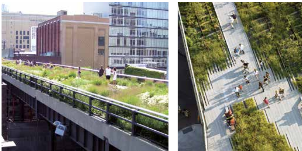
Рисунок 165. Превращение стальной несущей эстакады после окончания жизненного цикла в парковую зону High Line, Нью-Йорк, США, 2009 год
