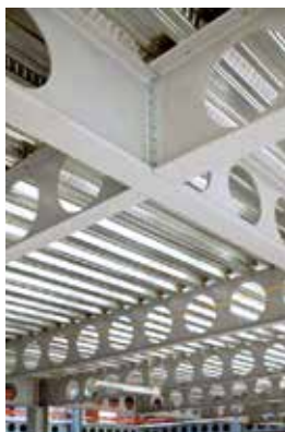
Рисунок 126. Болтовое соединение второстепенной и главной перфорированных балок равной высоты с подрезкой полки
