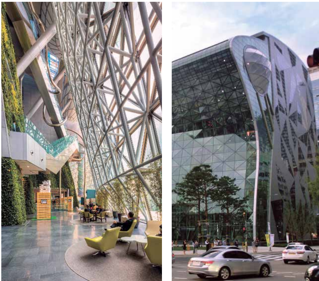
Рисунок 154. Фахверковые фермы стеклянного фасада Seoul City Hall, Южная Корея, проект Heerim Architects & Planners Co., 2012 год
