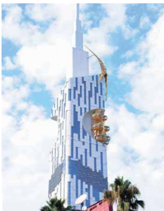
Рисунок 26. Стальное консольное колесо обозрения в высотном здании технологического университета в Батуми, Грузия, архитектор Давид Гогичаишвили, конструктив Артем Билык, Валентин Архипов, 2012 год
