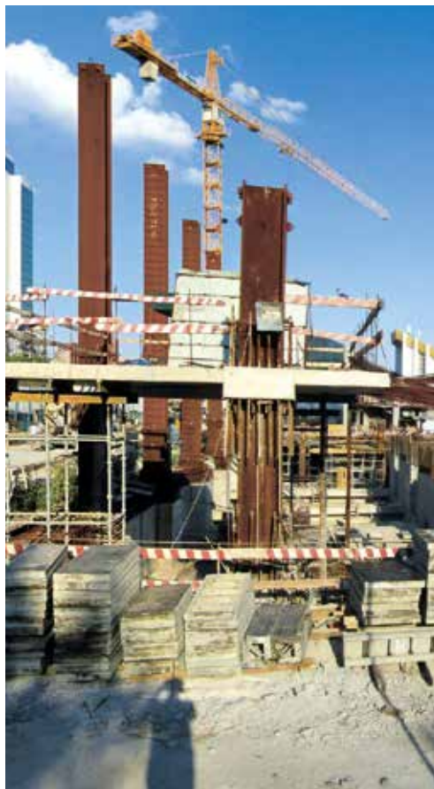
Рисунок 85. Сталежелезобетонные колонны здания SkyTowers высотой 214 м, Киев, Украина, проект бюро DLN, Maunsell Aecom, Виталий Васягин, Вадим Кирица, 2014 год
