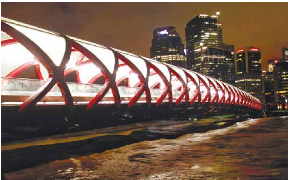
Рисунок 10. Цельносварной пешеходный «Мост Мира» пролетом 126 м, Калгари, Канада, архитектор и конструктор Santiago Calatrava, 2010 год
