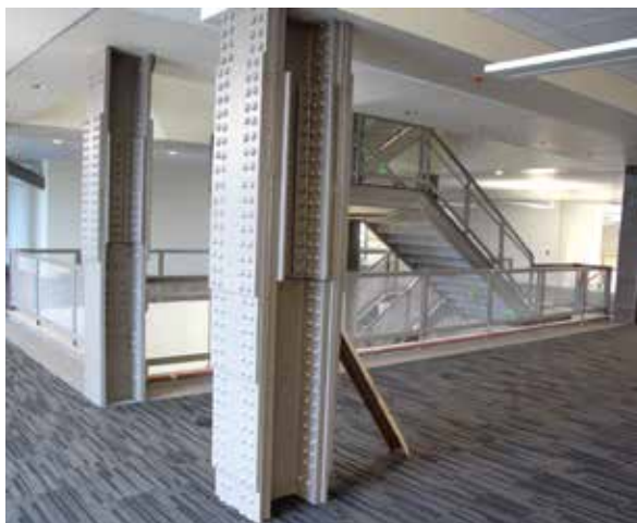
Рисунок 133. Монтажный стык двутавровых колонн на высокопрочных болтах
