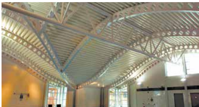
Рисунок 80. Использование криволинейных перфорированных балок в помещении автосалона
