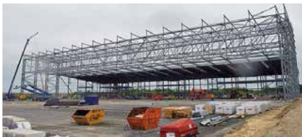
Рисунок 57. Авиационный ангар с фермами пролетом 125 м в аэропорту Stansted, архитектура бюро Foster + Partners, конструктив бюро Arup, 1991 год
