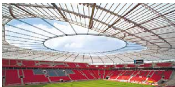
Рисунок 60. Ферма опорного контура и решетчатые прогоны вантового покрытия стадиона BayArena, Лейпциг, Германия, архитектор Max Bögl, конструктив BMR Structural Engineering, 2009 год
