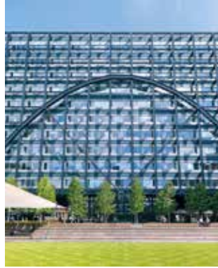
Рисунок 97. Фасадный аутригер с арочной конструкцией 10-этажного здания над станцией метро Liverpool Street, проект Skidmore Owings and Merrill Лондон, Англия, 1992 год
