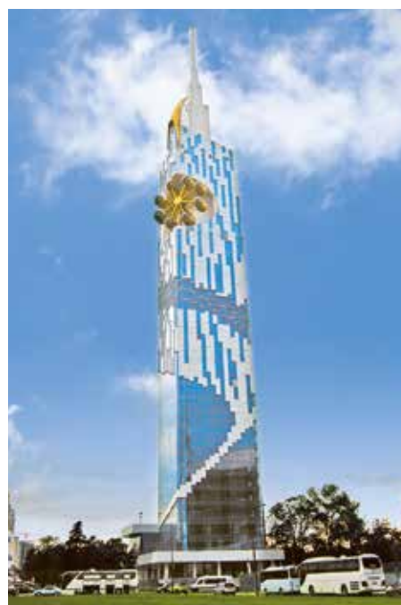
Рисунок 26. Стальное консольное колесо обозрения в высотном здании технологического университета в Батуми, Грузия, архитектор Давид Гогичаишвили, конструктив Артем Билык, Валентин Архипов, 2012 год
