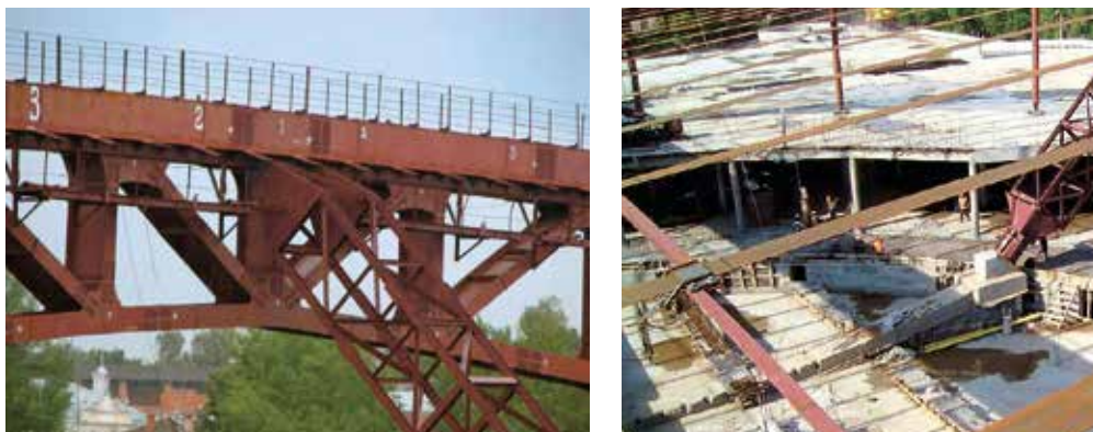
Рисунок 114. Опорный контур из тяжелых ферм с узлами на высокопрочных болтах и узел подкрепляющей полосы, раскрепленный связями на уголках мембранного покрытия конькобежного стадиона, Коломна, Российская Федерация
