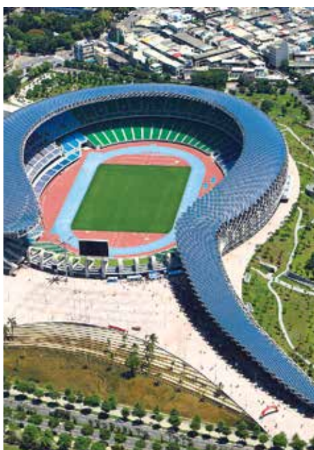
Рисунок 106. Сетчатая оболочка стадиона Kaohsiung с покрытием из солнечных батарей, Тайвань, архитектор Toyo Ito, 2009 год
