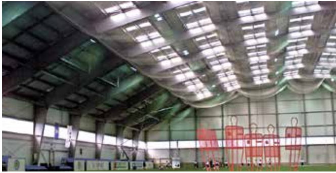
Рисунок 93. Каркас из двухшарнирных рам переменного сечения с ригелями ломаного очертания площадки «Динамо» пролетом 72 м, с. Конча-Заспа, Киев, архитектор Виталий Оксюковский, конструктивный проект КНУСА, 1998 год
