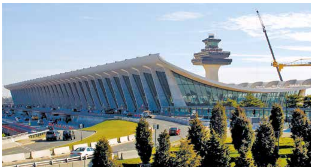
Рисунок 34. Однопоясная висячая система терминала международного аэропорта имени Даллеса в Вашингтоне, США, архитектор Eero Saarinen, конструктивный проект – бюро Ammann&Whitney, 1962 год
