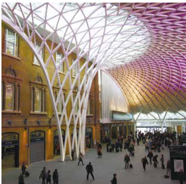
Рисунок 4. Мезоуровень – архитектурный. Структурная оболочка, используемая в главном вестибюле лондонского железнодорожного вокзала King's Cross, Лондон, Англия, архитектурное бюро John McAslan + Partners, конструкторский проект от бюро Arup, 2012 год
