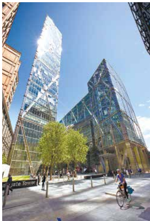
а а. Внешняя ферма каркаса Broadgate Tower, Лондон, Англия, архитектура и конструктив – бюро Skidmore, Owings & Merrill, 2009 год
