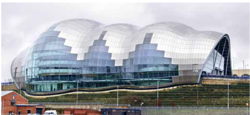
Рисунок 103. Сетчатая оболочка Центра искусства The Sage Gateshead, Гейтсхед, Англия, архитектурное бюро Foster + Partners, конструктивный проект Mott MacDonald, 2004 год
