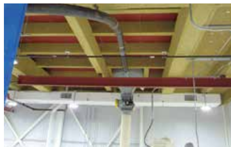
Рисунок 170. Применение плит для огнезащиты основных несущих конструкций
