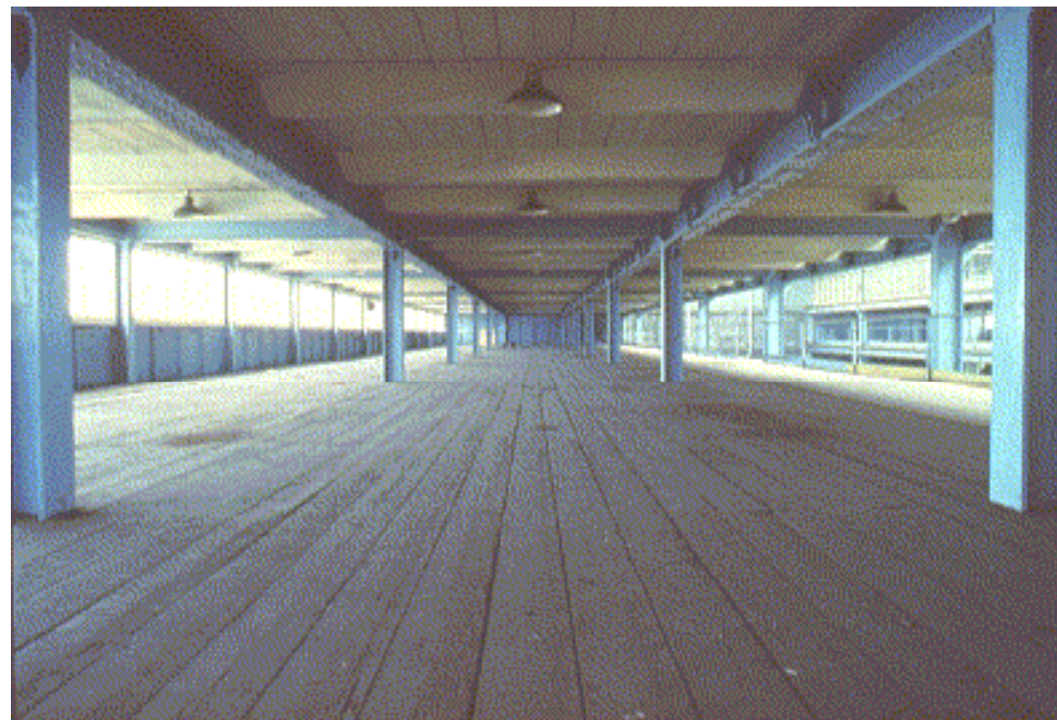
Чотирьохповерхова будівля Greene's Boat House, м. Sheerness, ВБ, 1858 р. з сіткою колон 4x9 м
