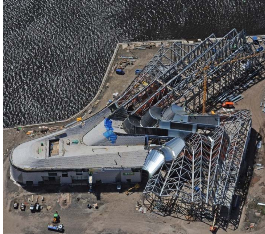
Складчате просторове стержневе покриття музею транспорту Riverside, Глазго, Шотландія, арх. Z. Hadid, конструктив Buro Happold, 2012 р.
