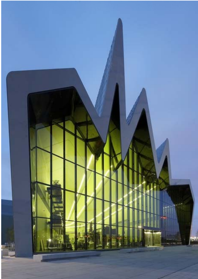
Складчате просторове стержневе покриття музею транспорту Riverside, Глазго, Шотландія, арх. Z. Hadid, конструктив Buro Happold, 2012 р.
