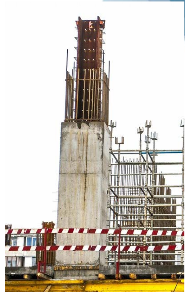
Сталезалізобетонні колони будівлі «Скайтауер», м.Київ висотою 214 м. Київ, проект бюро DLN, Maunsell Aесom, В. Васягін, В.Кириця, 2014
