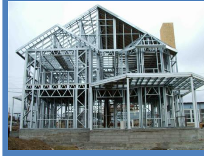
Каркасы малоэтажного жилья
