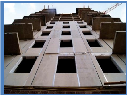
Панели многоэтажных зданий
