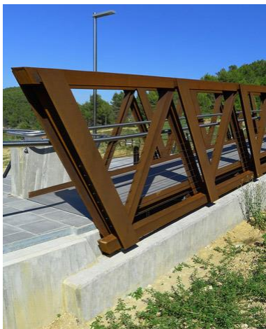
Пешеходный мост, SanPere Sacarera, Испания
