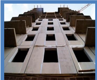
Панели многоэтажных зданий
