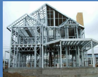
Каркасы малоэтажного жилья
