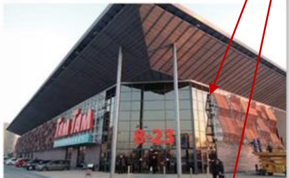
ТРЦ Там Там, г. Киев. Вес металлоконструкций - 1 500 т.
