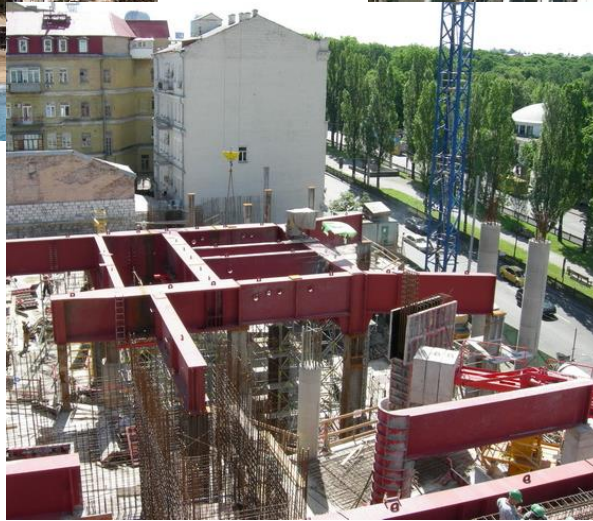
Комплекс H-Tower с Отелем Hilton Киев, 2014 г Монтаж каркаса 1 060 т – 7 месяцев Укрстальконструкция
