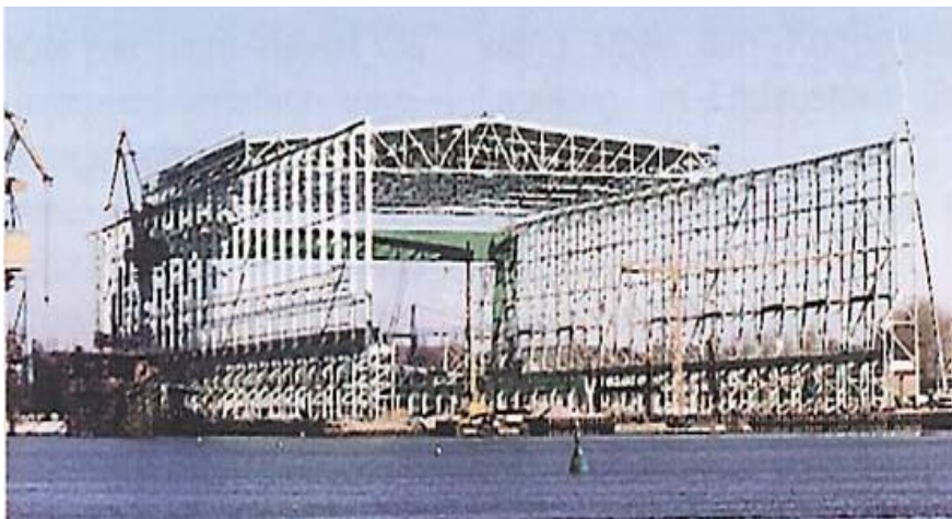
Судостроительный док, Германия. Пролет 155 м
