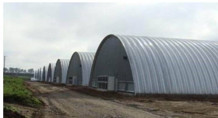
Быстровозводимые склады с применением стальных гофро арок, Киевская обл. 3000 кв.м./месяц
