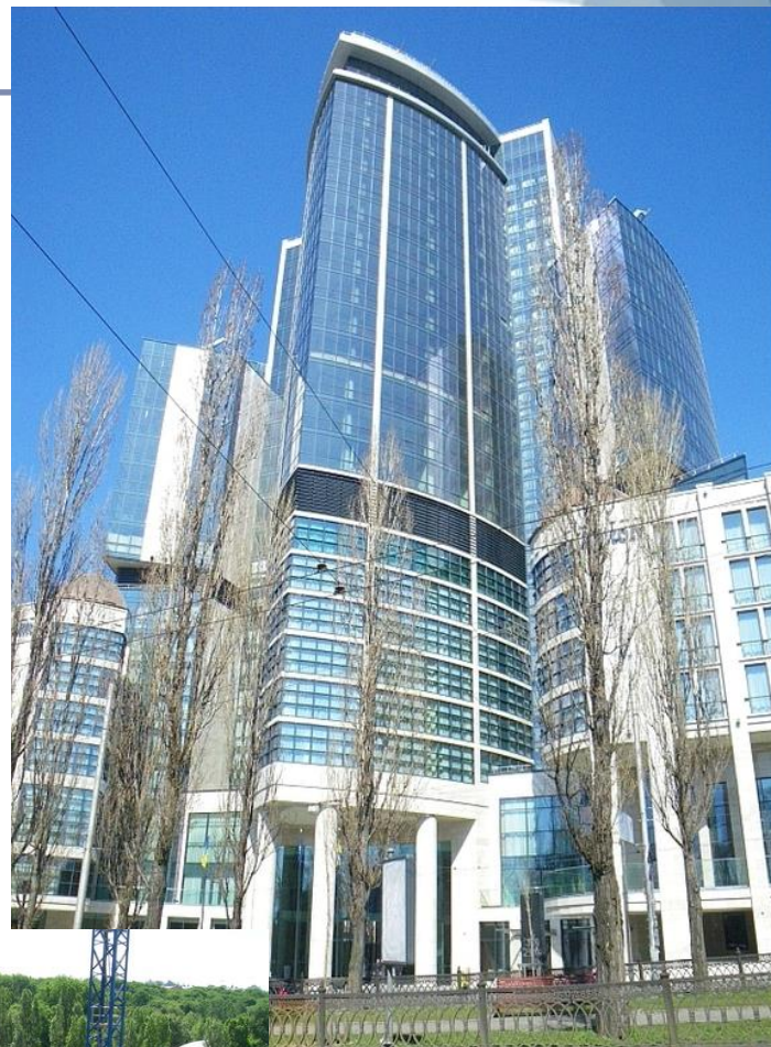
Комплекс H-Tower с Отелем Hilton Киев, 2014 г Монтаж каркаса 1 060 т – 7 месяцев Укрстальконструкция
