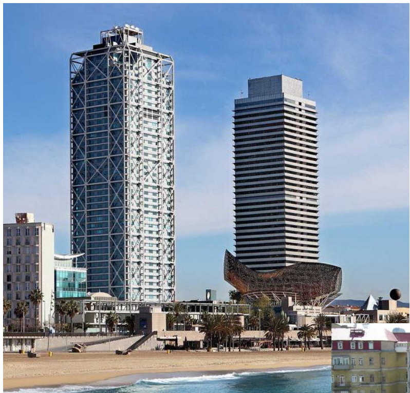
Hotel Arts Barcelona с каркасом из высокопрочной стали
