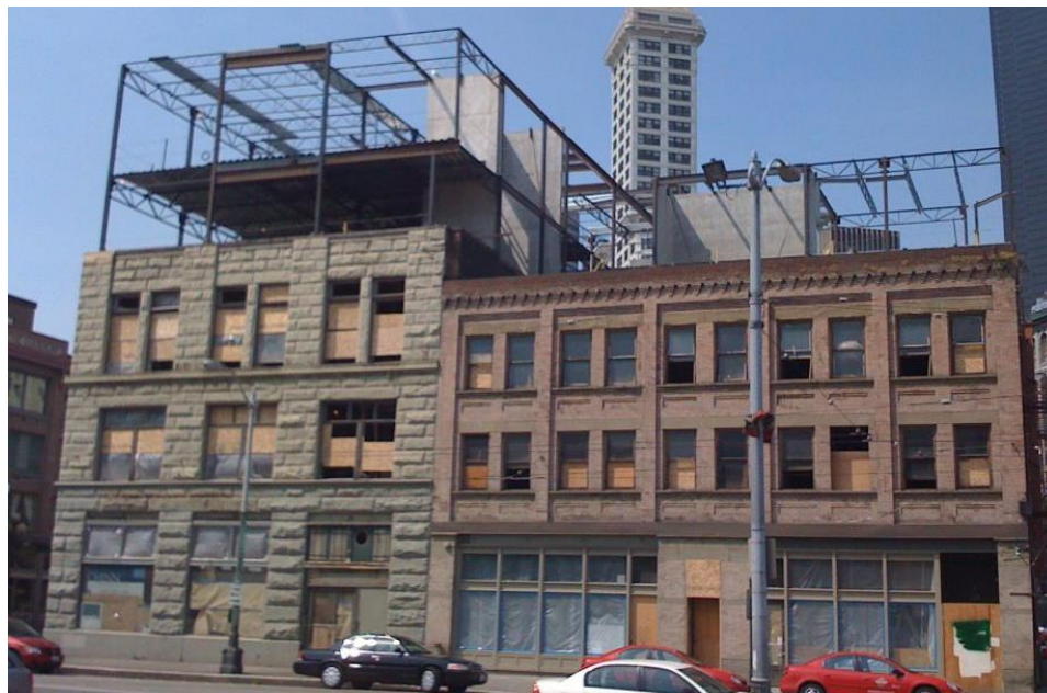
Надстройка здания 1901 г. в г. Сиэтл, США, 2010 г.
