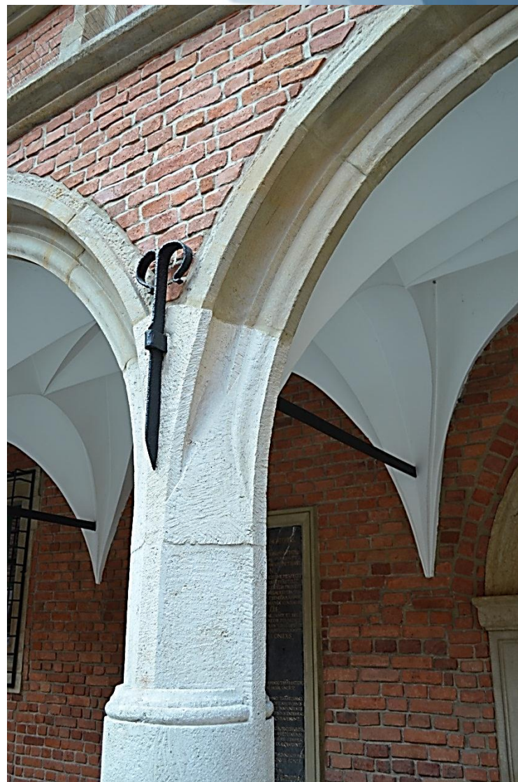
Затяжка и анкер в соборе в Кракове (Польша)
