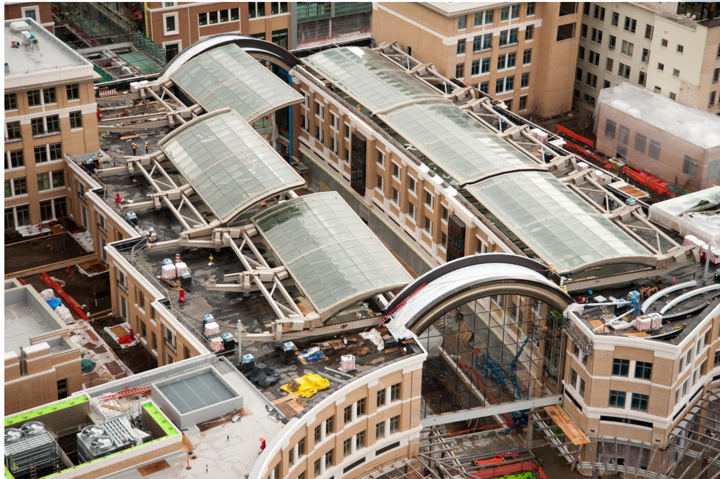
Трансформирована кровля пассажа Торгового Центра City Creek, Salt Lake City, США, 2011 г.
