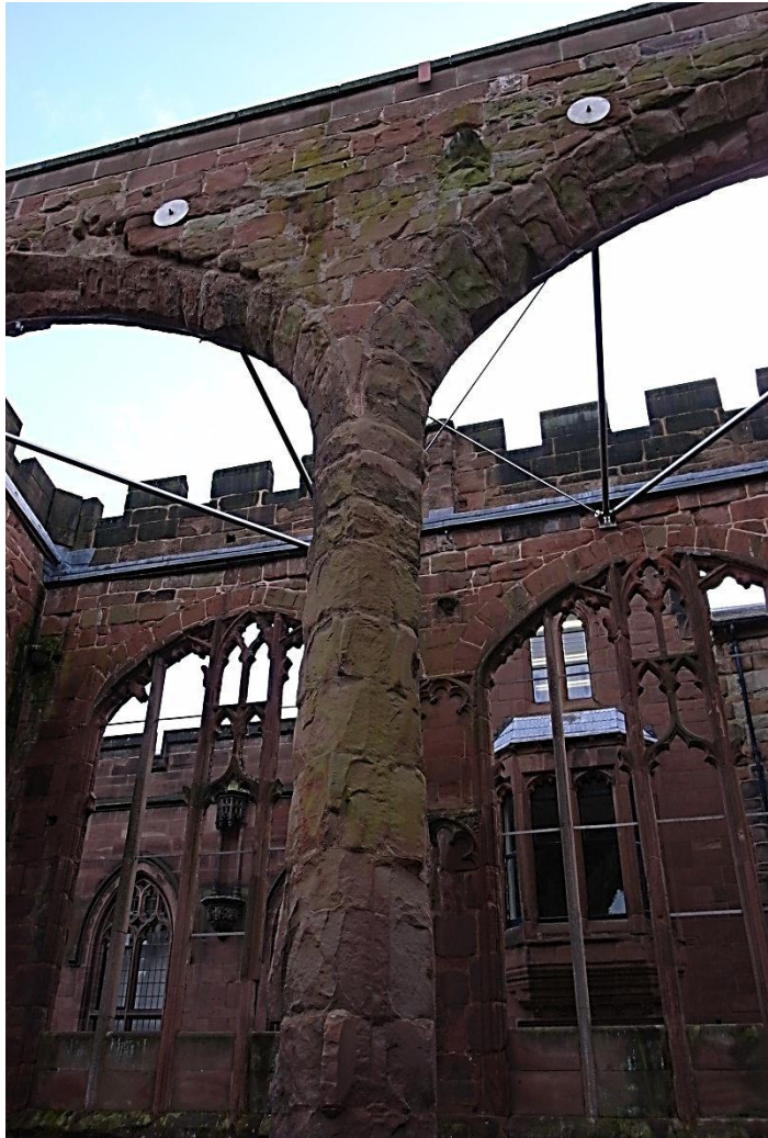
Затяжки для удержания руин Coventry Cathedral, ВБ
