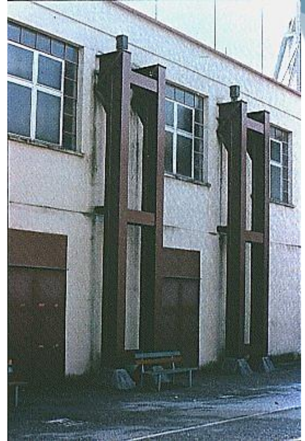
Усиление перекрытия металлическими рамами, г. Канту, Италия, 1990 г.
