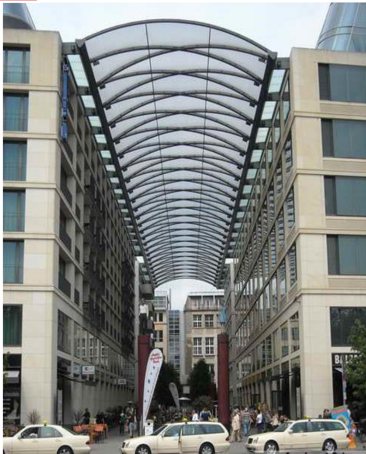
Перекрытие пассажа между двумя существующими зданиями, Германия
