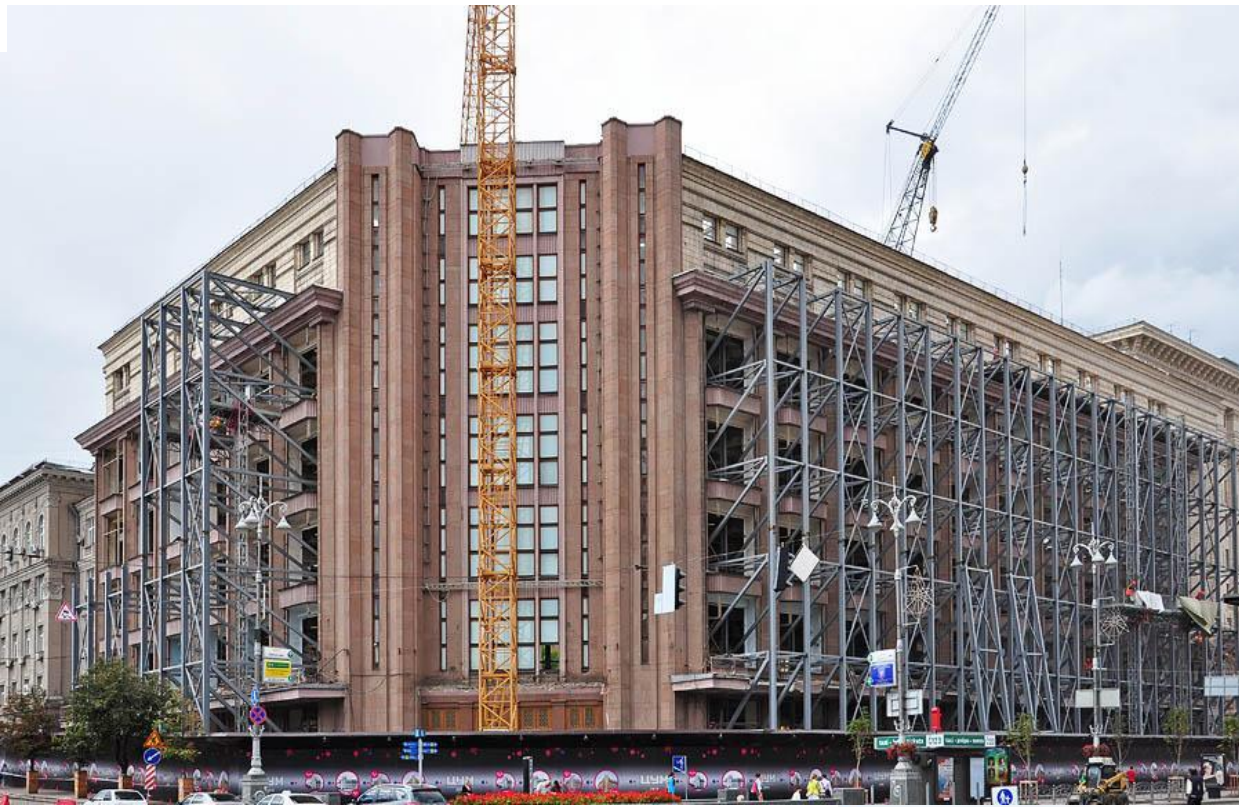
Поддержание стен временным металлокаркасом во время реконструкции ЦУМа (Киев)
