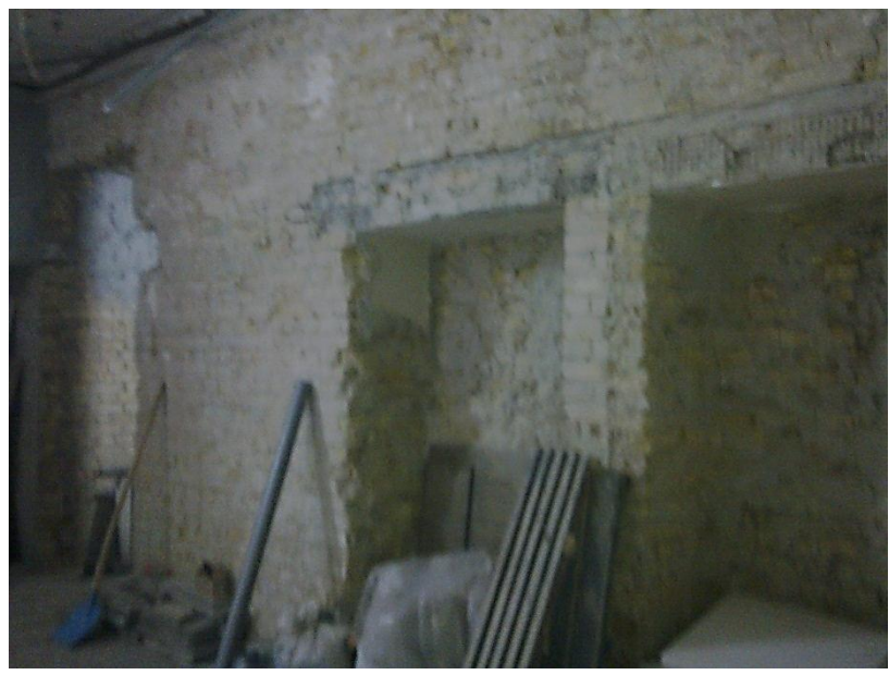
Устройство обоев, ригелей и просветов в несущей стене магазина в 8-этажном здании по ул. Артема 55, г. Киев
