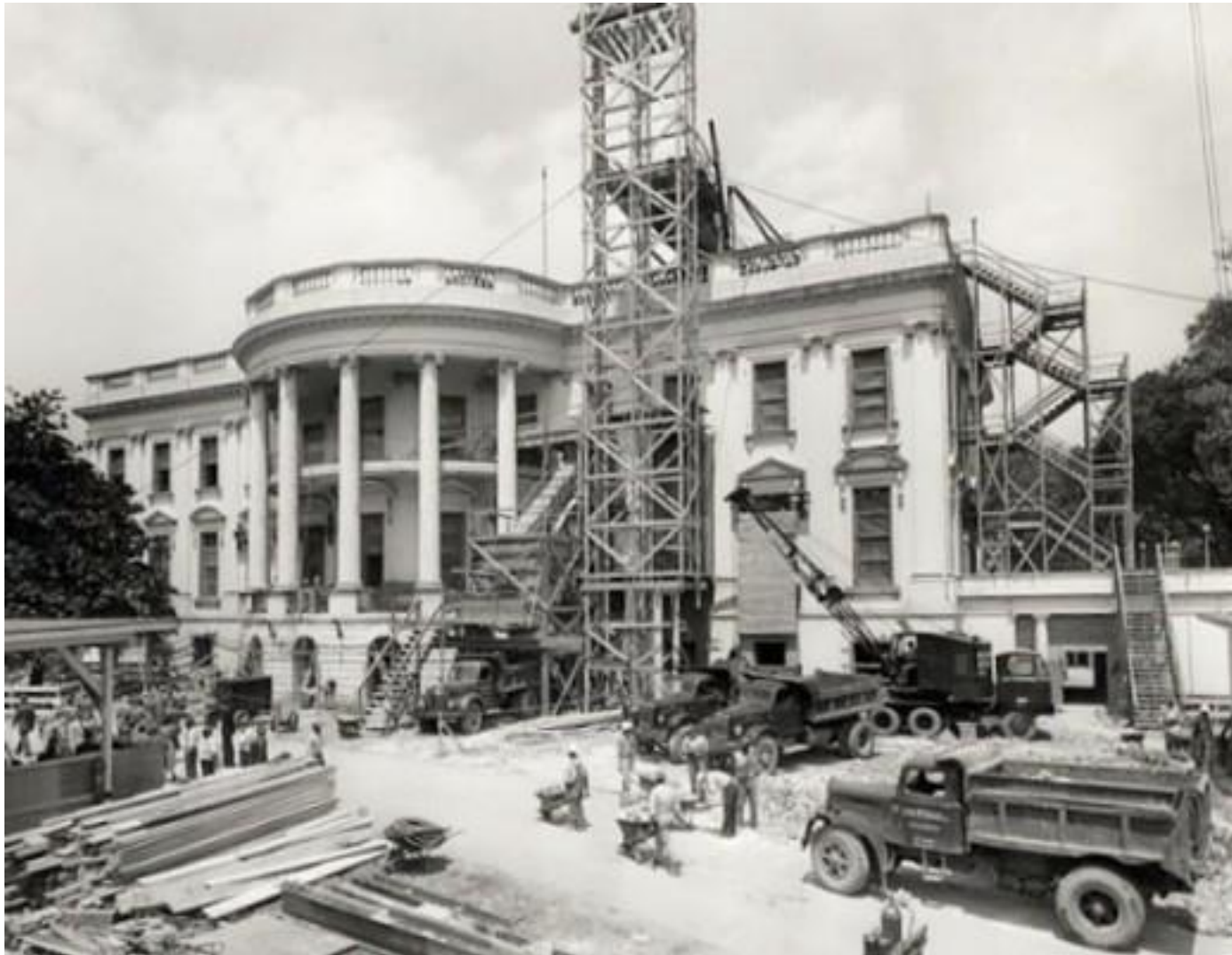
Отвод стального каркаса в Белом Доме, США, 1948-1952 г.
