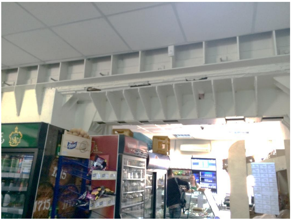
Устройство обоев, ригелей и просветов в несущей стене магазина в 8-этажном здании по ул. Артема 55, г. Киев
