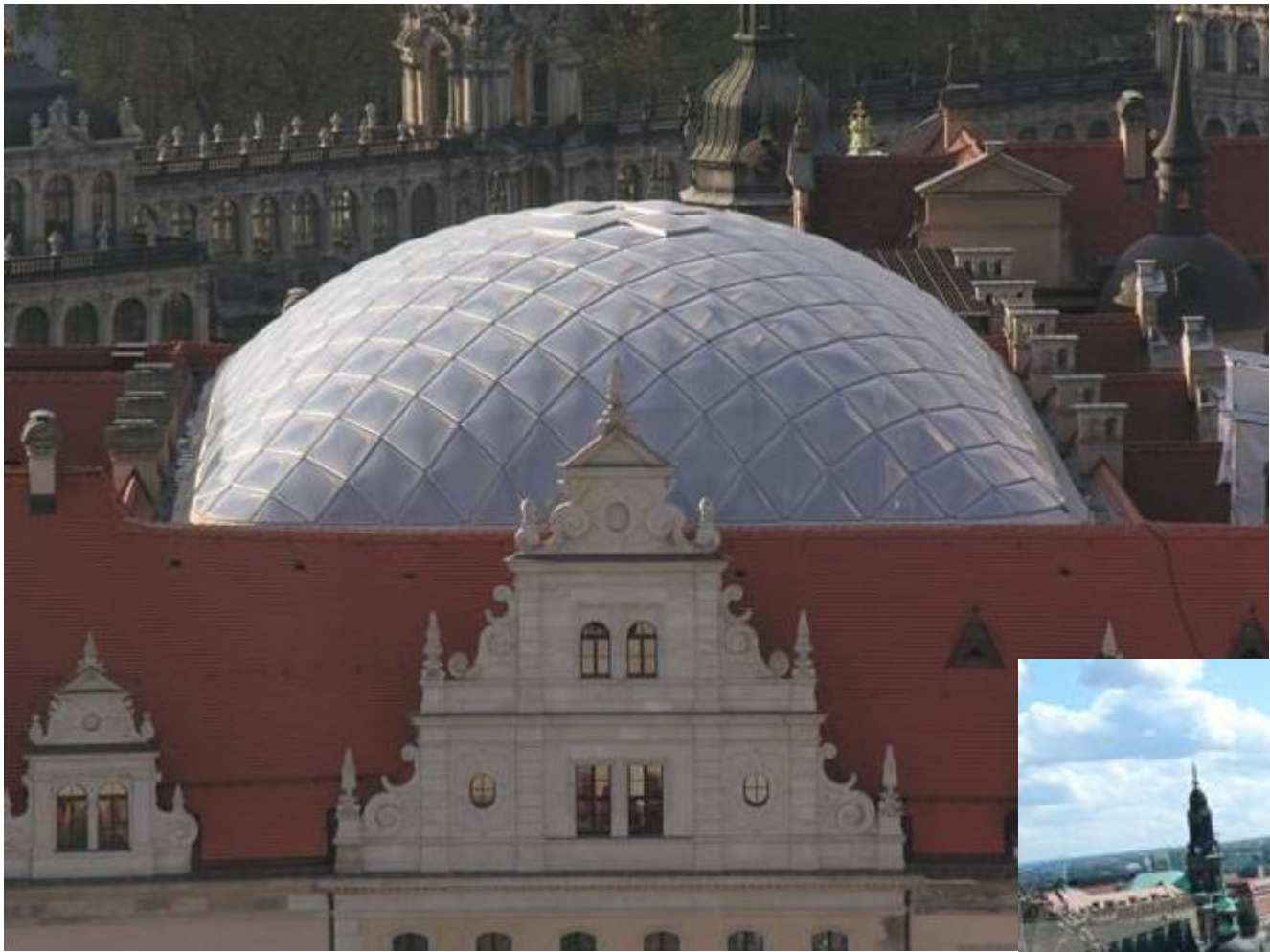
Устройство покрытия Дворца, г. Дрезден, Германия, 2007 г.
