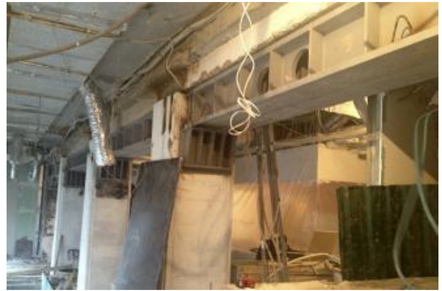
Подведение каркаса под аварийную стену и ригель в здании по ул. Крещатик 29, г. Киев, 2013 г.
