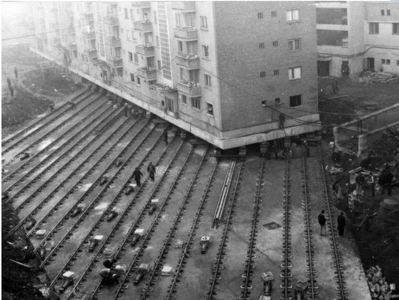
Перемещение 7600-тонной здания, г. Алба-Юлия, Румыния, 1987 г.
