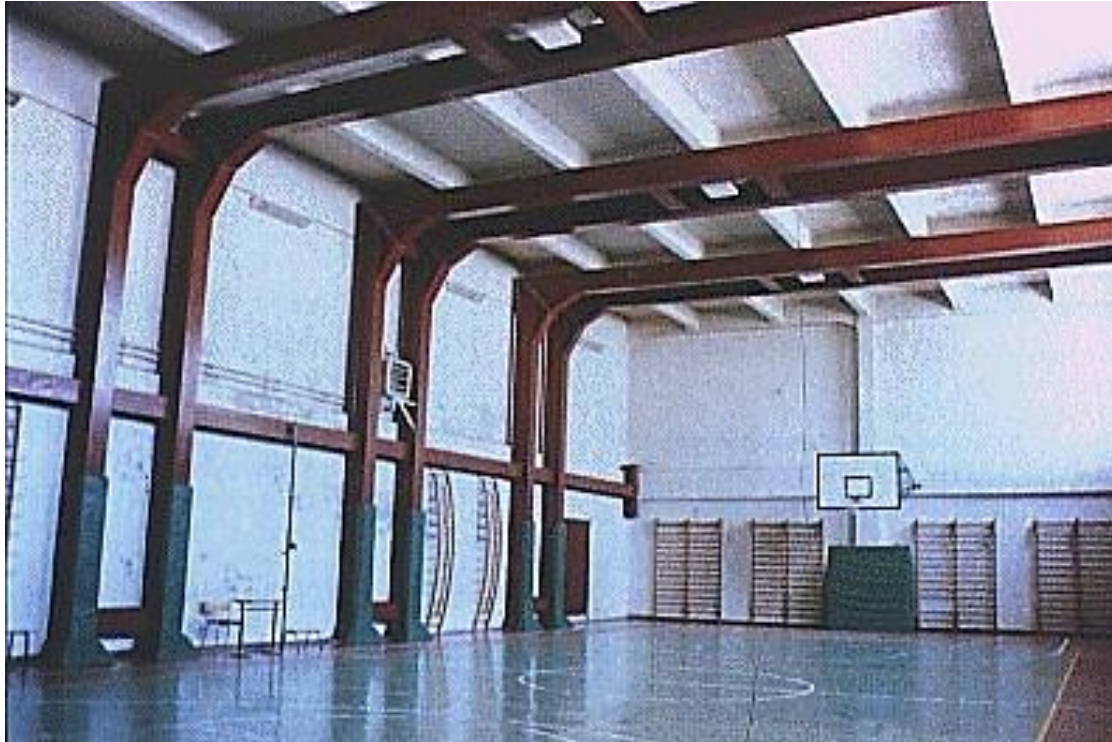
Усиление перекрытия металлическими рамами, г. Канту, Италия, 1990 г.
