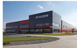
■ Завод AXOR, г. Днепрпетровск. Вес металлоконструкций – 1 500 т.
