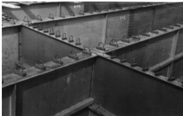
Стальные балки с приваренной арматурой для нового моста в Хердекке (1951г.) над рекой Рур, Германия
