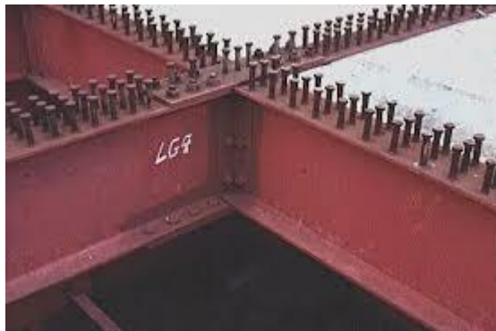
1. Сталежелезобетонная балка
