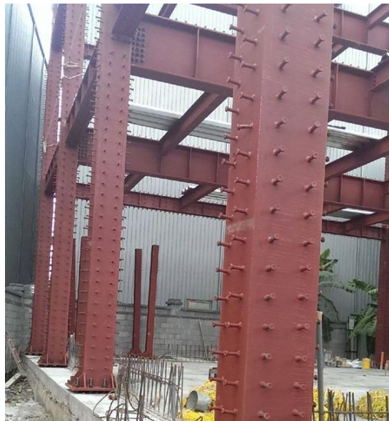
2. Сталежелезобетонная колонна
