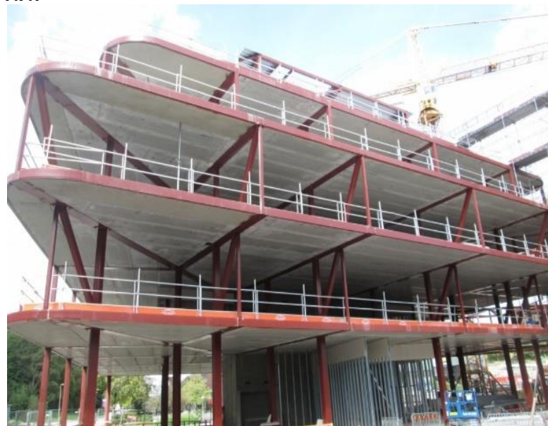
Пример перекрытий пониженной высоты на основе НQ- и WQ-балок
