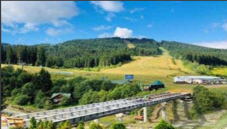
ТзОВ «ЛБС» Роботи з капітального ремонту лижного моста (піскоструменева очистка металевих конструкцій, фарбування металевих конструкцій, виготовлення та монтаж металевих конструкцій, влаштування бетонного перекриття) територія ТК «Буковель» 2020р.
