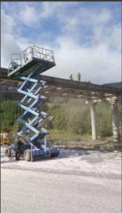
ТзОВ «ЛБС» Роботи з капітального ремонту лижного моста (піскоструменева очистка металевих конструкцій, фарбування металевих конструкцій, виготовлення та монтаж металевих конструкцій, влаштування бетонного перекриття) територія ТК «Буковель» 2020р.
