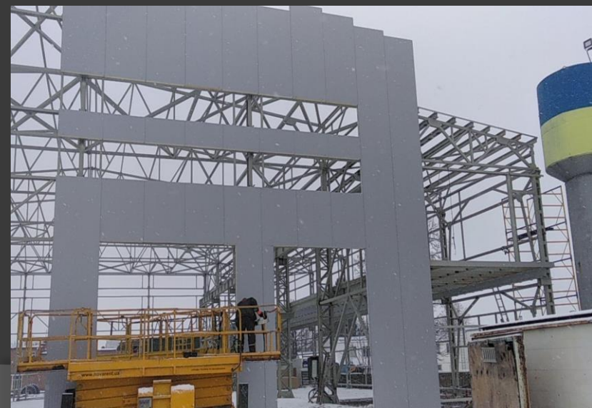
ТзОВ «ТАД-ТРАНС», Виготовлення мелоконструкцій, монтаж Сендвіч панелей виробничого цеху, (м. Волочиськ 2020- 2021р.)
