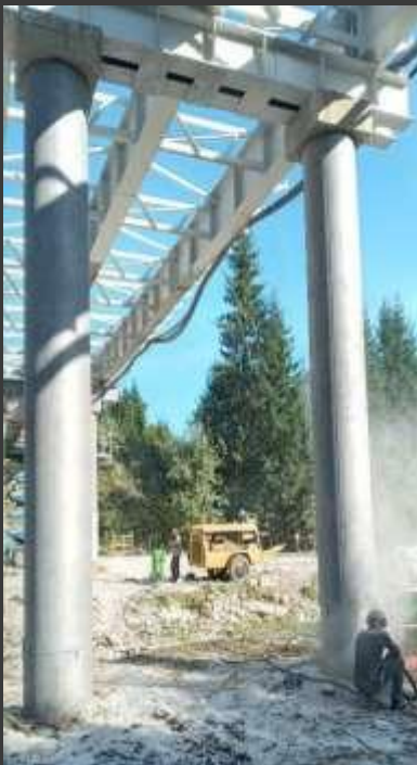
ТзОВ «ЛБС» Роботи з капітального ремонту лижного моста (піскоструменева очистка металевих конструкцій, фарбування металевих конструкцій, виготовлення та монтаж металевих конструкцій, влаштування бетонного перекриття) територія ТК «Буковель» 2020р.
