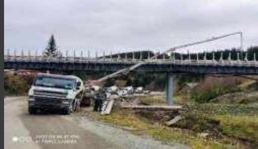
ТзОВ «ЛБС» Роботи з капітального ремонту лижного моста (піскоструменева очистка металевих конструкцій, фарбування металевих конструкцій, виготовлення та монтаж металевих конструкцій, влаштування бетонного перекриття) територія ТК «Буковель» 2020р.
