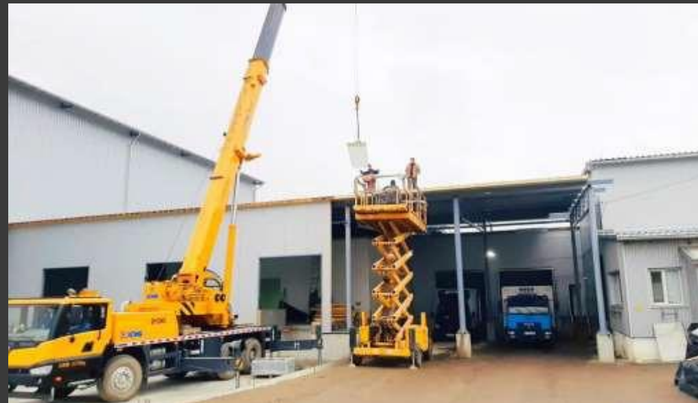
Фермерське господарство «Мгар» 2020-2021р. Влаштування покрівельних сендвіч панелей
