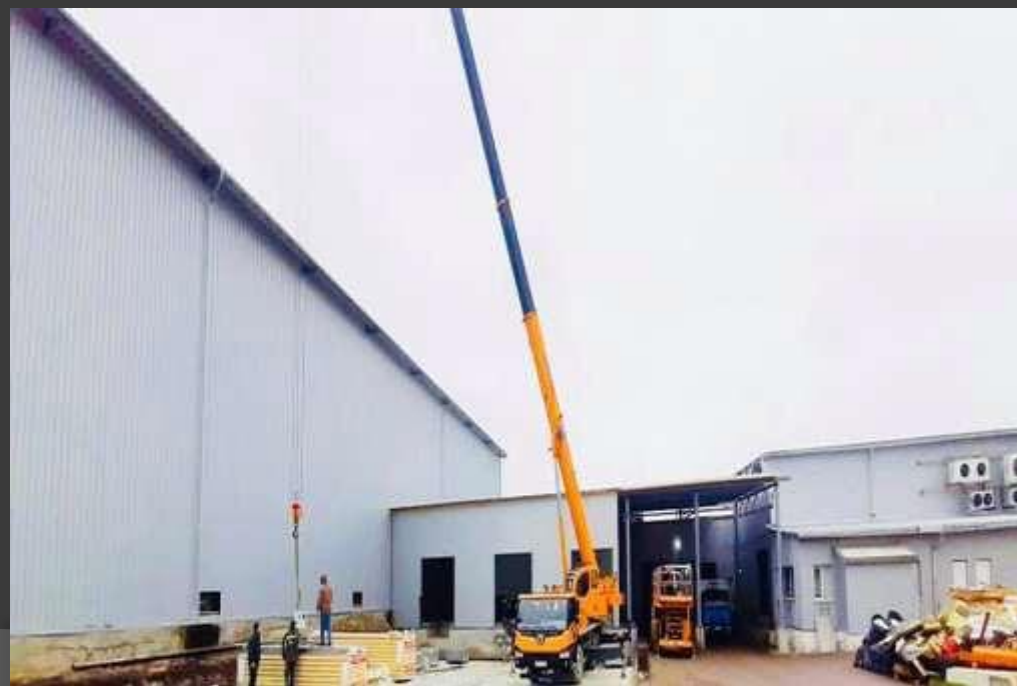
Фермерське господарство «Мгар» 2020-2021р. Влаштування покрівельних сендвіч панелей
