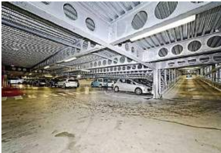
Рис.2.2. Приклад пропуску комунікацій через композитне перекриття з перфорованими балками
