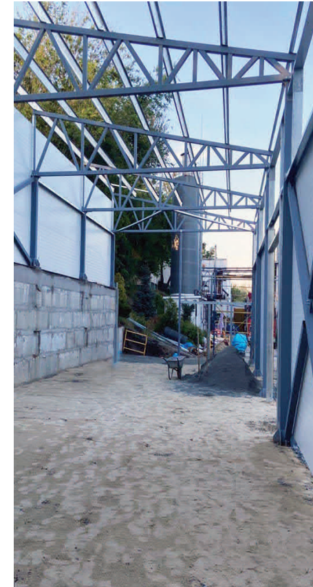
Складське приміщення м. Дніпро
