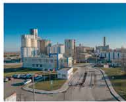
Одеський цементний завод ОСНОВА
