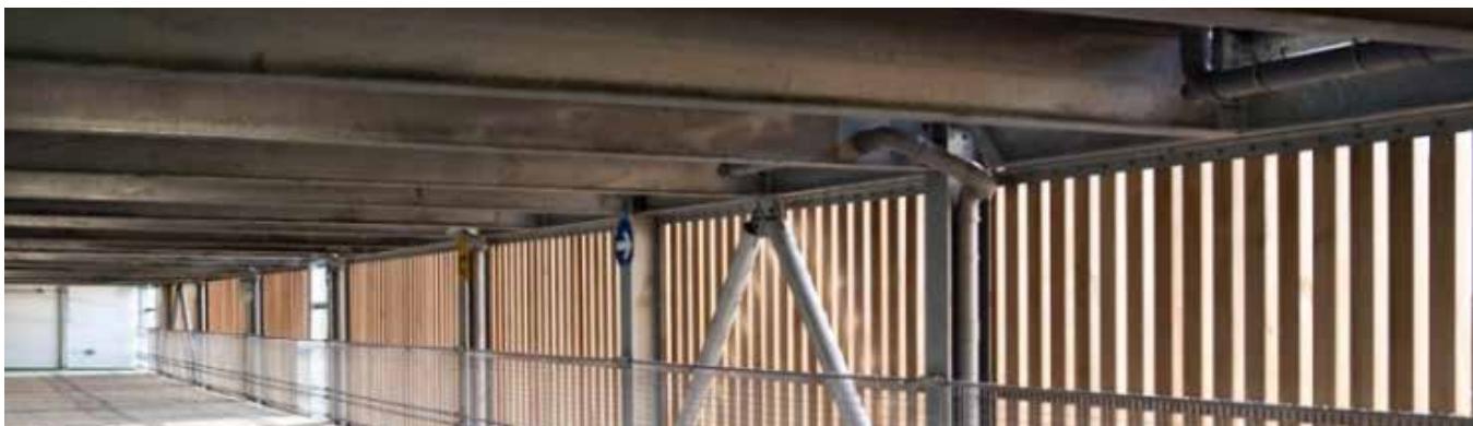
Рис. 1.2. Приклади сталезалізобетонних багатоповерхових паркінгів відкритого типу
