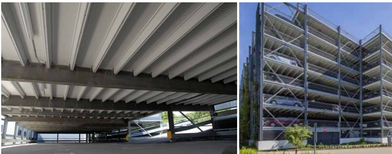
Рис. 1.1. Приклади сталезалізобетонних багатоповерхових паркінгів відкритого типу
