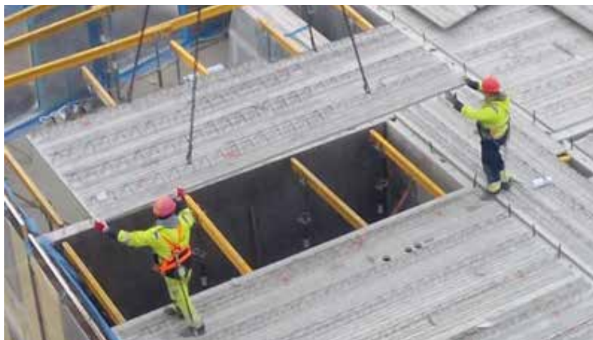
Рис. 3.3. Рішення з філігранними плитами як опалубкою для монолітних плит по сталевих балках: 1 – верхня арматура, 2 – просторові каркаси, 3 – філігранна плита, 4 – анкетування поздовжнього армування
