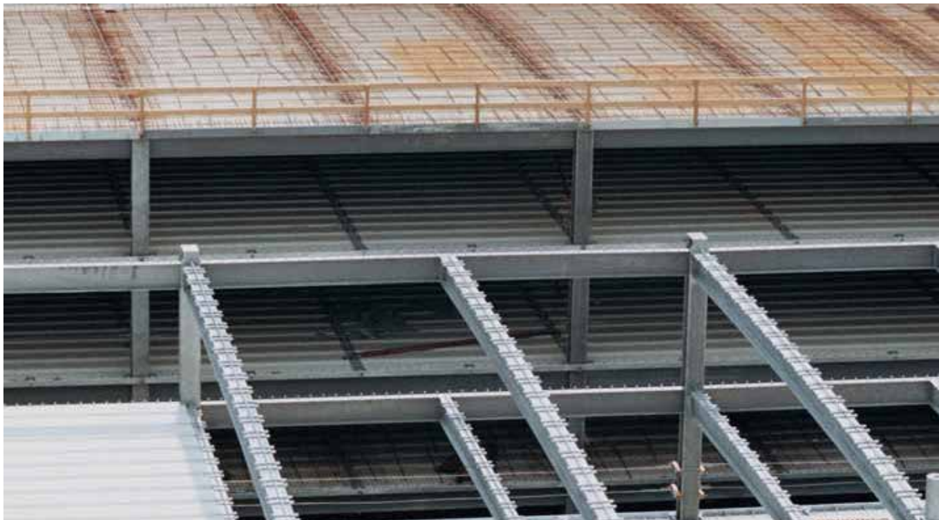
Рис. 2.1. Монтаж готових металоконструкцій і настилів без підкріплення опалубкою значно прискорює будівництво
