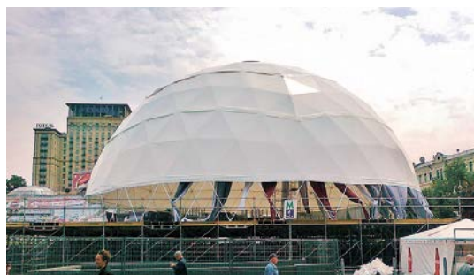
Рисунок 101. Временный геодезический купол из трубчатых элементов фан-зоны чемпионата Европы по футболу, Киев, Украина, 2012 год
