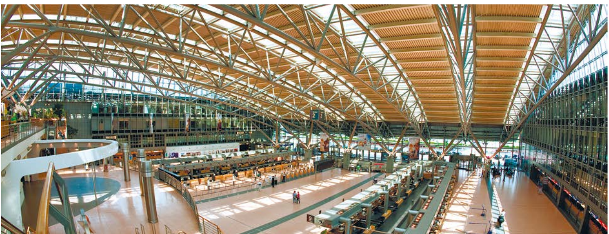
Рисунок 61. Развитая из плоскости трехгранная арочная ферма из труб с треугольной решеткой пролетом 62 м в аэропорту Гамбурга, Германия, архитектурное бюро GMP, конструктивный проект WEBER•POLL, 2005 год
