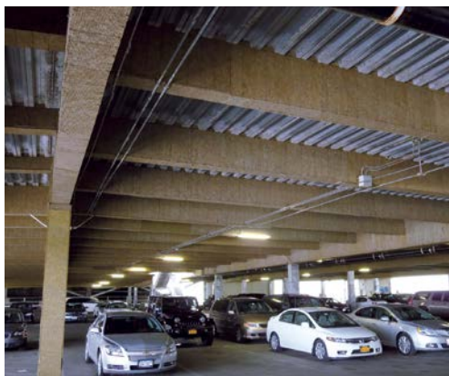
Рисунок 170. Применение плит для огнезащиты основных несущих конструкций
