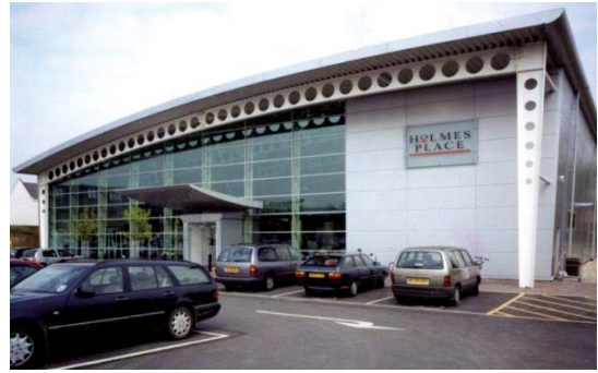
Рисунок 94. Рама со вставленным перфорированным ригелем и стойками переменного сечения фитнес-центра, Уимблдон, Англия, проект Brimelow McSweeney Architects, 2002 год
