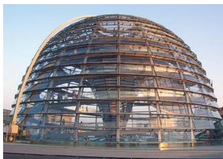
Рисунок 100. Ребристо-кольцевой купол над новым зданием Рейхстага, Берлин, Германия, архитектор Norman Foster, конструктивный проект бюро Arup/ Schlaich Bergemann & Partner/ Leonhardt Andrä & Partner, 1999 год
