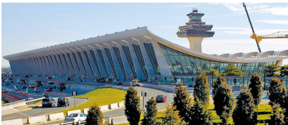
Рисунок 34. Однопоясная висячая система терминала международного аэропорта имени Даллеса в Вашингтоне, США, архитектор Eero Saarinen, конструктивный проект – бюро Ammann&Whitney, 1962 год
