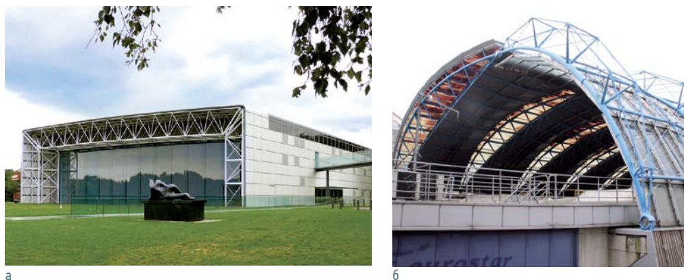
Рисунок 54. а – рамная ферменная конструкция Центра визуального искусства в Сэйнсбери, автор проекта Norman Foster, 1978 год; б – вантовые фермы покрытия железнодорожного терминала Waterloo, Лондон, Англия, проект бюро Nicholas Grimshaw, 1994 год
