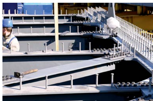
Рисунок 72. Заводские анкерные упоры болтового типа на композитных балках
