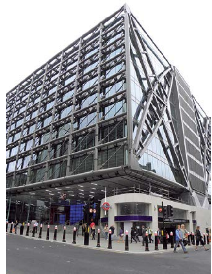
Рисунок 161. Конструктивная схема и фасад здания станции метро Cannon Street в Лондон, Англия, с консолями 21 м, проект бюро Foggo Associates, 2011 год: а – внутренний атриум; б – решетчатый фахверк; в – консольная часть; г – обетонированные опоры
