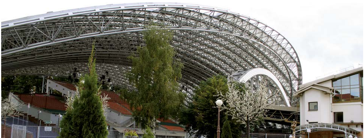
Рисунок 68. Структурное покрытие летнего амфитеатра, Витебск, Беларусь, архитектор Александр Зафатаев, конструктивный проект «Институт БелНИИС», 2007 год
