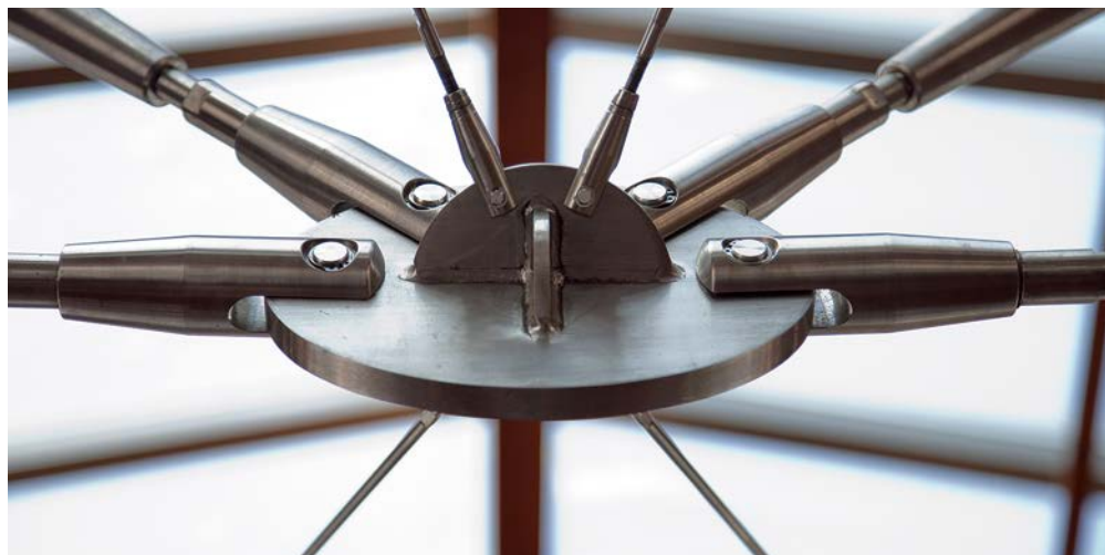
Рисунок 110. Пример узла с примыканием большого количества растянутых элементов
