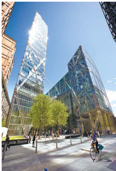
а. Внешняя ферма каркаса Broadgate Tower, Лондон, Англия, архитектура и конструктив – бюро Skidmore, Owings & Merrill, 2009 год
