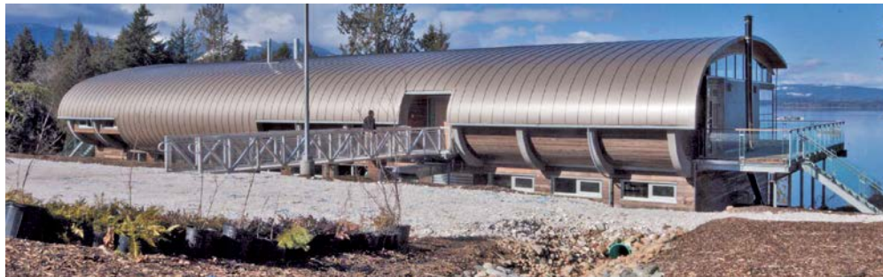
Рисунок 102. Ограждающая металлическая континуальная оболочка покрытия исследовательского центра университета Ванкувер, Канада, 2011 год
