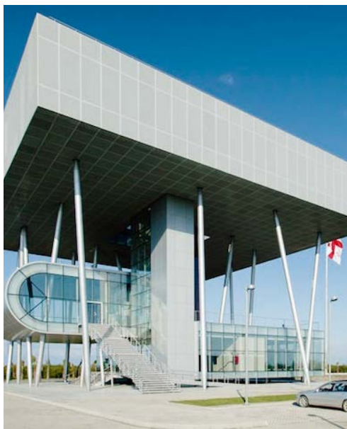
Рисунок 157. Консольные элементы фасадов и навесов в зданиях как конструктивные элементы архитектурной выразительности
