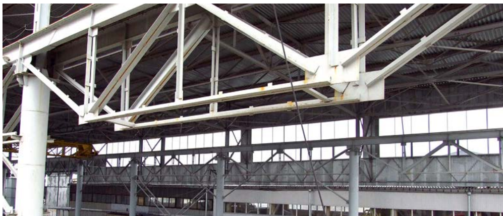
Рисунок 118. Примыкание элементов из парных уголков на фанонки в узлах фермы с верхним поясом из двутавров
