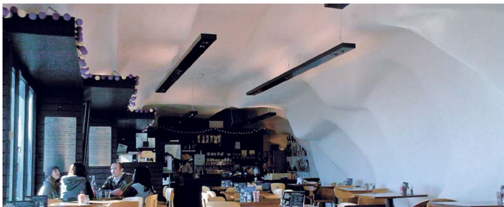
Рисунок 105. Сварная континуальная однослойная оболочка кафе East Beach, Littlehampton, Англия, архитектура Heatherwick Studio, конструктивный проект Adams Kara Taylor, 2005 год
