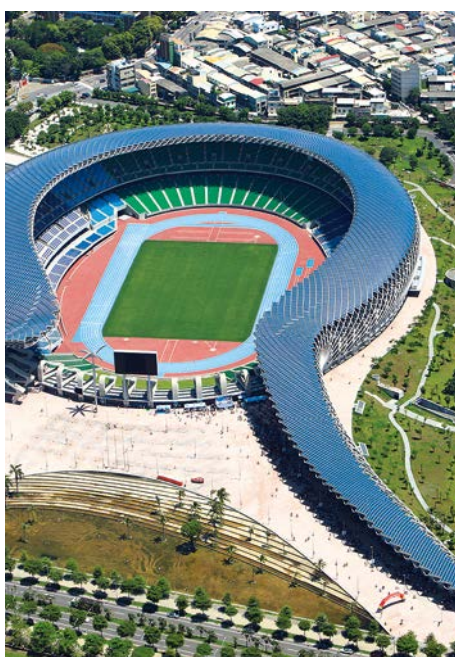
Рисунок 106. Сетчатая оболочка стадиона Kaohsiung с покрытием из солнечных батарей, Тайвань, проект Toyo Ito, 2009 год
