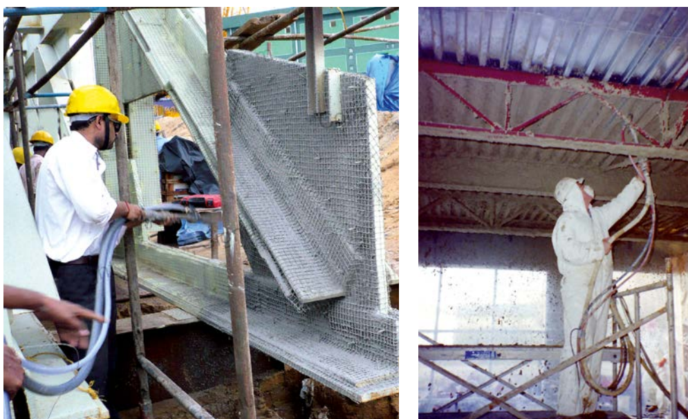
Рисунок 169. Напыление огнезащитного покрытия на пролетные конструкции
