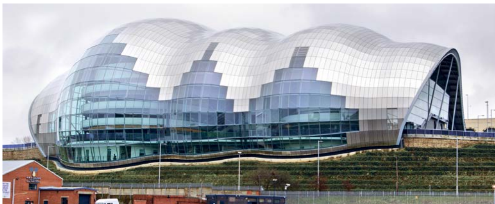
Рисунок 103. Сетчатая оболочка Центра искусства The Sage Gateshead, Гейтсхед, Англия, архитектурное бюро Foster + Partners, конструктивный проект Mott MacDonald, 2004 год
