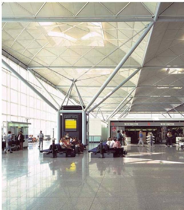
Рисунок 88. Сквозная опора из четырех ветвей трубчатого сечения структурного покрытия аэропорта Станстед, Англия, архитектурное бюро Foster + Partners, конструктивный проект Ove Arup & Partners, 1991 год
