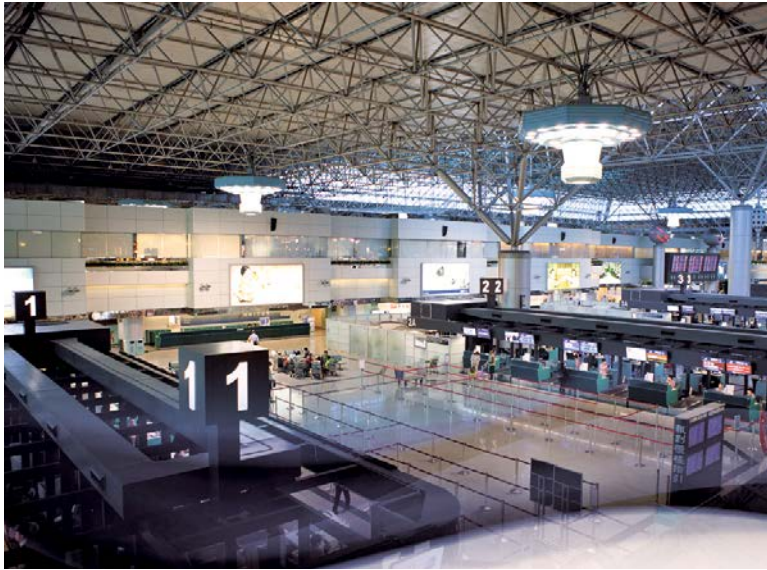
Рисунок 66. Структурное покрытие пассажирского терминала аэропорта Тайпей с размерами 210x170 м, Китай, проект Norihiko Dan, 1997 год
