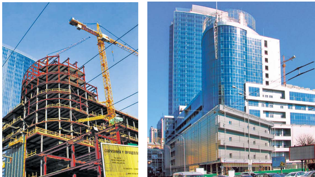
Рисунок 31. Компоновка балок перекрытий и внешний вид торгово-офисного центра Gulliver, Киев, Украина, архитектор Татьяна Григорова, конструктив Украинский институт стальных конструкций имени В.Н. Шимановского, 2013 год
