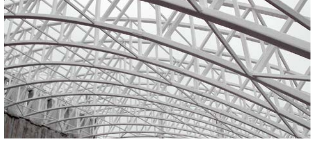
Рисунок 58. Стальные фермы с криволинейным абрисом пентаусов высотного жилого комплекса «Мегасити», Киев, Украина, архитектор Виктор Дубок, конструктив КНУСА, 2009 год
