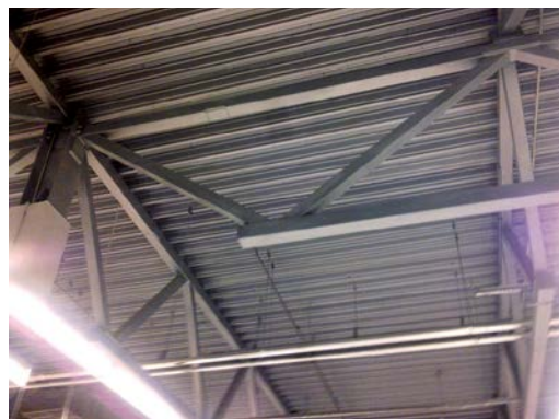
Рисунок 120. Крайние узлы примыкания раскосов к нижнему поясу в бесфасоночных фермах из труб и гнутосварных замкнутых профилей
