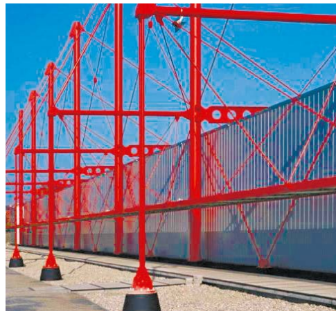
Рисунок 24. Складское здание с полностью внешним каркасом, организованным путем применения гибких вантовых элементов
