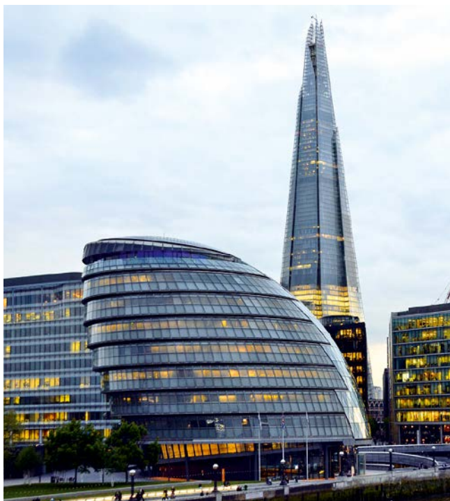
Рисунок 2. Макроуровень архитектурной выразительности – градостроительный. Широкий диапазон визуальных форм, реализованный в стальных каркасах офисного квартала на южном берегу Темзы, Лондон, Англия, который венчает The Shard высотой 309 м, архитектор Renzo Piano, конструкторское бюро WSP Cantor Seinuk, 2012 год
