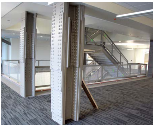
Рисунок 133. Монтажный стык двутавровых колонн на высокопрочных болтах
