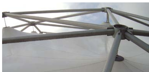
Рисунок 141. Примеры узлов однополюсных геодезических куполов: а – без узловых деталей при диаметре до 20 м; б – с узловыми деталями при больших пролетах
