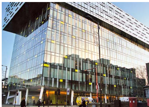
Рисунок 25. Наклонные стальные колонны входной группы и выступающие верхние этажи здания Palestra, Саутварк, Лондон, Англия (слева), конструкции верхнего этажа (справа). Архитектурное бюро Alsop, конструктив – Buro Happold, 2006 год
