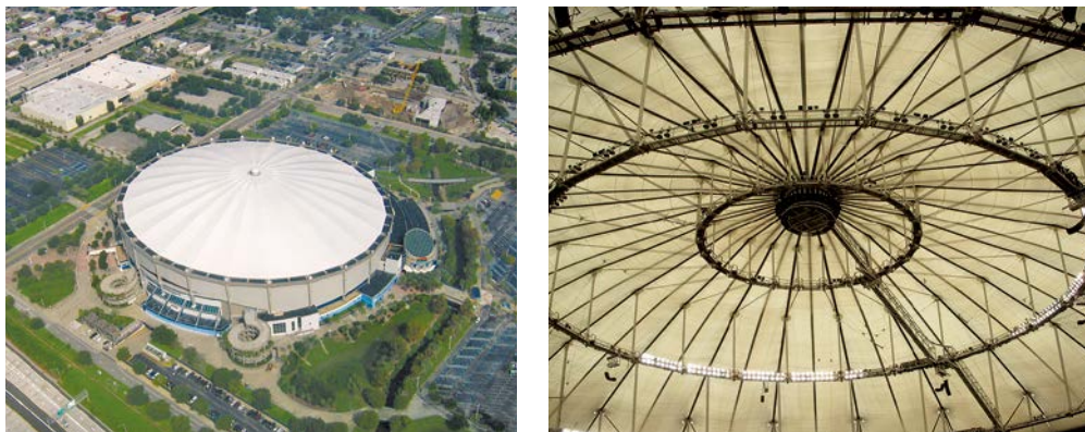
Рисунок 38. Двухъярусная система стадиона Tropicana Field, Сент-Питерсберг, США диаметром 270 м, архитектурное бюро Populous, конструктивный проект бюро Geiger Engineers P.C., 1990 год
