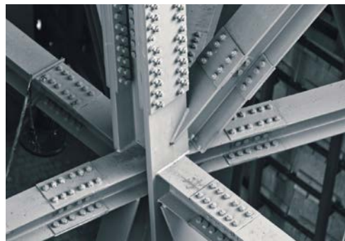
Рисунок 128. Монтажные стыки балок с накладками и фрикционными соединениями на высокопрочных болтах
