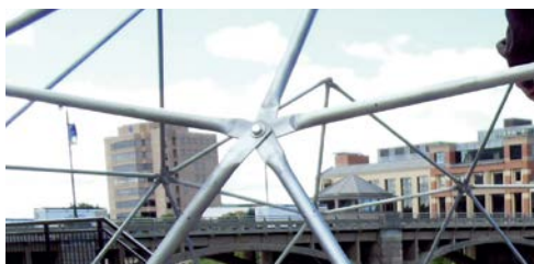
Рисунок 141. Примеры узлов однополюсных геодезических куполов: а – без узловых деталей при диаметре до 20 м; б – с узловыми деталями при больших пролетах
