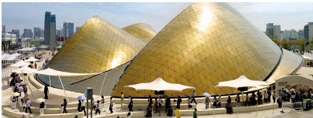
Рисунок 65. Однослойная стержневая оболочка павильона ОАЭ на выставке Экспо-2010 в Шанхае, Китай, архитектурное бюро Foster+Partners, конструктивный проект бюро Halvorson and Partners
