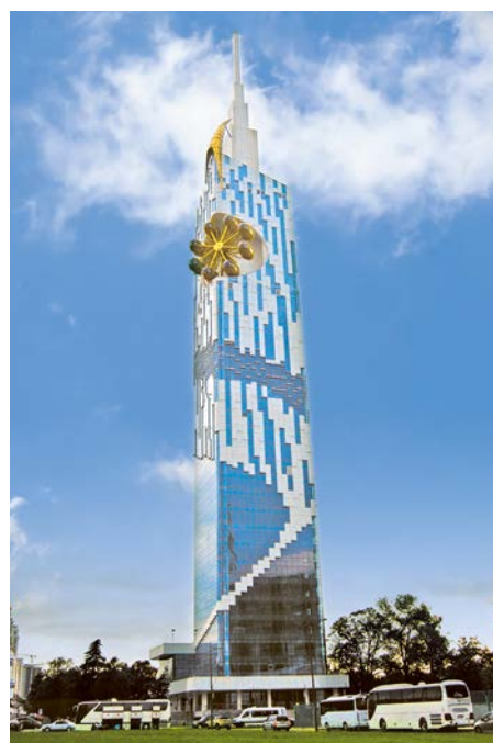
Рисунок 26. Стальное консольное колесо обозрения в высотном здании технологического университета в Батуми, Грузия, архитектор Давид Гогичаишвили, конструктив Вартість, Аналог (В. Архипов, А.Билык, С.Билык, Украина) 2012 год
