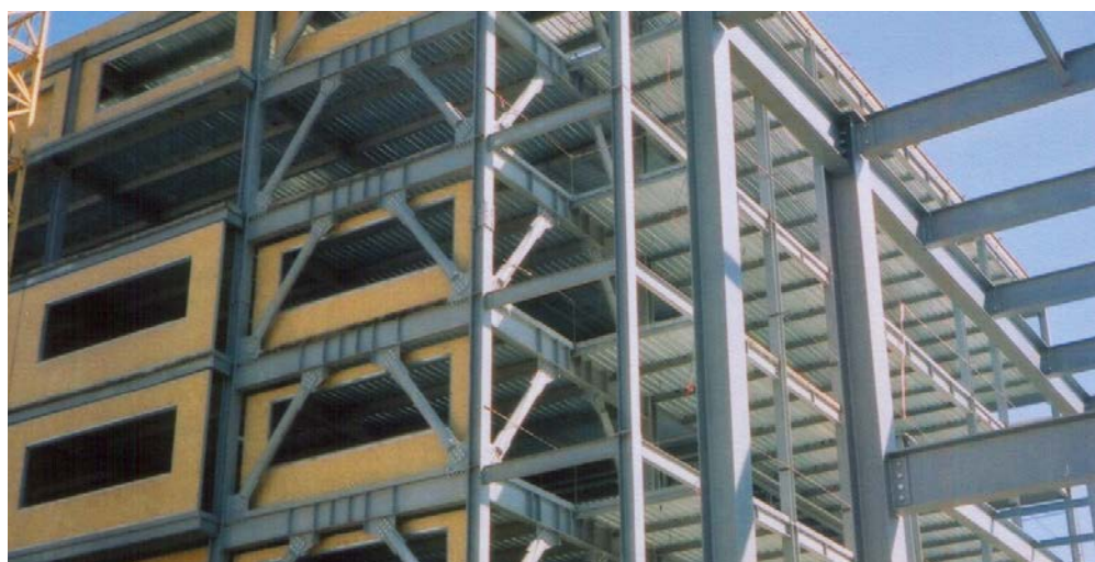
Рисунок 46. Вертикальные треугольные связи в многоэтажном офисном здании
