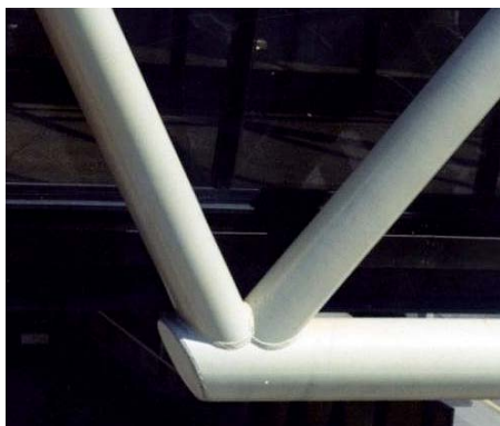
Рисунок 120. Крайние узлы примыкания раскосов к нижнему поясу в бесфасоночных фермах из труб и гнутосварных замкнутых профилей
