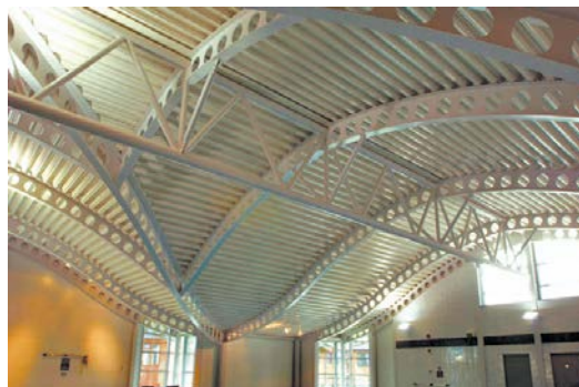
Рисунок 80. Использование криволинейных перфорированных балок в помещении автосалона
