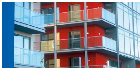
Рисунок 152. Самонесущие переходы и балконы с внешним каркасом, используемые в жилом здании
