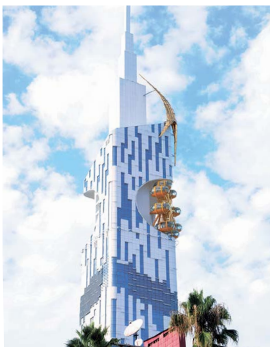
Рисунок 26. Стальное консольное колесо обозрения в высотном здании технологического университета в Батуми, Грузия, архитектор Давид Гогичаишвили, конструктив Вартість, Аналог (В. Архипов, А.Билык, С.Билык, Украина) 2012 год
