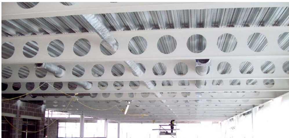
Рисунок 172. Внешний вид балочного композитного перекрытия с нанесенным огнезащитным покрытием
