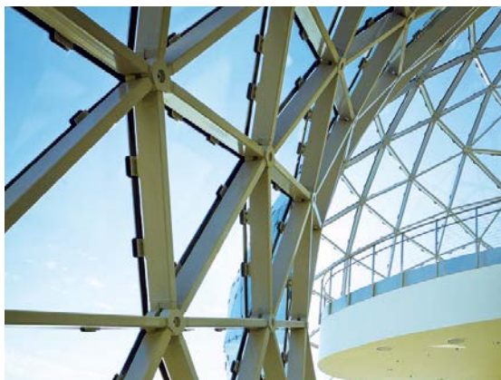
Рисунок 140. Сетчатый купол из гнутосварных профилей с узловыми выточенными элементами; схема узлового примыкания на накладке с фиксирующей шпилькой
