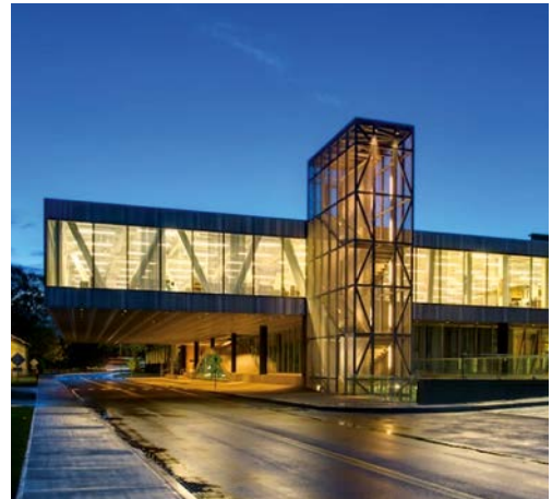
Рисунок 160. Здание Milstein Hall на о. Итака, Нью-Йорк, США с консолью 18 м, проект Cornell University, 2011 год
