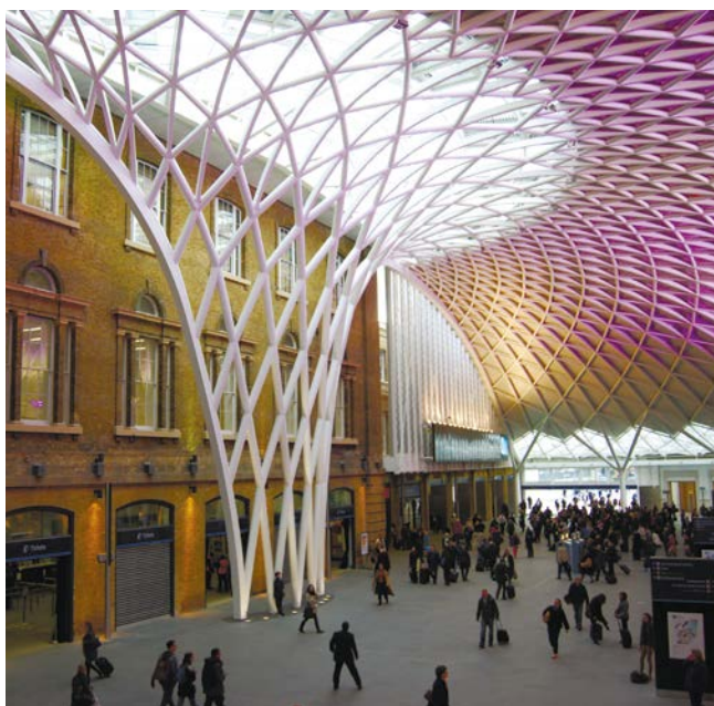
Рисунок 4. Мезоуровень – архитектурный. Структурная оболочка, используемая в главном вестибюле лондонского железнодорожного вокзала King's Cross, Лондон, Англия, архитектурное бюро John McAslan + Partners, конструктивный проект от бюро Arup, 2012 год
