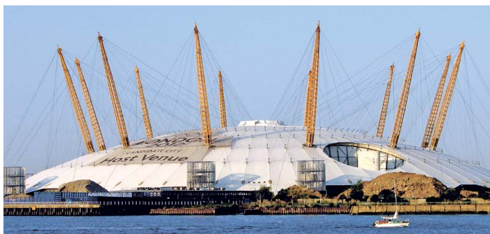
Рисунок 37. Висячая вантовая система с тентовым покрытием центра Millennium Dome диаметром 365 м, Лондон, Великобритания, архитектор Richard Rogers, конструктивный проект Buro Happold, 1999 год
