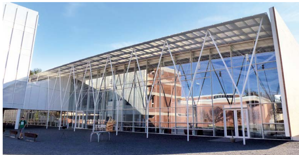
Рисунок 22. Наружные колонны с треугольными стержневыми капителями здания университета Clemson, США, архитектурное бюро Thomas Phifer and Partners, конструктивный проект – бюро Skidmore, Owings & Merrill, 2013 год
