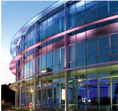
Рисунок 49. Гибкие крестовые связи внешних несущих конструкций фасада в культурно-развлекательном комплексе на площади Славы, Киев, Украина, архитектурное бюро «С. Бабушкин», 2004 год
