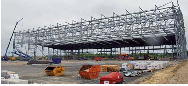
Рисунок 57. Авиационный ангар с фермами пролетом 125 м в аэропорту Stansted, архитектура бюро Foster + Partners, конструктив бюро Arup, 1991 год
