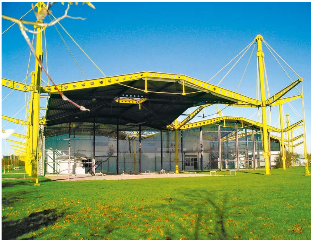
Рисунок 1. Дистрибьюторский центр Renault Parts Distribution Centre, Суиндон, Англия, архитектурное бюро Foster + Partners, конструкторское бюро Ove Arup & Partners, 1982 год
