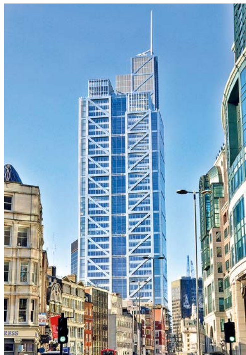
б. Внешний каркас высотного здания Heron Tower, Лондон, Англия, архитектурное бюро Kohn Pedersen Fox, конструктивный проект – бюро Arup, 2011 год
