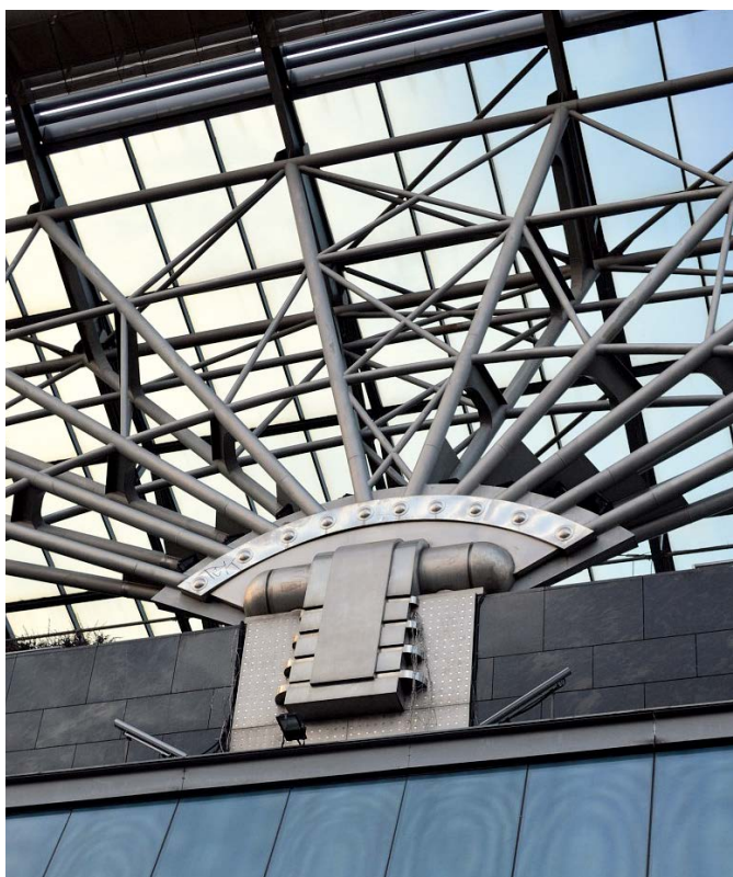
Рисунок 7. Микроуровень - дизайн элементов среды. Центральный узел крепления несущих элементов кровли торгового центра Westend City в Будапеште, Венгрия, создает визуальный акцент для здания, усиленный декоративной накладкой, архитектура бюро Finta, конструктив Jerde Partnership, 1999 год
