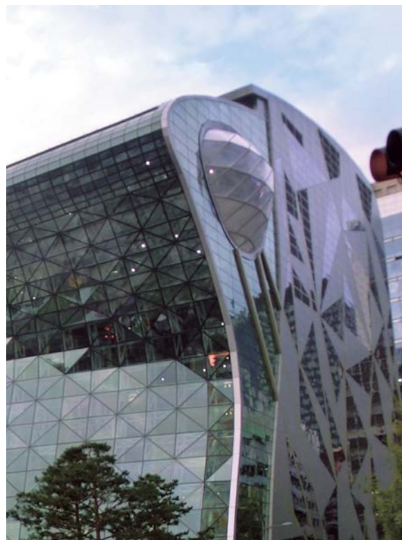
Рисунок 154. Фахверковые фермы стеклянного фасада Seoul City Hall, Южная Корея, проект Heerim Architects & Planners Co., 2012 год
