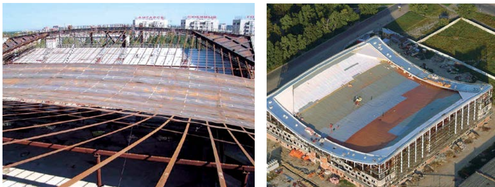
Рисунок 41. Мембранное покрытие конькобежного стадиона 200x110 м, Коломна, Российская Федерация, архитектор Александр Годер, конструкторы Нодар Канчели, Дмитрий Дробот, Павел Батов, 2005 год
