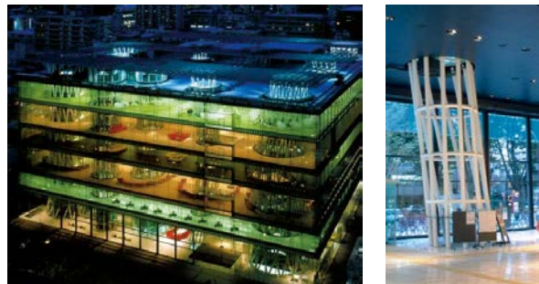
Рисунок 84. Сквозные колонны из труб Медиатеки, Сендай, Япония, проект Toyo Ito & Associates, 2001 год
