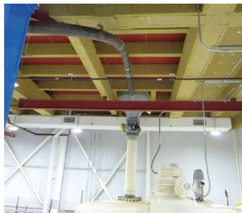
Рисунок 170. Применение плит для огнезащиты основных несущих конструкций
