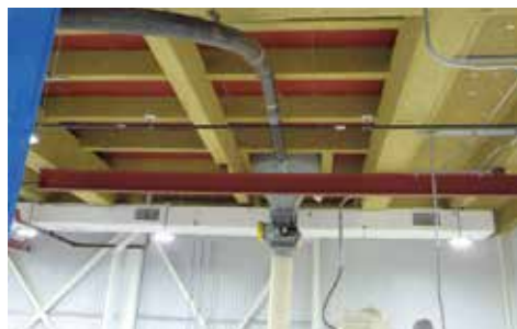
Рисунок 170. Применение плит для огнезащиты основных несущих конструкций
