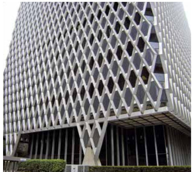
Рисунок 87. Опоры структурной несущей оболочки фасада многоэтажного здания Объединения Сталестроителей, г. Питсбург, архитектура и конструктив бюро Curtis and Davis, 1963 год
