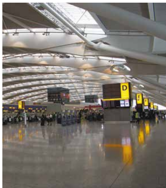
Рисунок 5. Мезоуровень – архитектурный. Пологое арочное покрытие с затяжкой пролетом 120 м над терминалом №5 в аэропорту Хитроу, Лондон, Англия, архитектор Richard Rogers, конструктивный проект от бюро Arup, 2008 год
