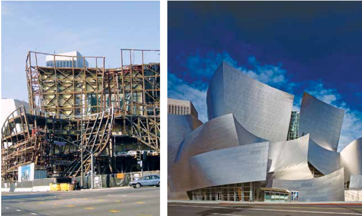
Рисунок 20. Несущий каркас и внешняя оболочка концертного зала им. Уолта Диснея, Лос Анжелес, США, архитектор Frank Gehry, конструктивный проект – бюро John A. Martin & Associates, 2003 год
