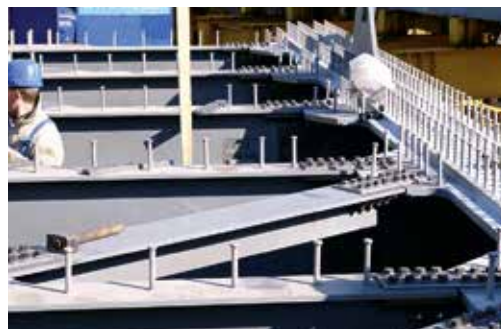
Рисунок 72. Заводские упорные анкеры на композитных балках
