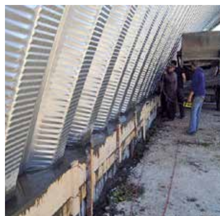
Рисунок 142. Тонколистовая оболочка спортивного зала: опорные узлы с контурным уголком и последующей гидроизоляцией и бетонированием
