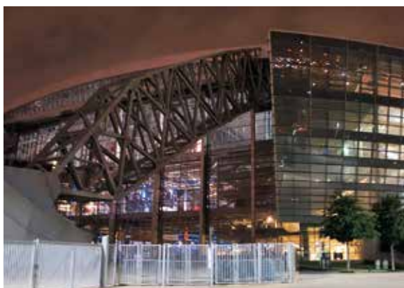
Рисунок 139. Опорный узел главной арки высотой 90 м трансформируемой кровли стадиона, Арлингтон, США, архитектурное бюро HKS, конструктивный проект бюро Walter P. Moore и Campbell&Associates Consulting Engineers, 2009 год
