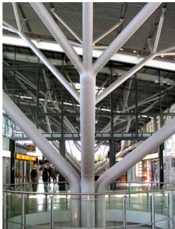
Рисунок 89. Стальные колонны аэропорта, Штутгарт, Германия, с разветвленными капителями оголовков для распределенного поддержания перекрытия, проект бюро von Gerkan, Marg und Partner, 2004 год
