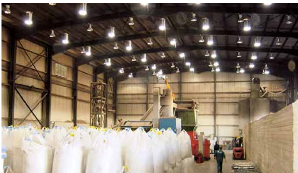
Рисунок 91. Однопролетное здание с рамным каркасом и зенитным освещением при помощи солнцедодов
