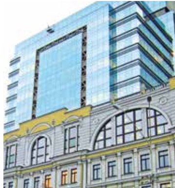
Рисунок 50. Открытые связи фасадной системы офисного центра «Леонардо», Киев, Украина, архитектурный и конструктивный проект бюро «С. Бабушкин», 2008 год
