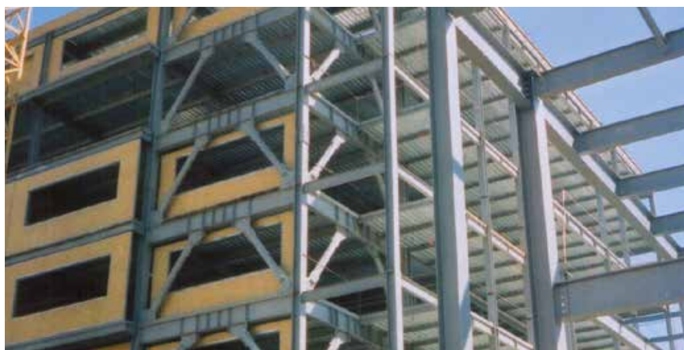
Рисунок 46. Вертикальные треугольные связи в многоэтажном офисном здании
