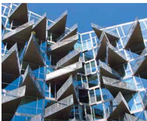
Рисунок 157. Консольные элементы фасадов и навесов в зданиях как конструктивные элементы архитектурной выразительности
