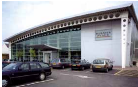
Рисунок 94. Рама со вспарушенным перфорированным ригелем и стойками переменного сечения фитнес-центра, Уимблдон, Англия, проект Brimelow McSweeney Architects, 2002 год
