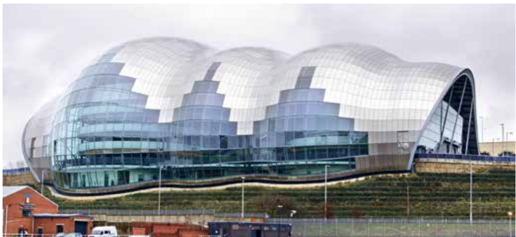
Рисунок 103. Сетчатая оболочка Центра искусства The Sage Gateshead, Гейтсхед, Англия, архитектурное бюро Foster + Partners, конструктивный проект Mott MacDonald, 2004 год
