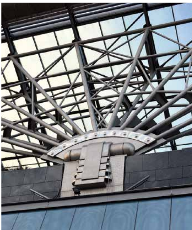
Рисунок 7. Микроуровень – дизайн элементов среды. Центральный узел крепления несущих элементов кровли торгового центра Westend City в Будапеште, Венгрия, создает визуальный акцент для здания, усиленный декоративной накладкой, архитектура бюро Finta, конструктив Jerde Partnership, 1999 год
