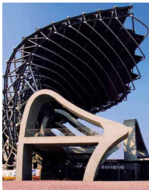
Рисунок 106. Сетчатая оболочка стадиона Kaohsiung с покрытием из солнечных батарей, Тайвань, проект Toyo Ito, 2009 год
