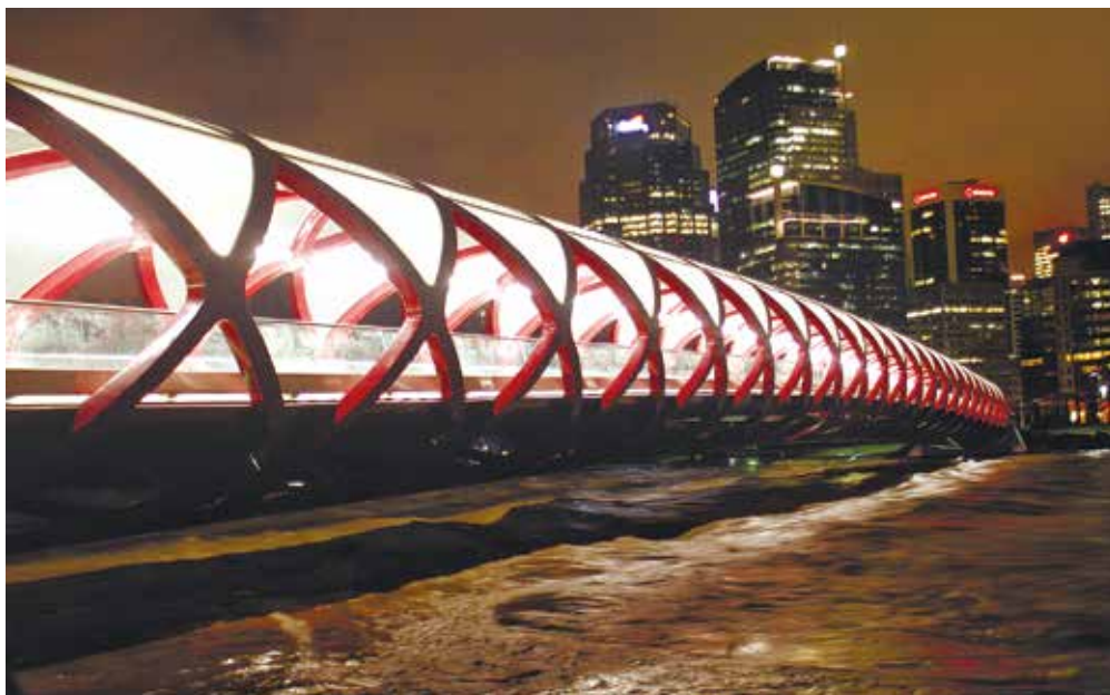
Рисунок 10. Цельносварной пешеходный «Мост Мира» пролетом 126 м, Калгари, Канада, архитектор и конструктор Santiago Calatrava, 2010 год
