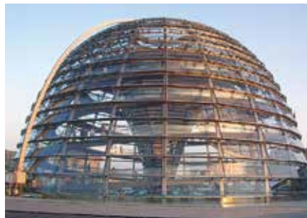
Рисунок 100. Ребристо-кольцевой купол над новым зданием Рейхстага, Берлин, Германия, архитектор Norman Foster, конструктивный проект бюро Arup/ Schlaich Bergermann & Partner/ Leonhardt Andrä & Partner, 1999 год
