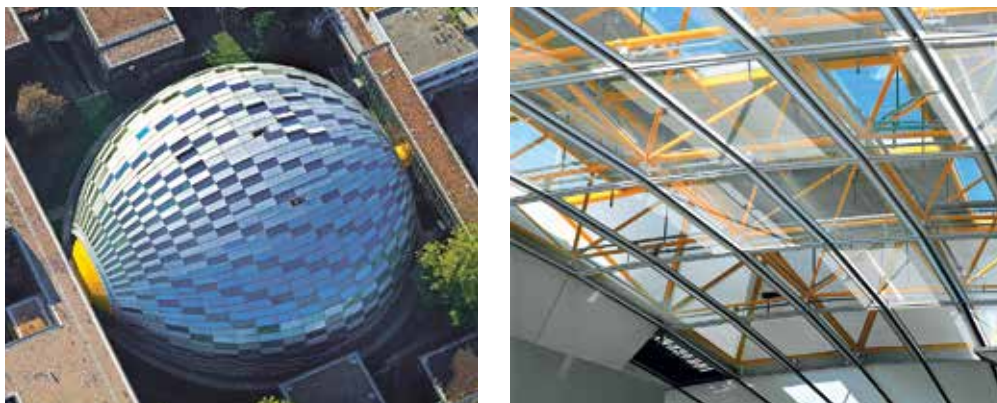
Рисунок 104. Внешний вид и открытые элементы каркаса сетчатого купола Свободного университета, Берлин, Германия, архитектурное бюро Foster + Partners, конструктивный проект Pichler Ingenieure, 2005 год
