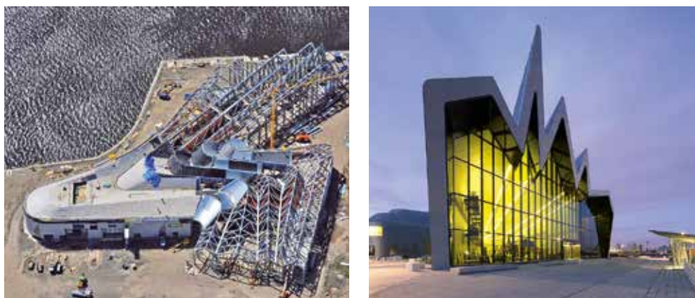
Рисунок 63. Складчатое пространственное стержневое покрытие музея транспорта Riverside в Глазго, Шотландия, архитектор Zaha Hadid, конструктивный проект Büro Happold, 2012 год
