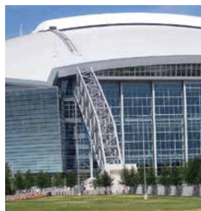
Рисунок 139. Опорный узел главной арки высотой 90 м трансформируемой кровли стадиона, Арлингтон, США, архитектурное бюро HKS, конструктивный проект бюро Walter P. Moore и Campbell&Associates Consulting Engineers, 2009 год
