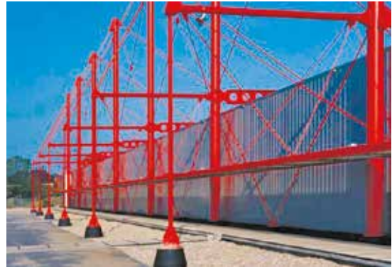
Рисунок 24. Складское здание с полностью внешним каркасом, организованным путем применения гибких вантовых элементов
