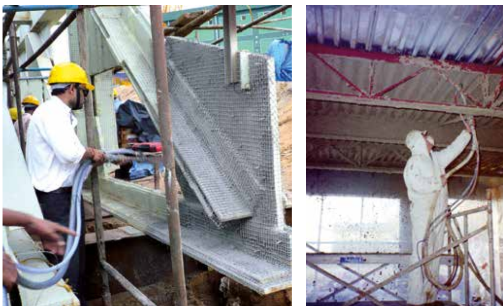
Рисунок 169. Напыление огнезащитного покрытия на пролетные конструкции
