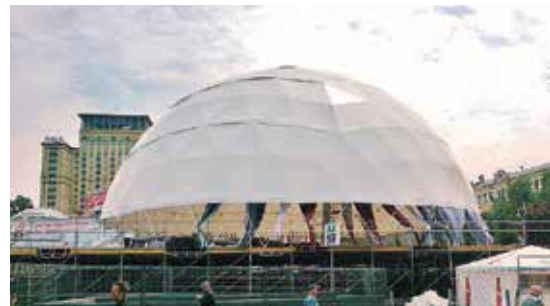
Рисунок 101. Временный геодезический купол из трубчатых элементов фан-зоны чемпионата Европы по футболу, Киев, Украина, 2012 год
