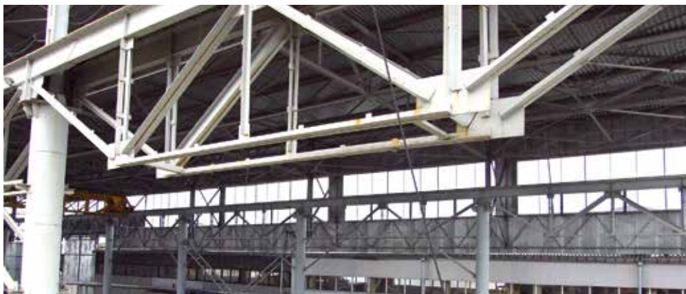
Рисунок 118. Примыкание элементов из парных уголков на фансонки в узлах фермы с верхним поясом из двутавров
