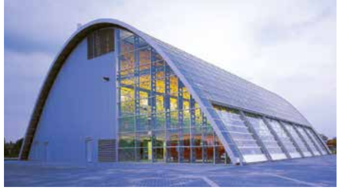
Рисунок 98. Каркас пожарного депо с использованием металлических арок и перфорированных фахверковых колонн, Хоутен, Голландия, проект Samyn&Partners, 2000 год
