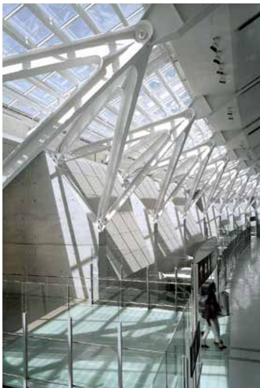
Рисунок 6. Микроуровень – дизайн элементов среды. Стальные опоры как элемент конструкции крыши и одновременно интерьера в аэропорту Toronto Lester Pearson, Торонто, Канада, архитектура бюро Moshe Safdie and Associates, конструктив бюро Skidmore, Owings and Merrill, 2004 год
