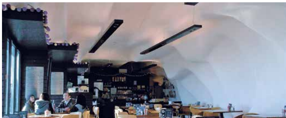
Рисунок 105. Сварная континуальная однослойная оболочка кафе East Beach, Littlehampton, Англия, архитектор Heatherwick Studio, конструктивный проект Adams Kara Taylor, 2005 год
