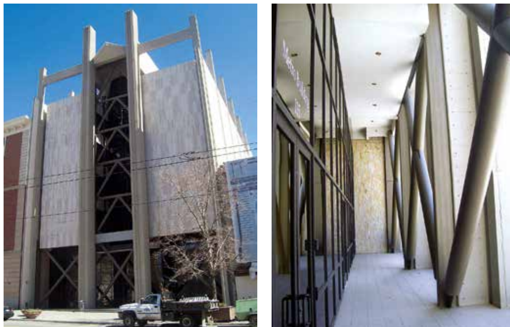
Рисунок 116. Открытые узлы крестовых и треугольных (К-подобных) связей, формирующие внешний облик здания Федерального резерва в Salt Lake City, США, 2006 год
