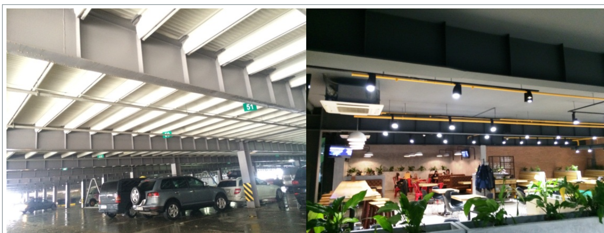
Рис. 2.23. Перепланування частини діючої багатоповірхової автостоянки зі сталевими композитними балками і плитами по профнастилу під ресторан завдяки реалізації великопролітного безколонного планування (Буковель, Україна)
