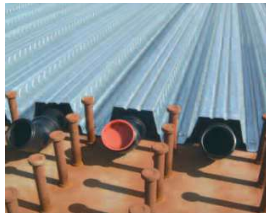
(4) пропуск труб сквозь гофр настила
