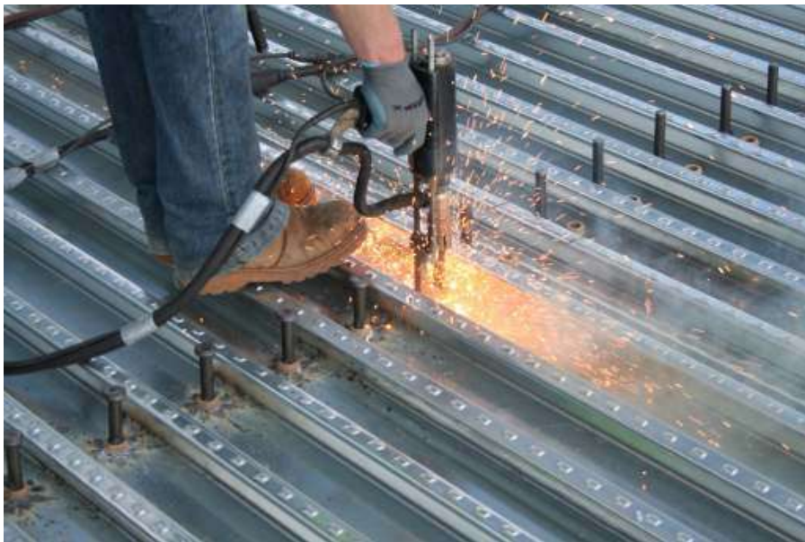
Рисунок 8.29. Приварка ряда стад-болтов непосредственно через профнастил
