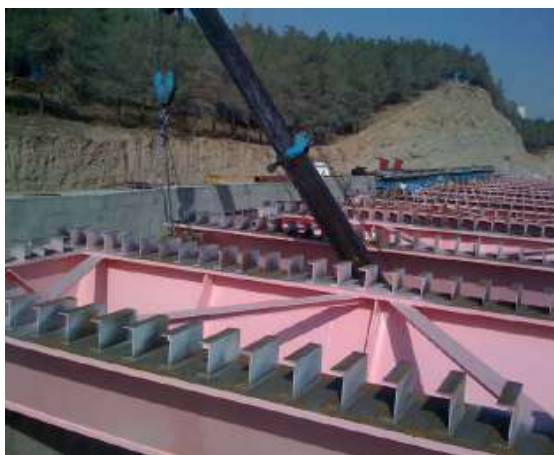
Рисунок 5.43. Примеры гибких упоров в виде прокатных швеллеров без подкрепляющих ребер
