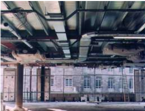
(1) Разводка сетей под перекрытием
