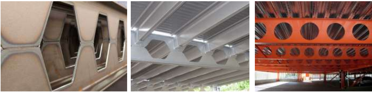
Рисунок 8.22. Примеры основных типов перфорированных балок
