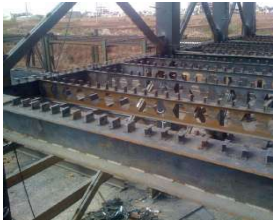
Рисунок 5.43. Примеры гибких упоров в виде прокатных швеллеров без подкрепляющих ребер
