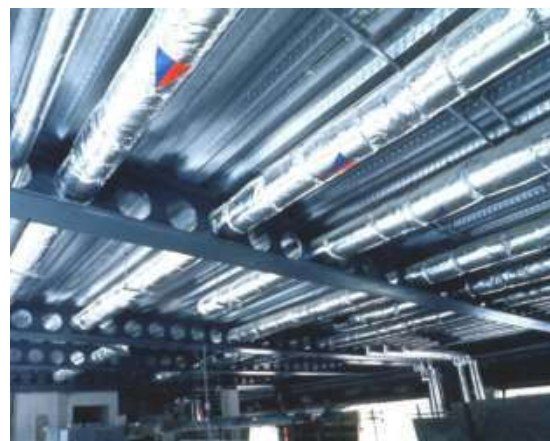
(2) Разводка сетей в створе перекрытия под плитой
