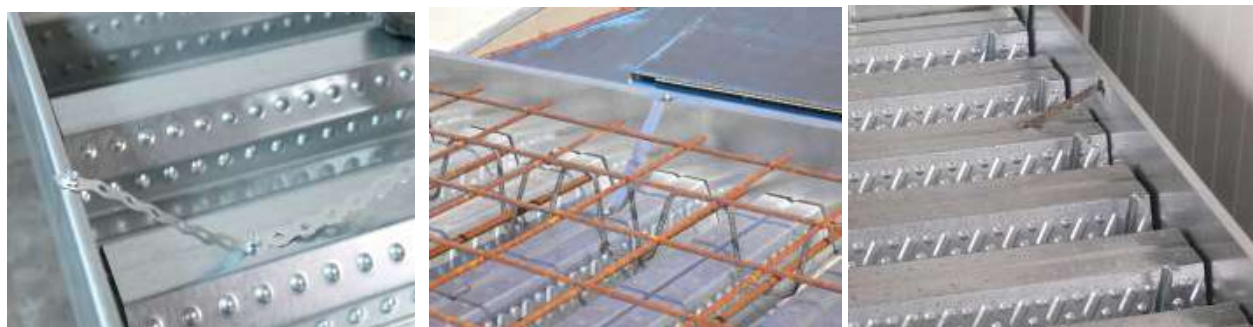
Рисунок 8.17. Примеры крепления торцевой планки сталежелезобетонной плиты
