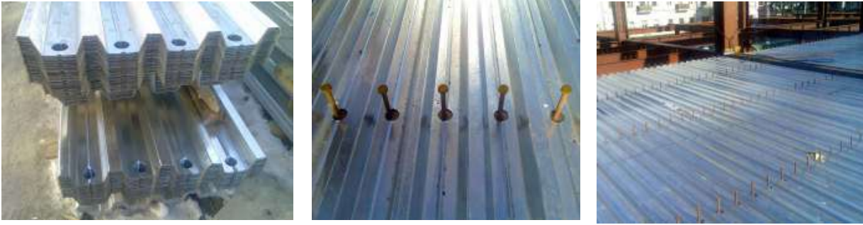
Рисунок 8.28. Прорезание отверстий под стад-болты в профнастиле (не рекомендуется)
