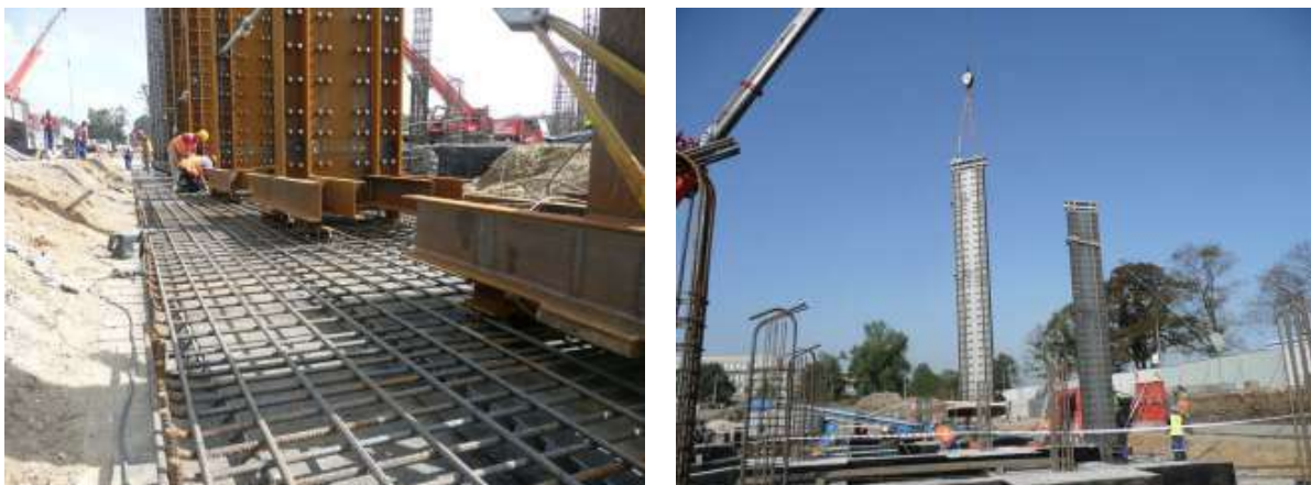
Рисунок 1.10. Пример мощных частично обетонированных колонн
