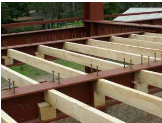
Рисунок 3.2. Подклинка опалубки временными балками позволяет избежать постановки стоек
