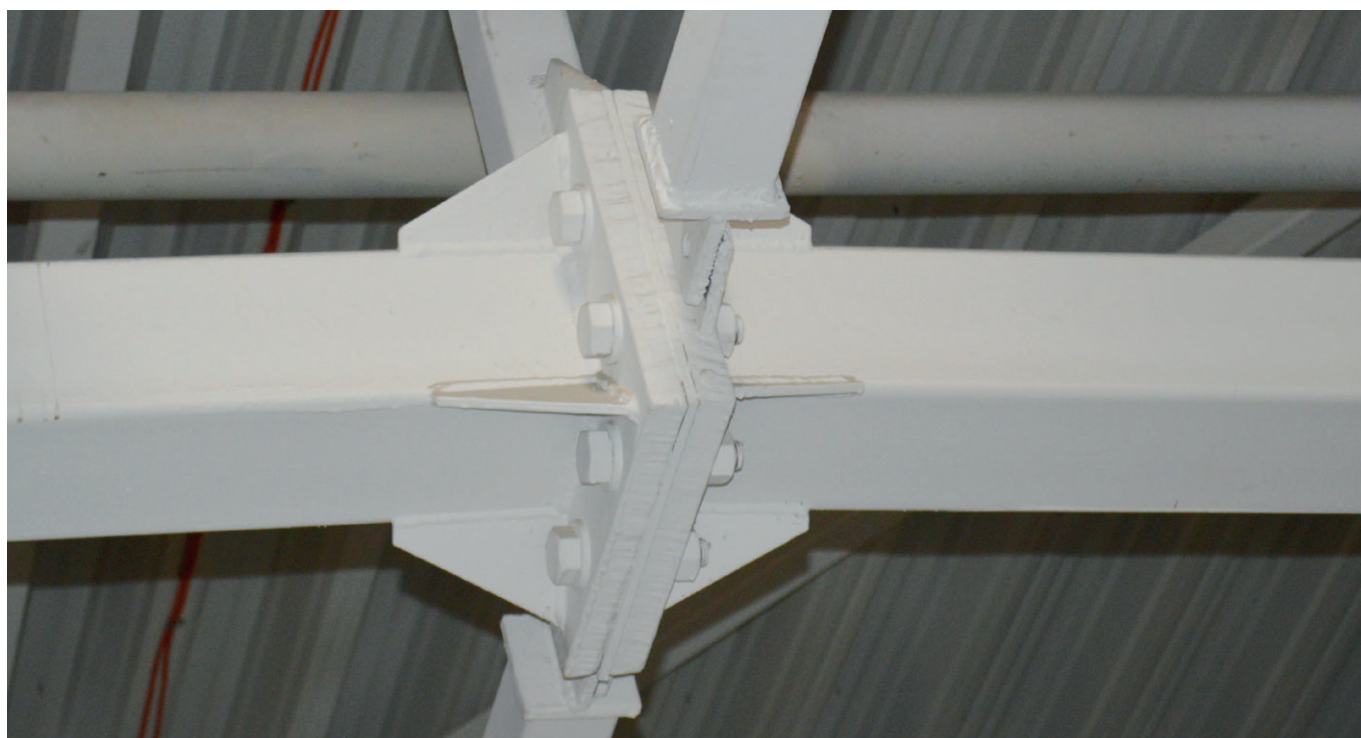
Рис. 15 – Огнезащита узла фермы интумесцентной краской
