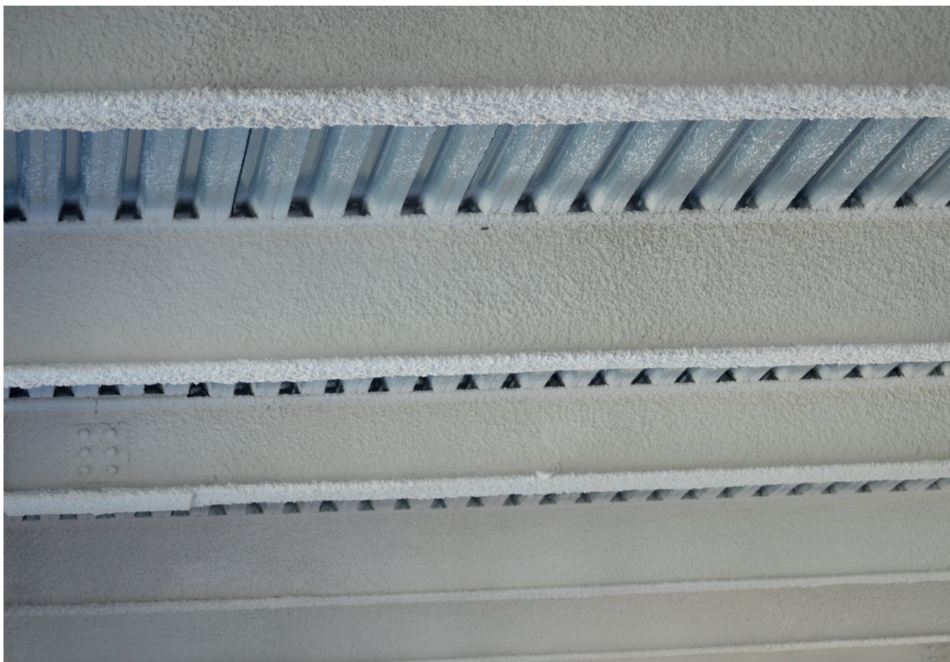
Рис. 6 – Огнезащита балок перекрытия штукатурным покрытием
