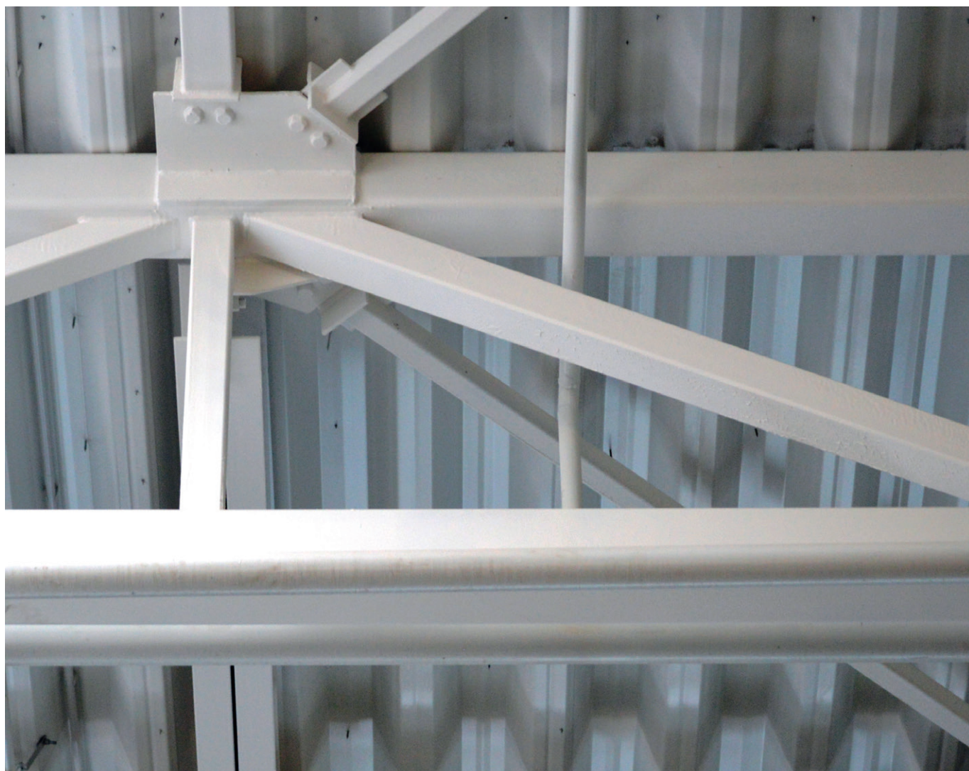
Рис. 1 – Огнезащита стальной фермы интумесцентной краской
