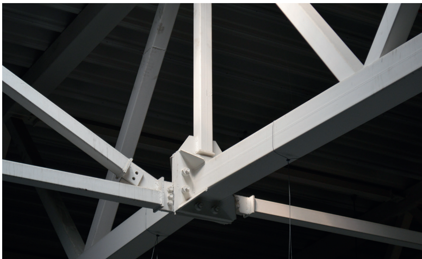
Рис. 14 – Огнезащита стальной фермы интумесцентной краской
