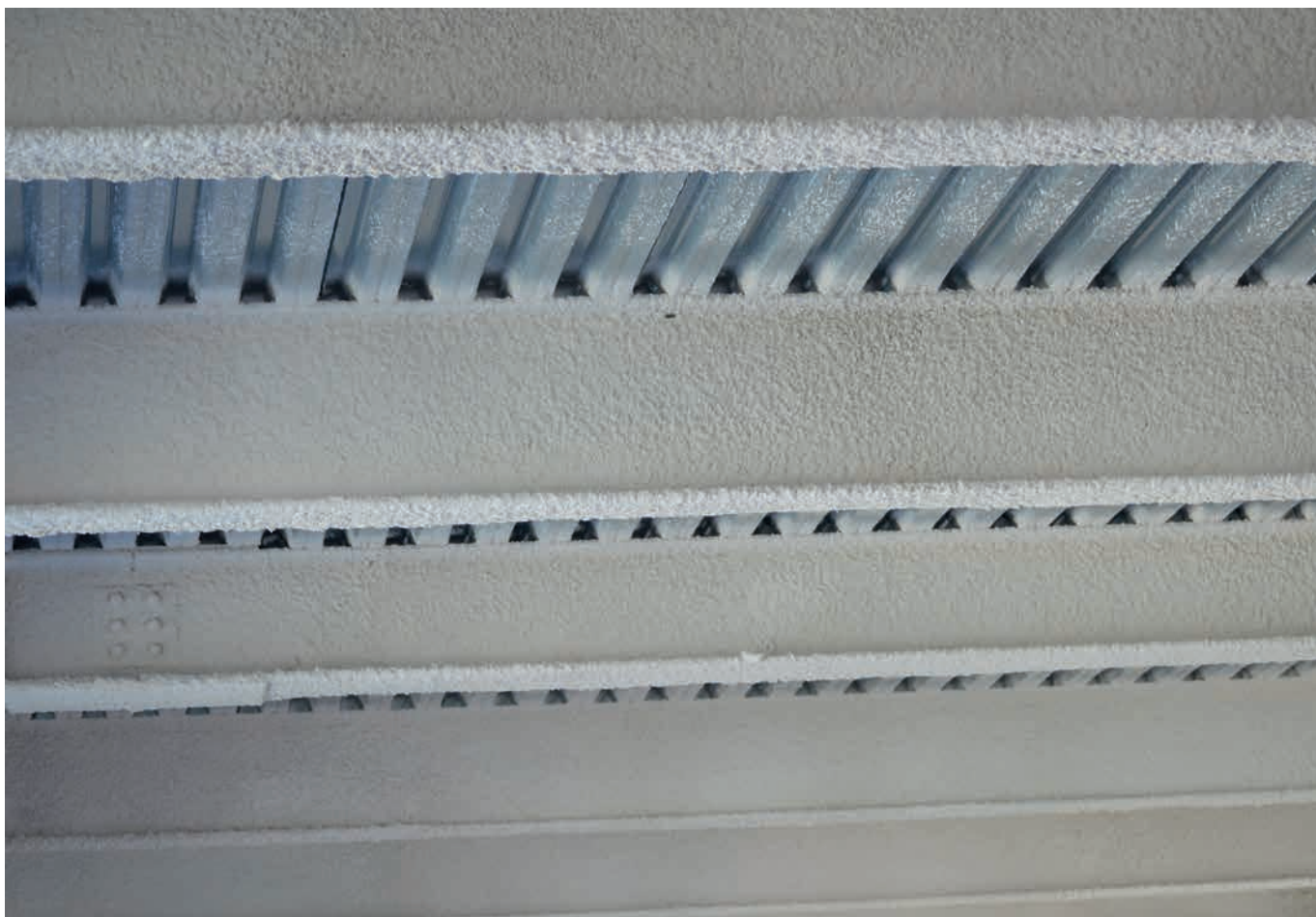
Рис. 6 – Огнезащита балок перекрытия штукатурным покрытием
