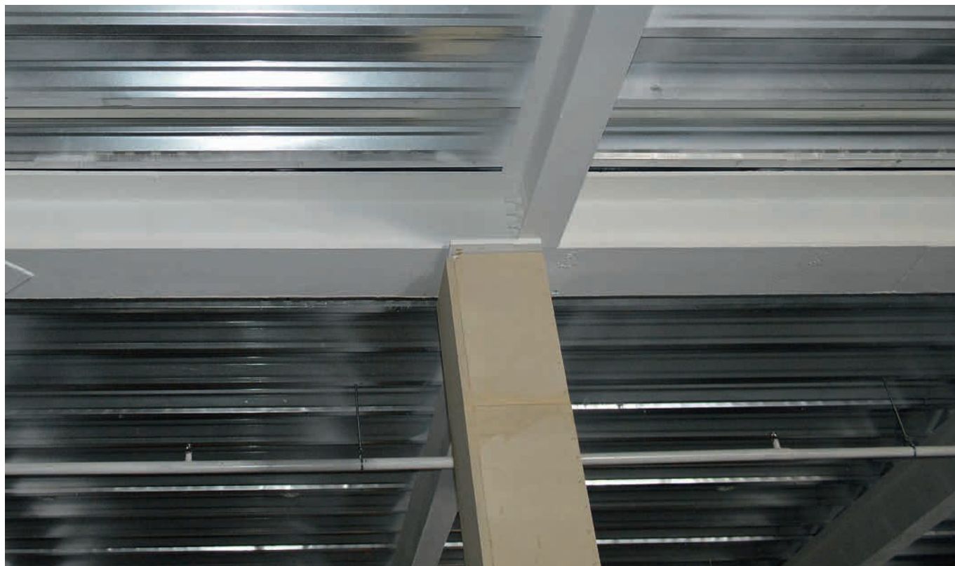
Рис. 8 – Огнезащита балок перекрытия интумесцентной краской и колонн плитами
