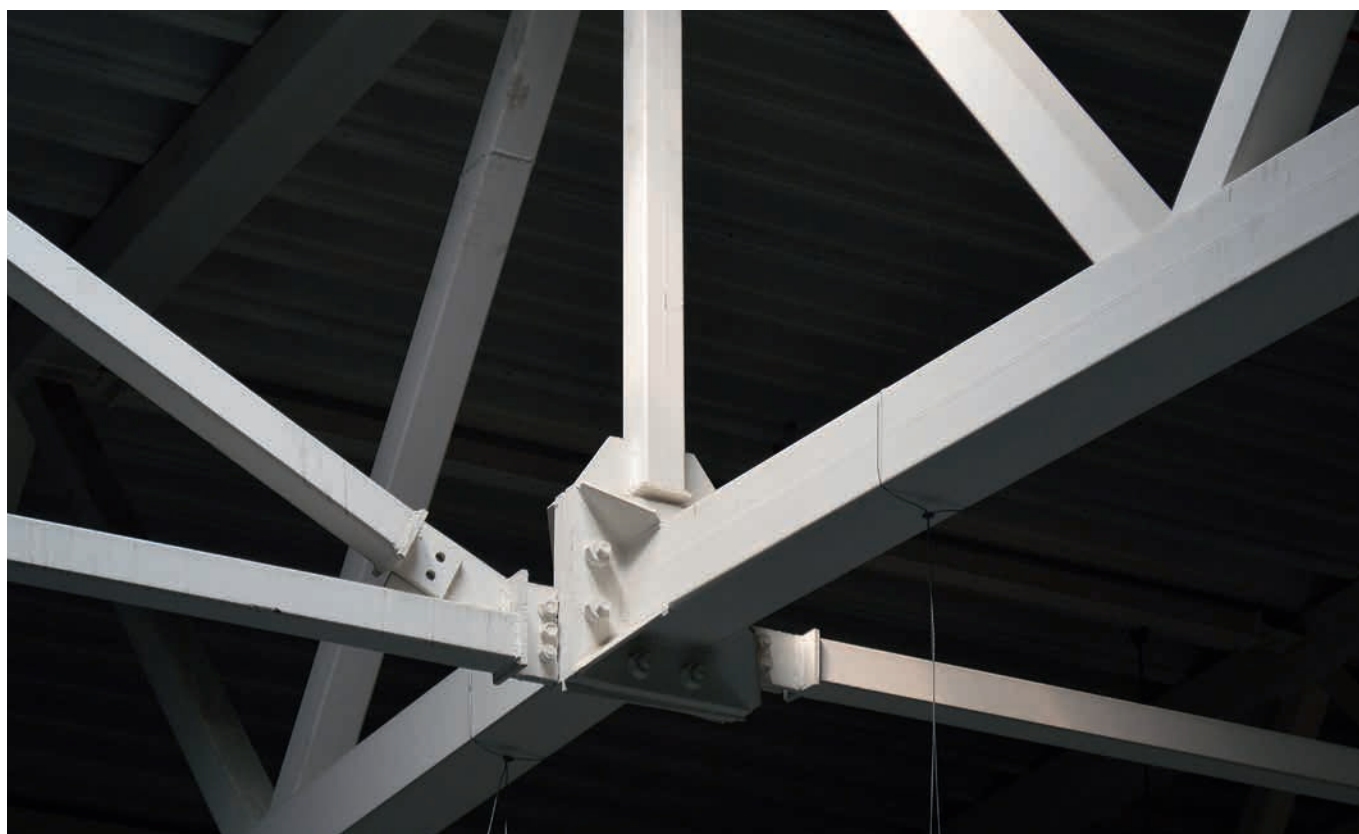
Рис. 14 – Огнезащита стальной фермы интумесцентной краской
