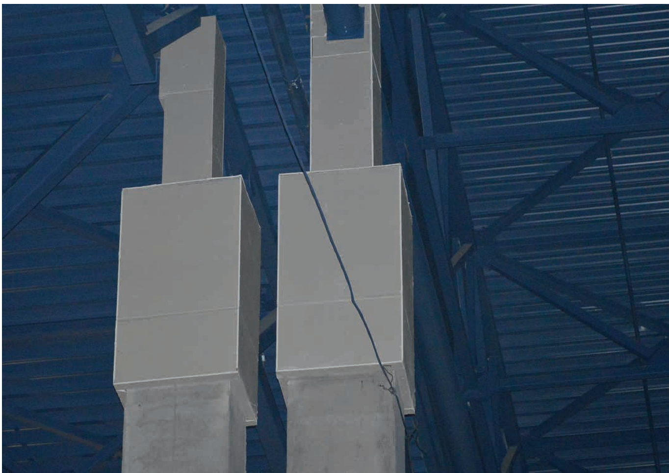
Рис. 16 – Огнезащита стальных надколонников плитами
