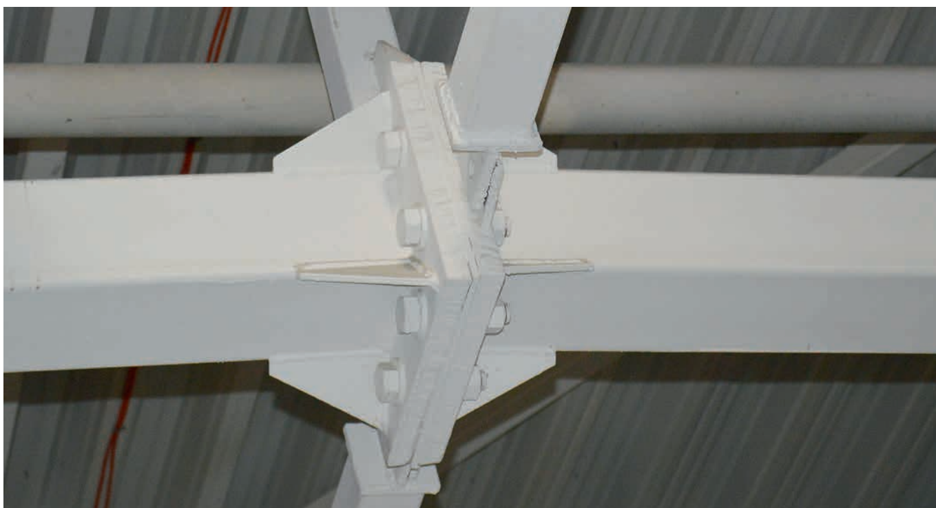
Рис. 15 – Огнезащита узла фермы интумесцентной краской
