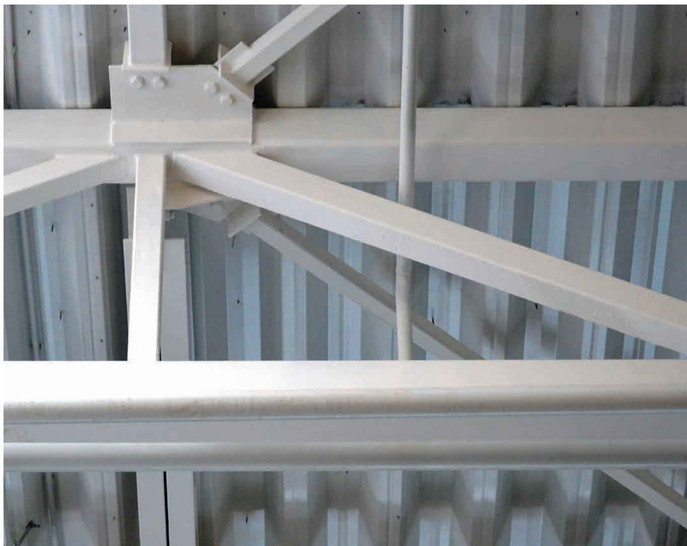
Рис. 1 – Огнезащита стальной фермы интумесцентной краской
