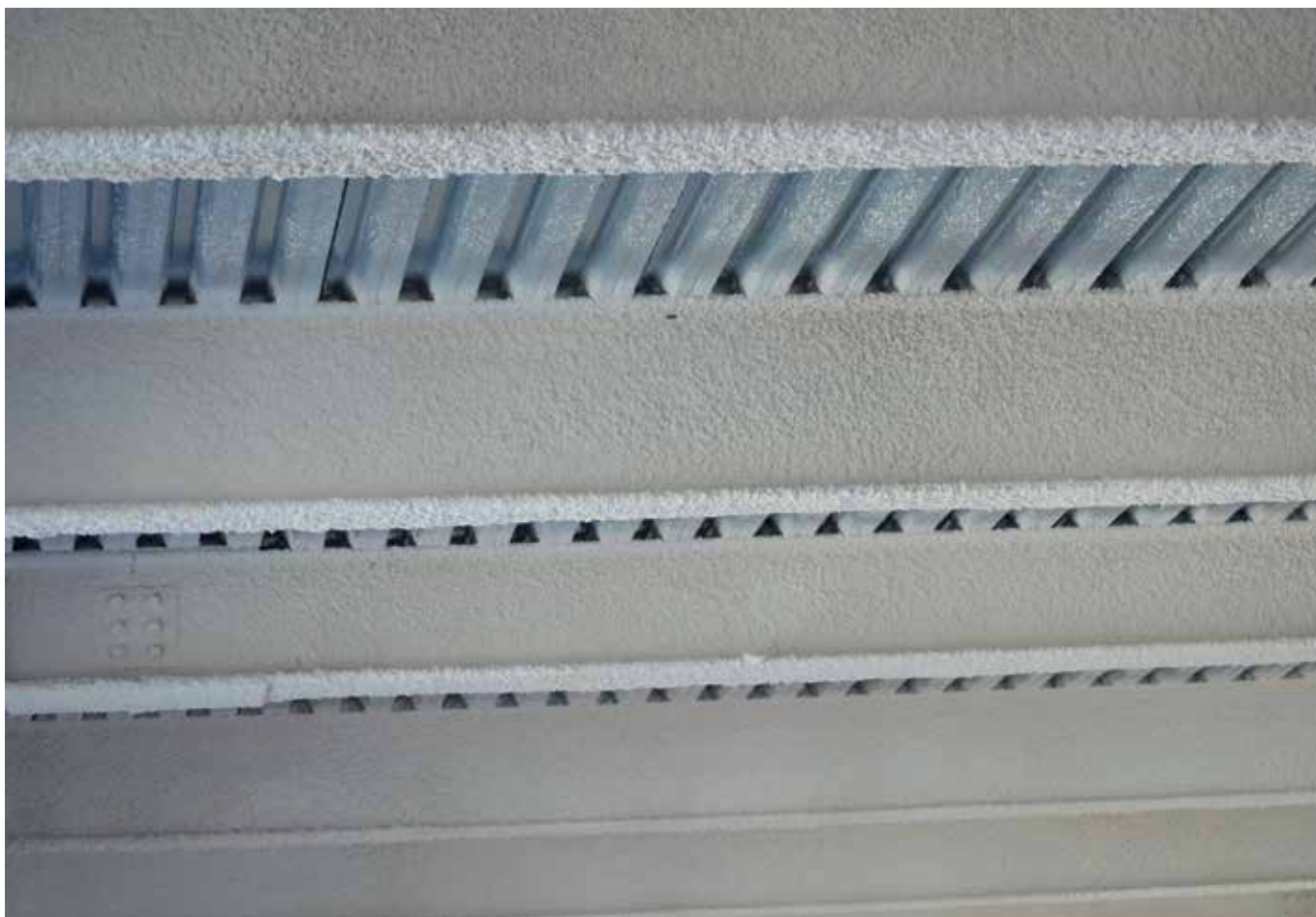
Рис. 6 – Огнезащита балок перекрытия штукатурным покрытием
