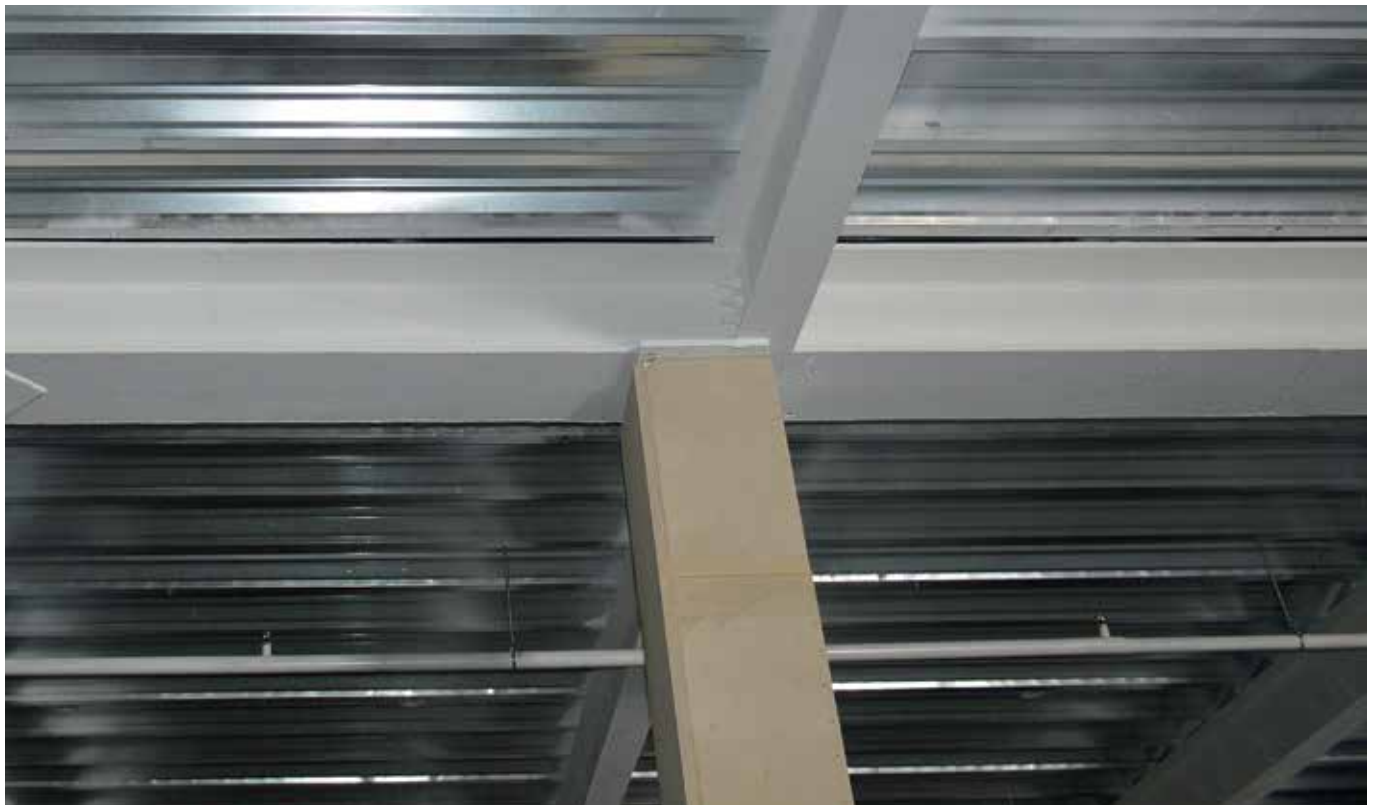
Рис. 8 – Огнезащита балок перекрытия интумесцентной краской и колонн плитами
