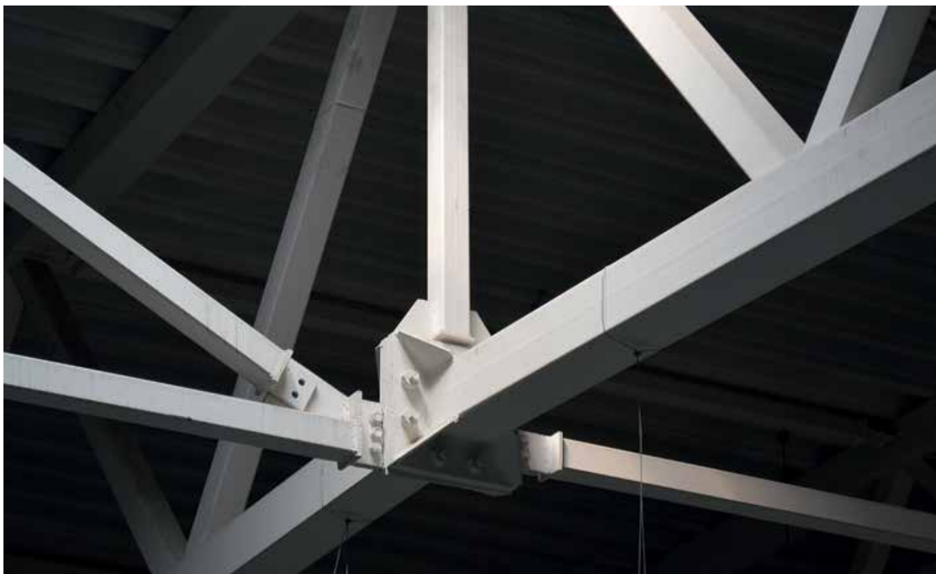
Рис. 14 – Огнезащита стальной фермы интумесцентной краской
