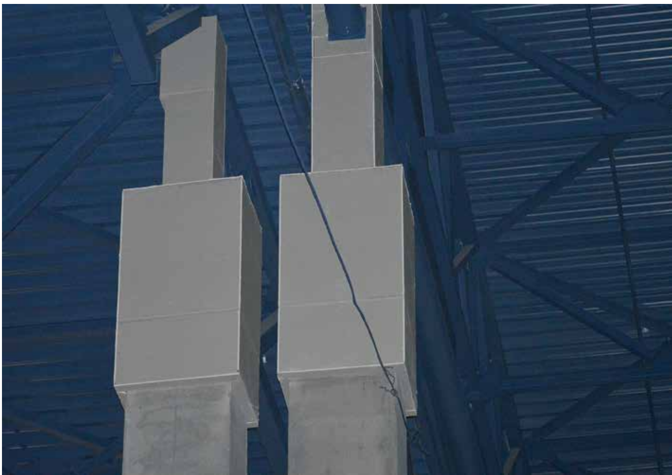
Рис. 16 – Огнезащита стальных надколонников плитами
