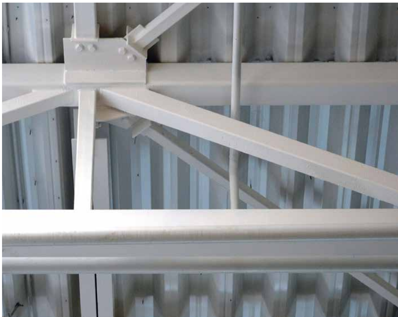
Рис. 1 – Огнезащита стальной фермы интумесцентной краской
