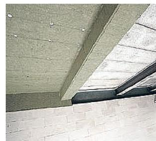
**Комбинированные способы огнезащиты** применяются в практике огнезащиты для решения сложных и нетрадиционных технических задач. Они представляют собой сочетание огнезащитных материалов разных видов, например: термостойких волокнистых плит с покрытиями на минеральных вяжущих или вспучивающимися покрытиями; волокнистых теплоизоляционных материалов с гипсокартонными листами; теплоизоляционных материалов с огнезащитными цементно-вермикулитовыми плитами и т.д.
