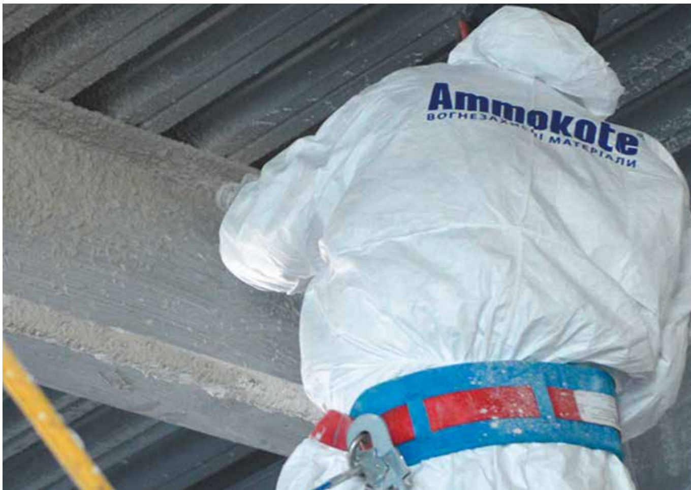
Вогнезахисне оброблення сталевих конструкцій штукатуркою
