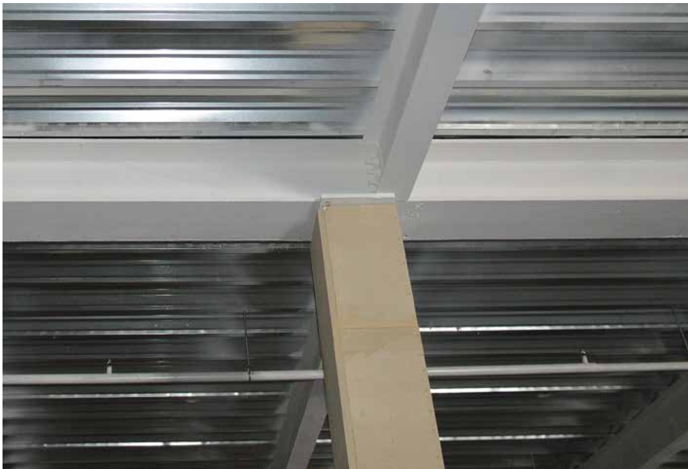
Вогнезахист балок перекриття інтумесцентним покривом Ammokote MS-90 та колон плитами Ammokote FB-300
