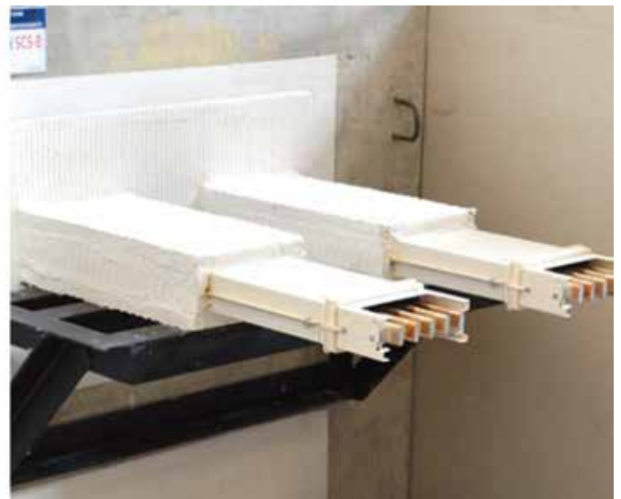
Проходка шинопроводів
