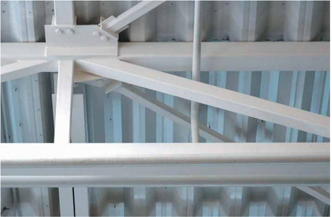
Вогнезахист елементів покриття реактивним покритвом – інтумесцентна фарба Ammokote MW-60
