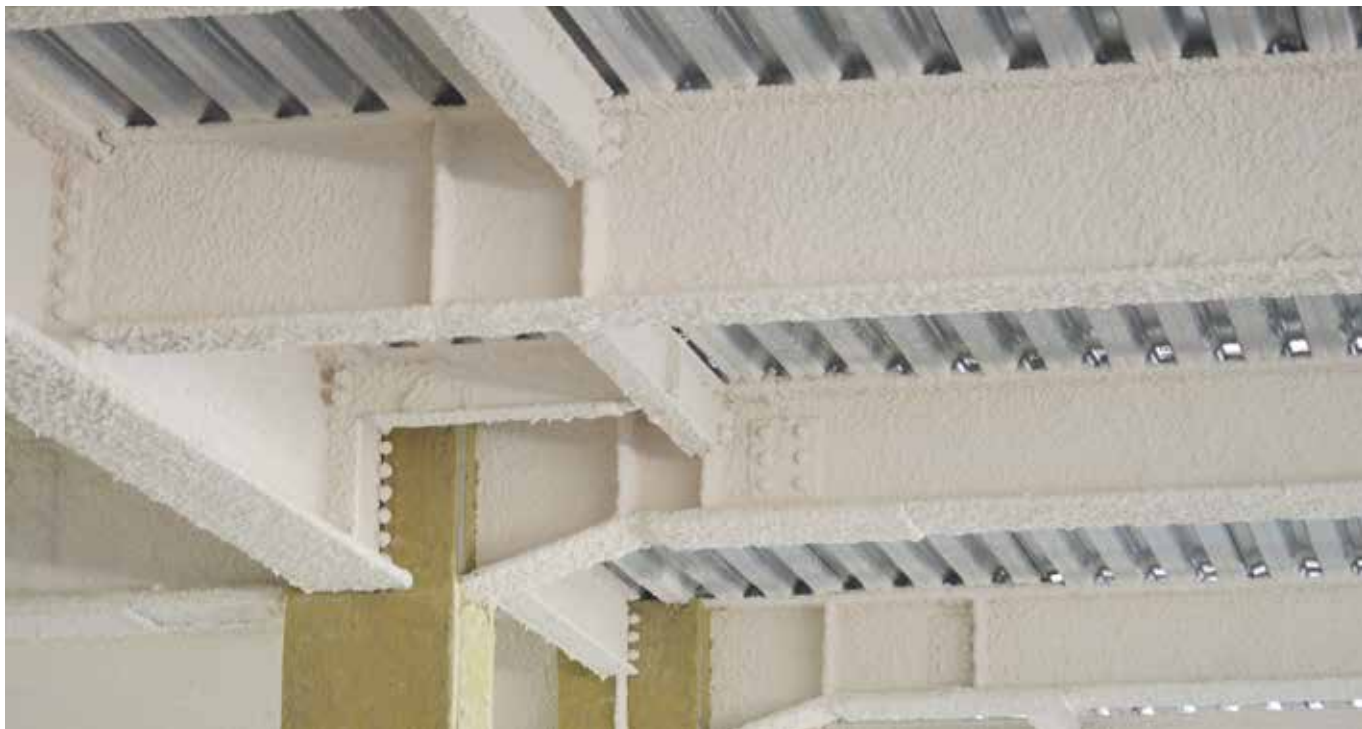
Вогнезахист балок перекриття штукатурним покривом Ammokote GP-240 і колон мінераловатними плитами Rockwool
