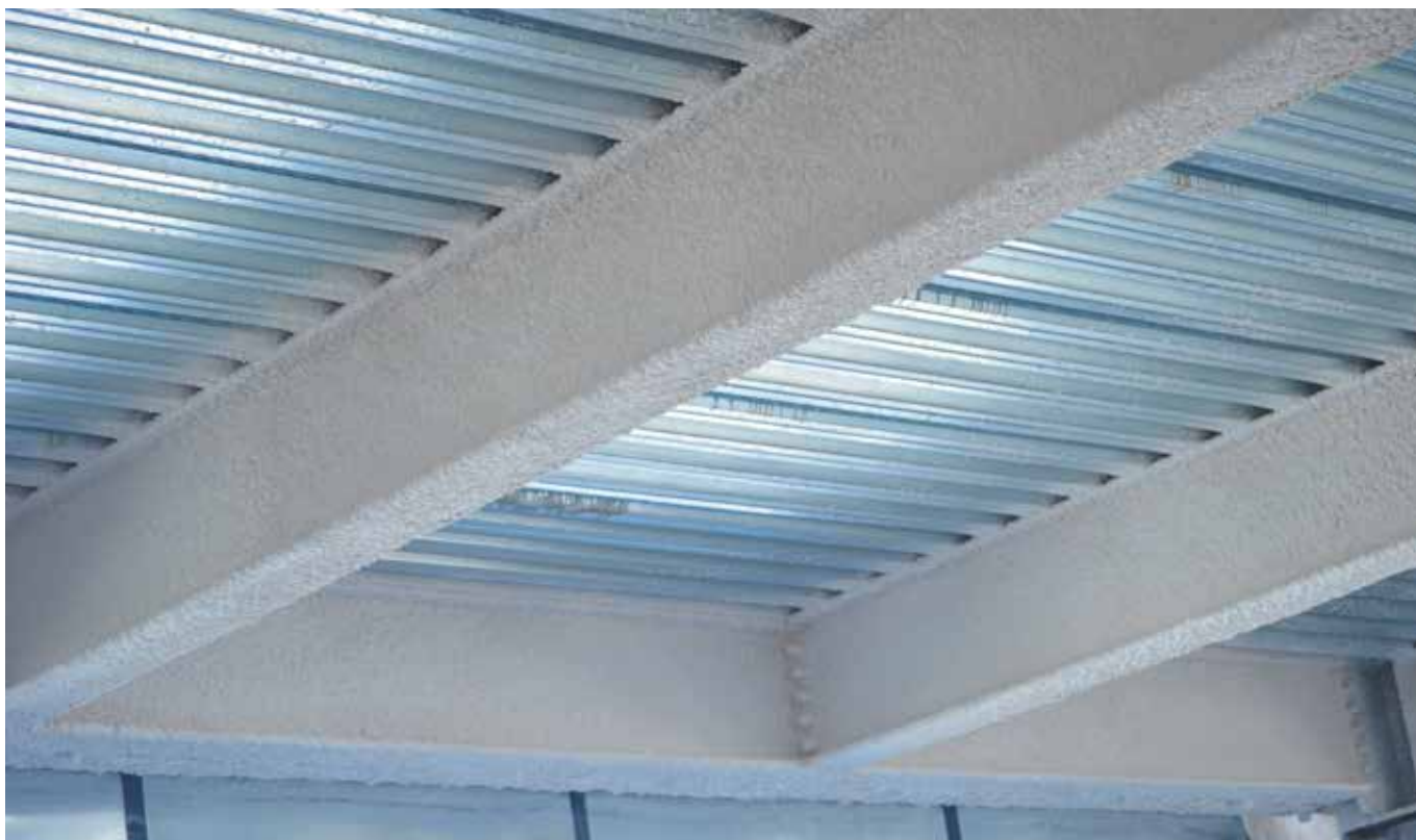
Вогнезахист балок теплоізоляційним покривом – вогнезахисна штукатурка Ammokote GP-240
