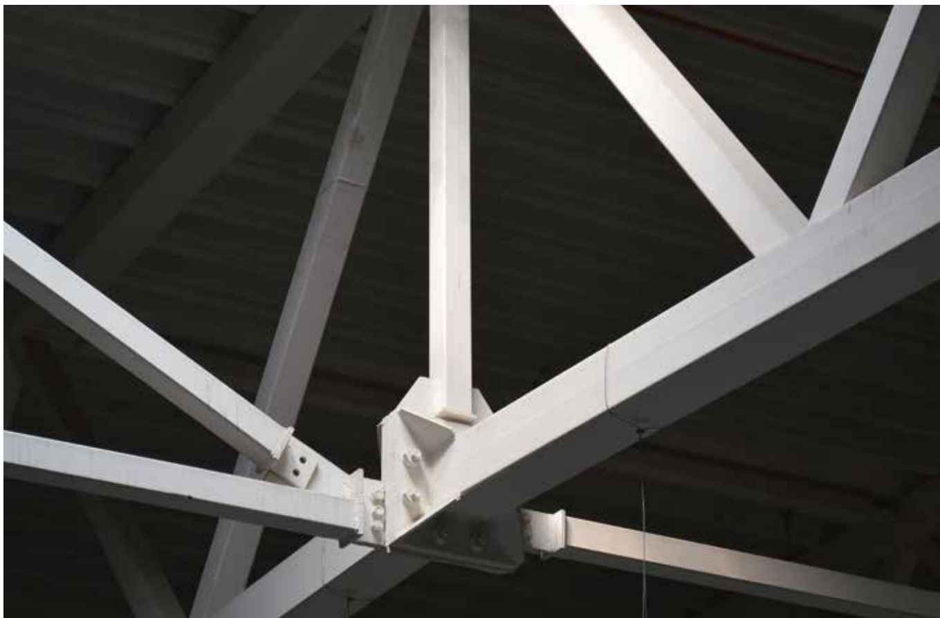
Вогнезахист сталеві ферми покритвом Ammokote MW-60
