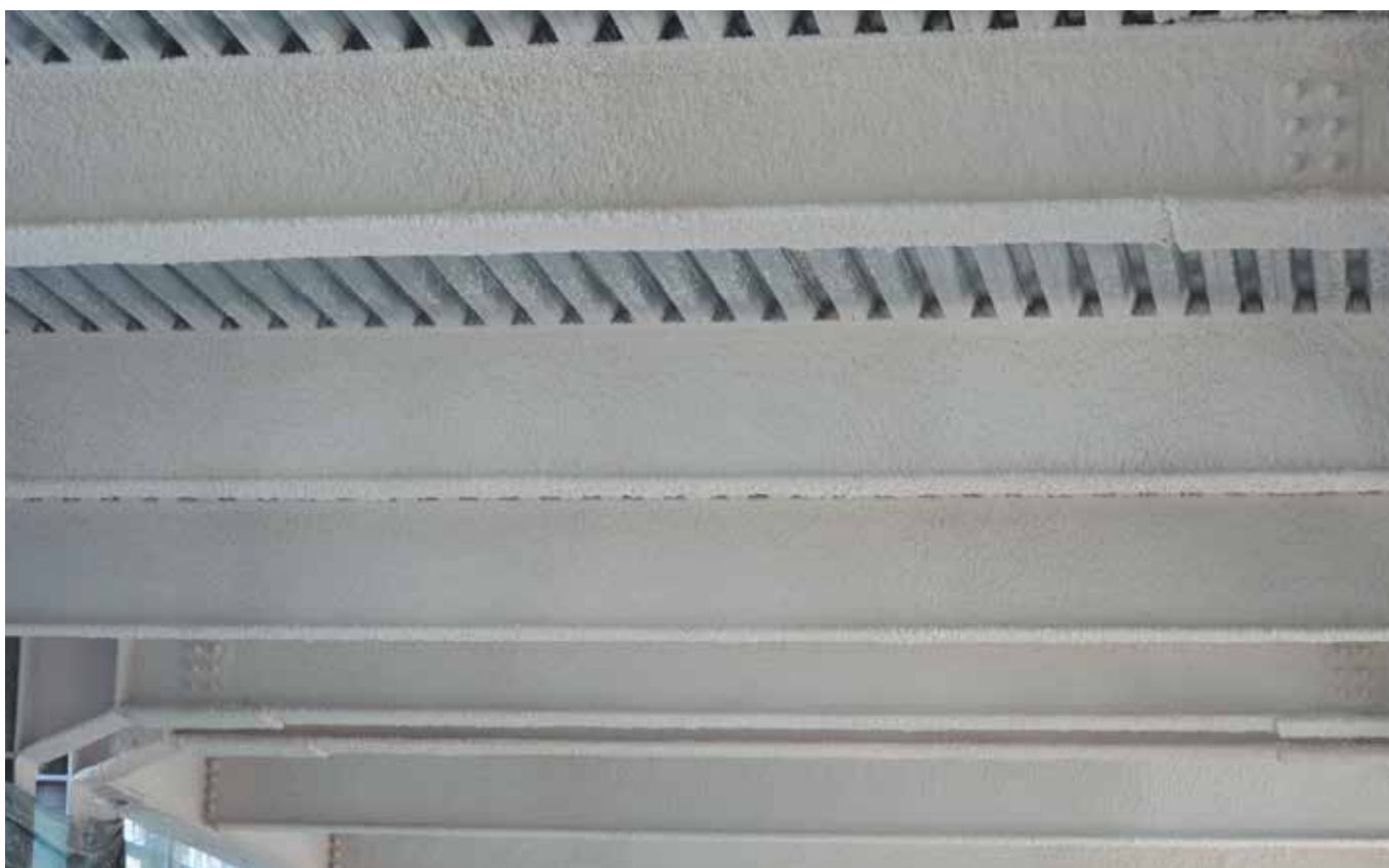
Вогнезахист сталевих балок штукатурним покривом Ammokote GP-240
