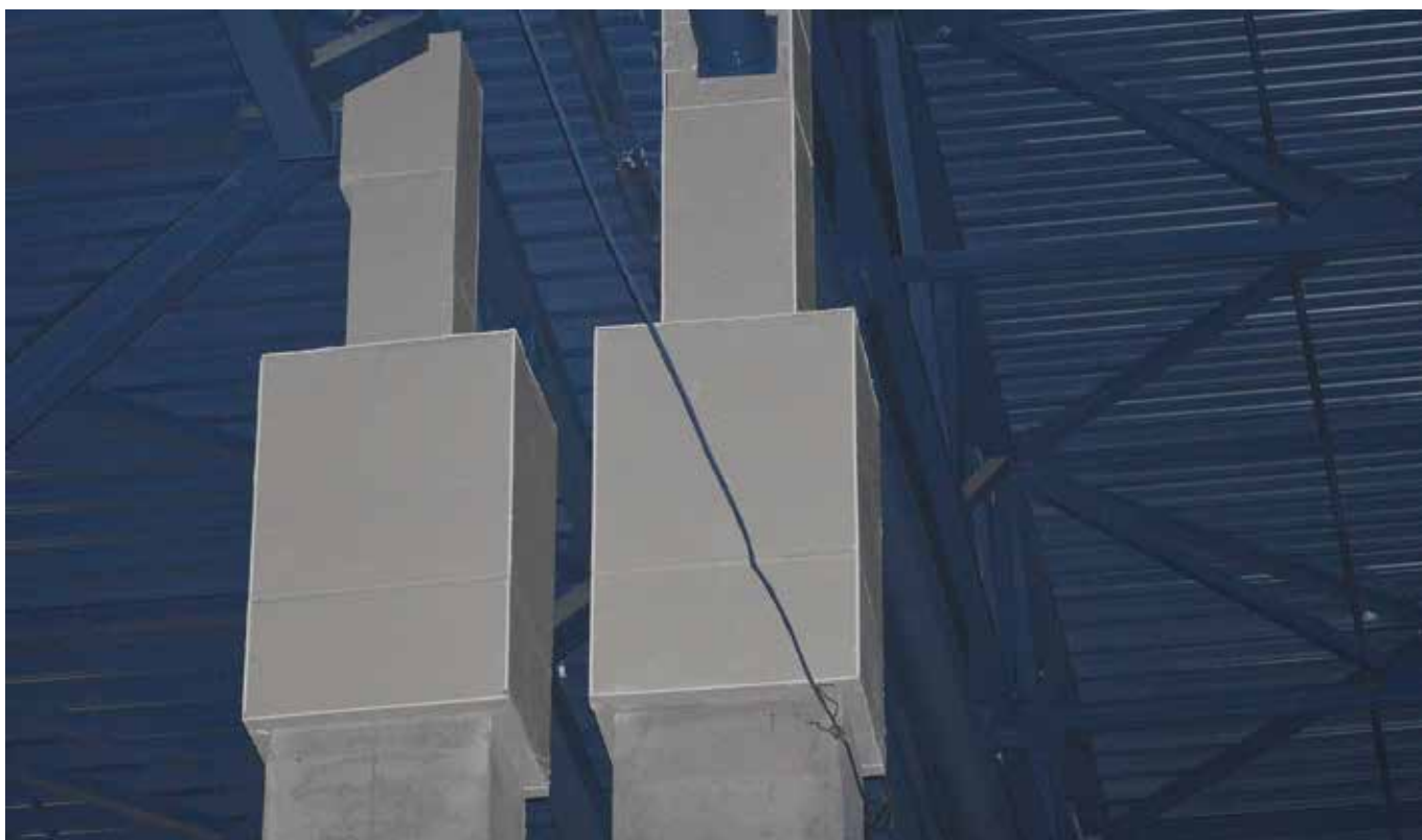
Вогнезахист надколониїв теплоізоляційним покривом – плити Promatect-L500
