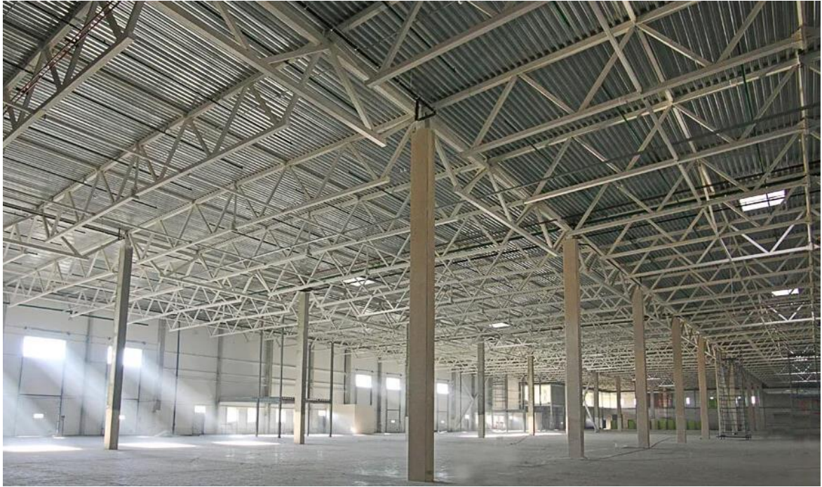
Загальний вигляд змішаного каркасу
