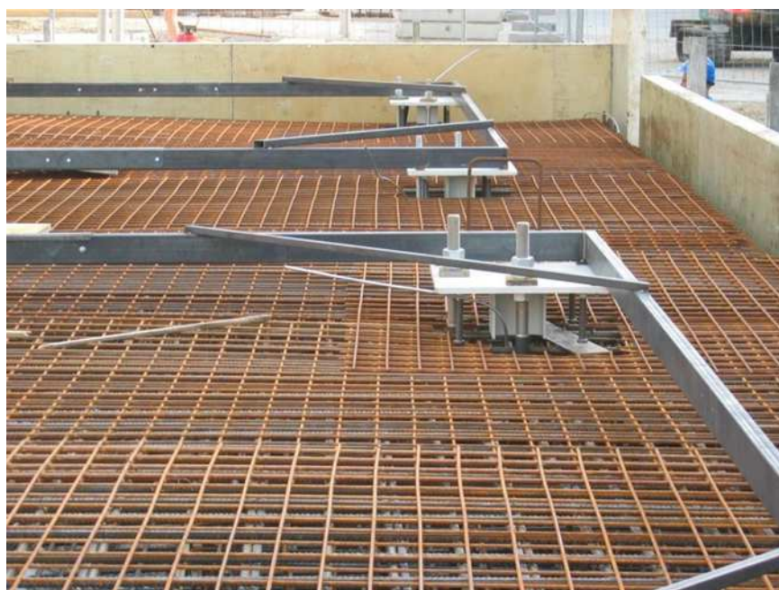
Рисунок 18а: Верхний шаблон для упакованного прямоугольного холодного блока.
