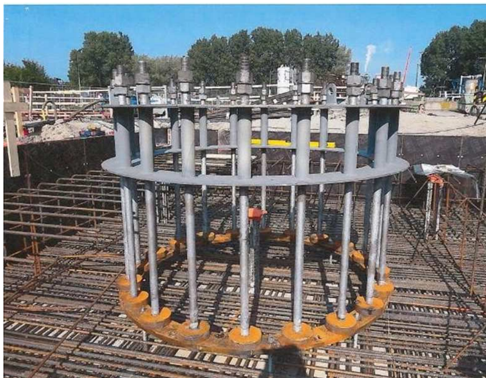
Fig 18b – Double Template for large diameter column, or large diameter bolts / Двойной шаблон для колонны большого диаметра или болтов большого диаметра
