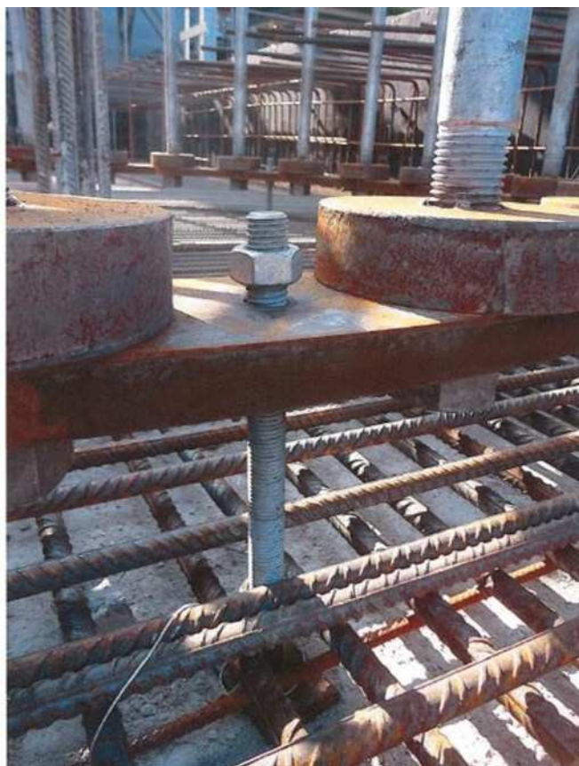
Fig 18d – Holding down vertically the bolts within the formwork / Рисунок 18d - Удерживание болтов в опалубке вертикально вниз
