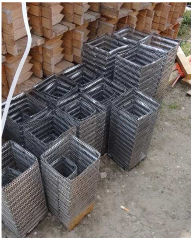
Figure 17: Expanded metal boxes for pockets type anchor bolts / Рисунок 17: Расширительные металлические коробки для анкерных болтов карманного типа
