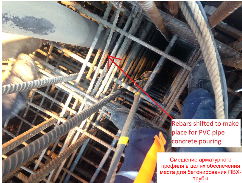
Figure 5: #4 PVC concreting pipe Рис. 5. №4 ПВХ-трубы для бетонирования
