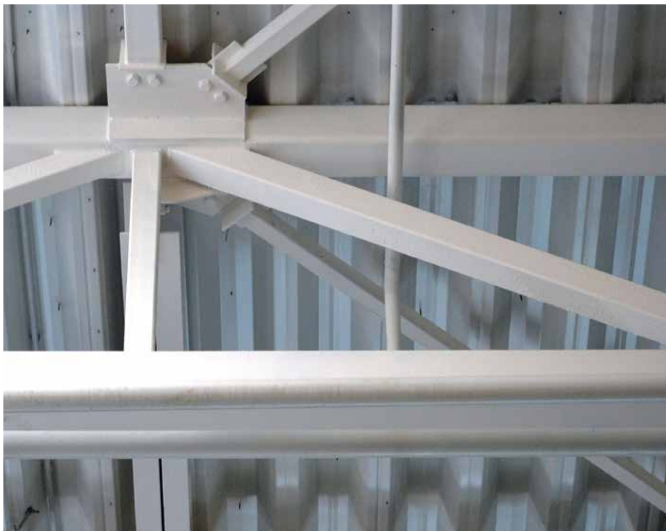
Рис. 1 – Огнезащита стальной фермы интумесцентной краской
