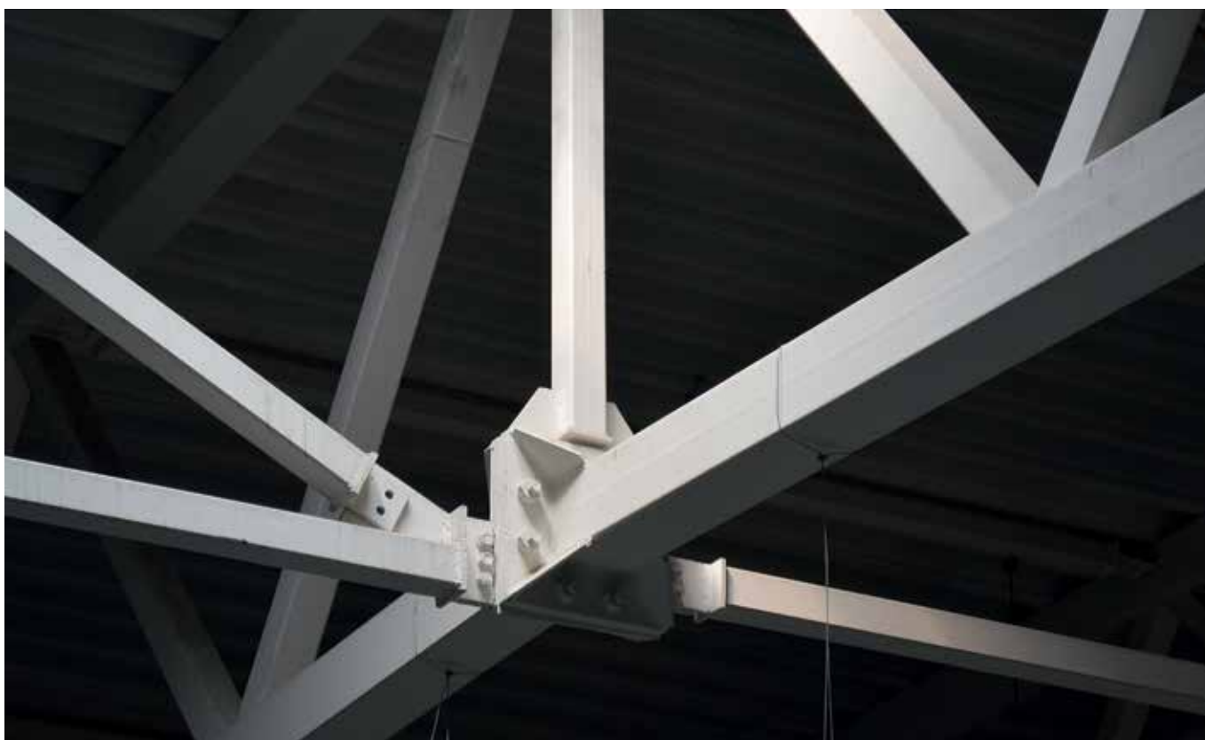
Рис. 14 – Огнезащита стальной фермы интумесцентной краской
