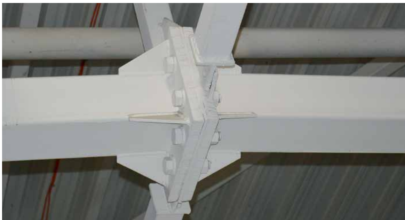
Рис. 15 – Огнезащита узла фермы интумесцентной краской
