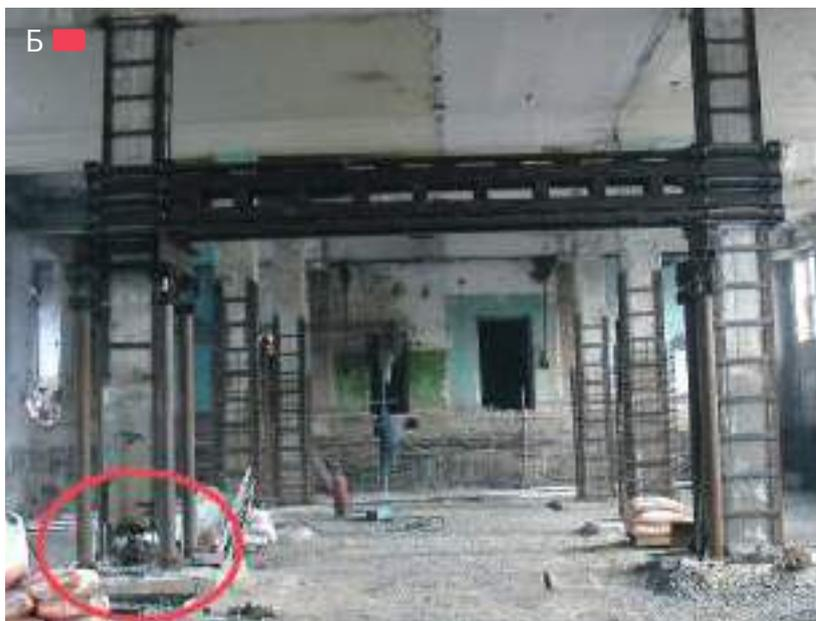
**Рис. 3.4.3** – А – замена кирпичных пилонов на стальные колонны и сталебетонные аутригеры в торгово-развлекательном центре Las Arenas 1900 г., Барселона, Испания, 2011 г.; Б – устройство системы вдавливаемых металлических свай и перехватывающего по трению временного каркаса для замены аварийной бетонной колонны, г. Киев, Украина, 2012 г.
