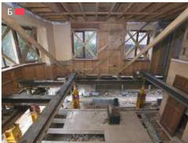
**Рис. 5.1.5** – Домкраты со стальными подставными устройствами фиксации и балочной клеткой из двутавров при подъеме здания на 1,5 м в г. Врейсбуре, Беркшир, Великобритания, 2014 г.
