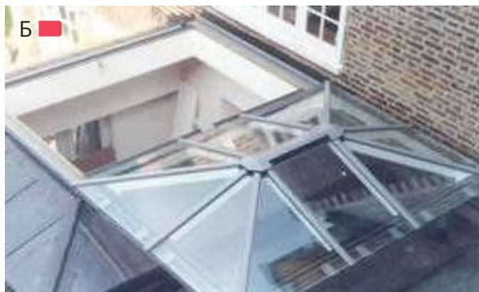
**Рис. 5.3.6** – А – подвижные элементы из стальных балок кровли между зданиями; Б – отодвигаемая арочная кровля внутреннего двора
