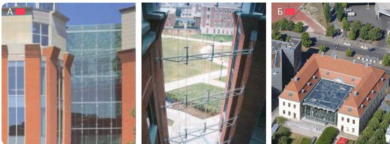
**Рис. 4.2.6** – А – заполнение пассажа с преобразованием во входную группу с помощью стальных ферм фахверка и покрытия в Howard University, Louis Stokes Health Sciences Library, г. Вашингтон, США, проект Hillier ArchitecturePSG; Б – «стеклянный двор» с металлическим каркасом Еврейского музея в Берлине, Германия, 1998 г., арх. Д. Либескинд
