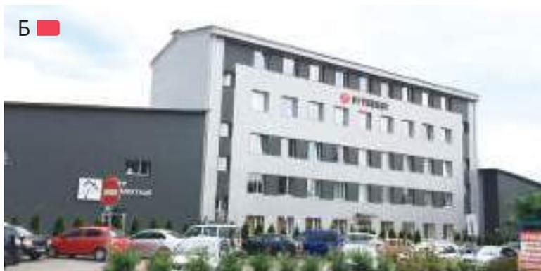
**Рис. 4.3.3** – Реконструкция фабрики в офисное здание с надстройкой двух этажей при опирании на существующие усиленные стены по ул. Коллекторная в г. Киеве, Украина, проект «Вартість», 2012 г.
