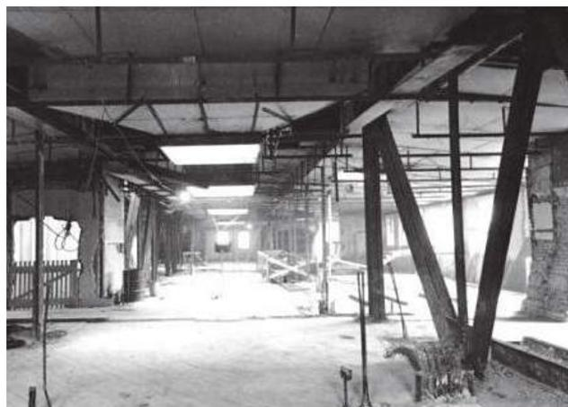
**Рис. 3.6.3** – Реконструкция Белого Дома (Вашингтон, США) с заменой стен и подведением стального каркаса, США, 1948–1952 гг.
