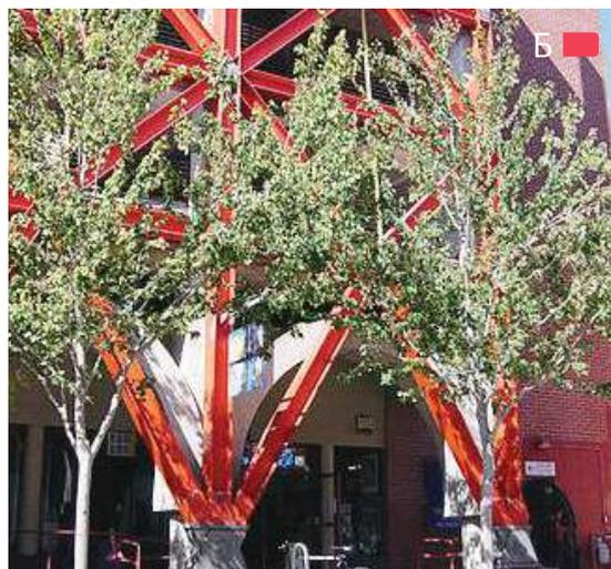
**Рис. 3.1.6** – А – укрепление кирпичных стен временным внешним металлокаркасом при реконструкции ЦУМа, г. Киев, 2014 г.;
