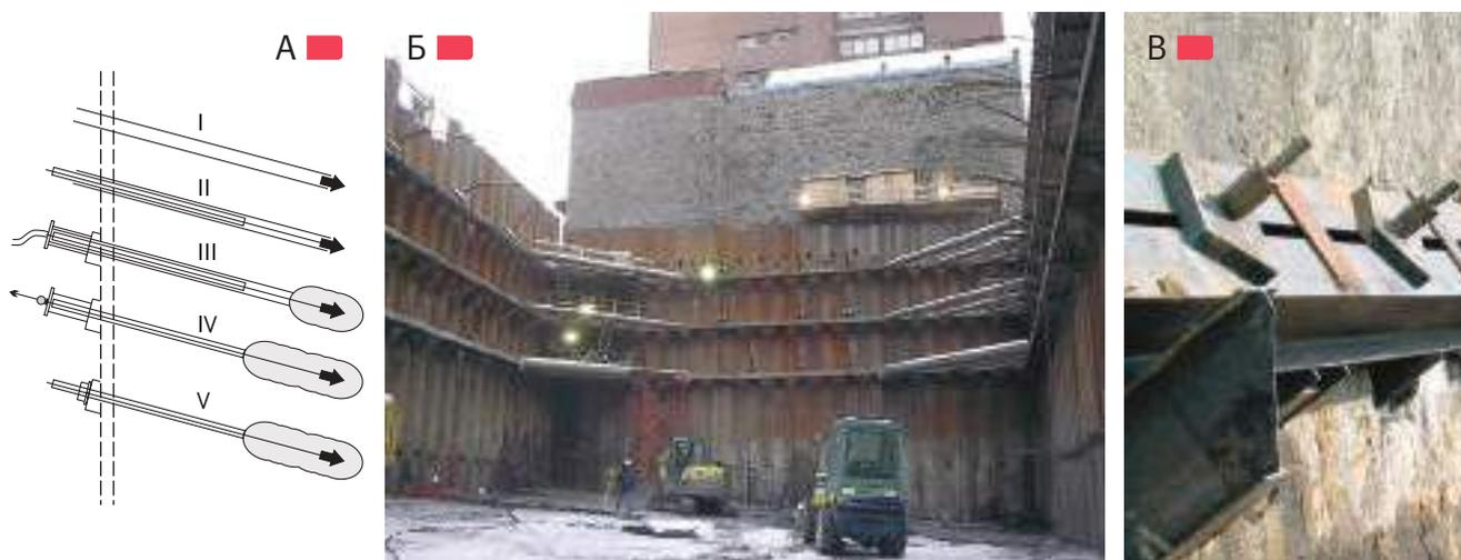
**Рис. 4.5.8** – А – этапы устройства анкерных свай; Б – натягаемые анкерные канатные сваи, обустроенные для укрепления листового шпунта через стальные пояса со стержневыми вутами в плотной застройке; В – закрепление концов анкерных свай, I-V – этапы обустройства (пояснения в тексте)
