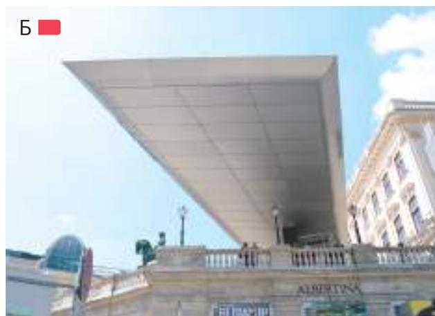
**Рис. 4.1.4** – А – установка сварной балочной консоли для организации угловой входной группы Дома Профсоюзов в Киеве; Б – стальной навес, обшитый композитными панелями музея искусств Альбертина г. Вена, Австрия
