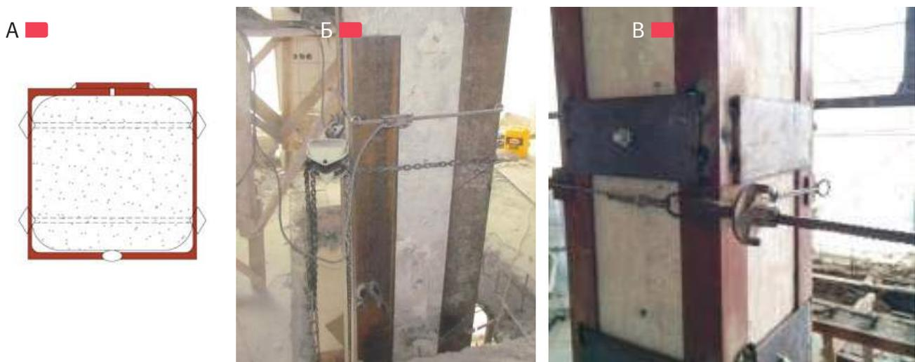
**Рис. 3.1.2** – Усиление железобетонных колонн стальными рубашками: А – схема с парными швеллерами; Б – в процессе выполнения из уголков со стягиванием струбцинами
