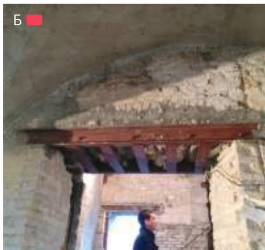
**Рис. 3.3.3** – Врезные перемычки в интерьере: А – из двутавров с опиранием на существующие колонны промышленного здания при превращении его в The SculptureCenter’s, Кливленд, США 2001 г., проект M.Lin; Б – из швеллеров в историческом здании в г. Киеве, 2015 г.
