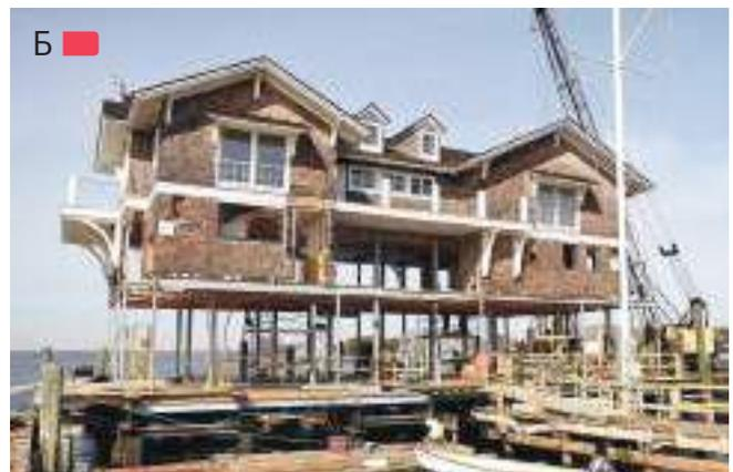
**Рис. 5.1.9** – Поднятые для предотвращения затопления здания на побережье США: А – жилые, Б – яхт-клуб
