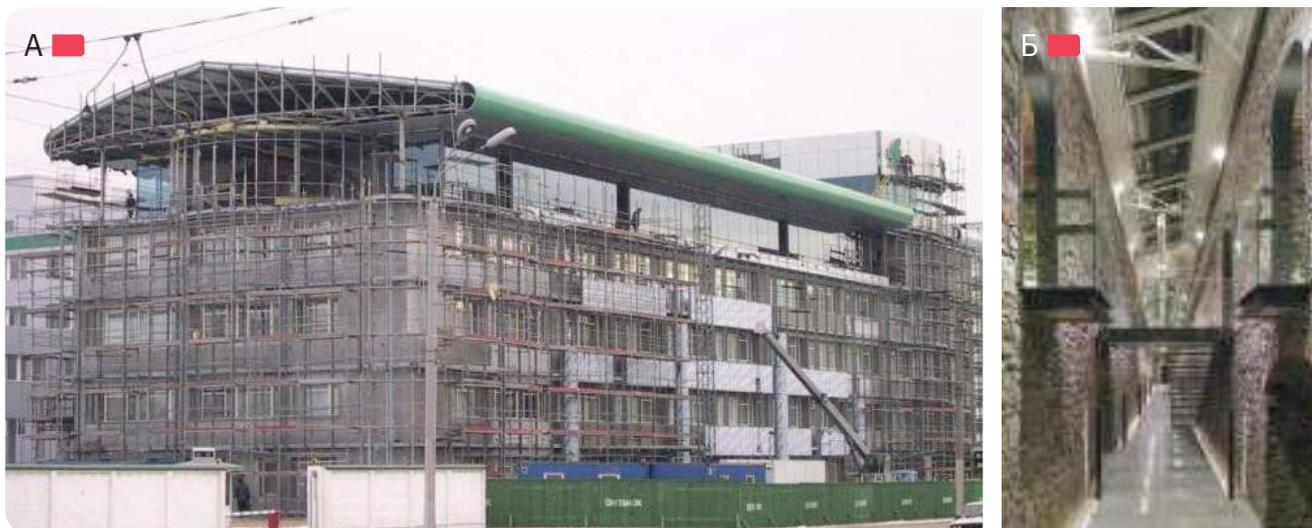
**Рис. 4.1.6** – А – выход решетчатыми консолями при реконструкции фармацевтической фабрики «Дарница» в г. Киеве, 2002 г. (также см. рис. 1.2.2); Б – преобразование склада в офисное здание в г. Стамбуле, Турция, с консолями из двутавров, проект бюро Erginoglu & Calislar 2009 г.
