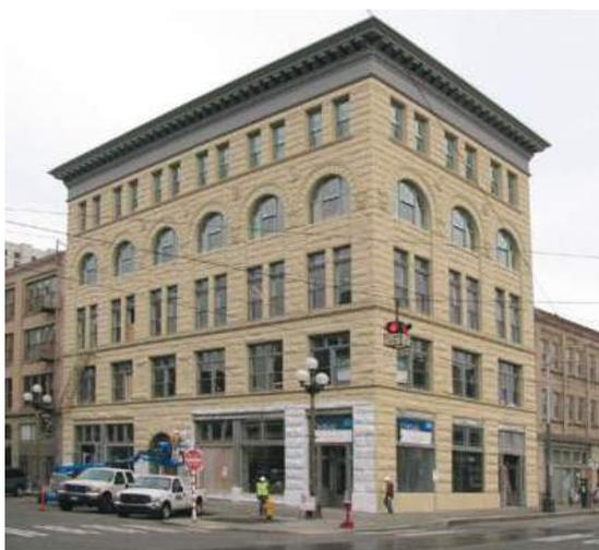
**Рис. 4.3.4** – Надстройка трех этажей с каркасом с решетчатыми ригелями перекрытий при опирании на существующие усиленные стены исторического здания 1901 в г. Сиэтл, США, 2010 г.
