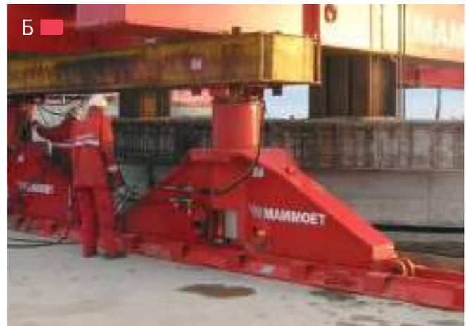
**Рис. 5.2.2** – А – передвижение тяговыми лебедками старого вокзала Шенбург, г. Женева, Швейцария, длиной 17 метров и шириной 9 метров за 6 часов; Б – пример горизонтальных домкратов и временных направляющих для перемещения балочной клетки
