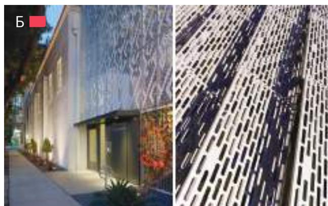
**Рис. 2.7.8** – А – стальной трансформируемый фасад при реконструкции производственного здания в магазин органических продуктов, проект бюро АКА, 2010 г.; Б – перфорированные элементы при реновации фасада жилого здания в Лос-Анджелесе, США 2013, бюро Koning Eizenberg
