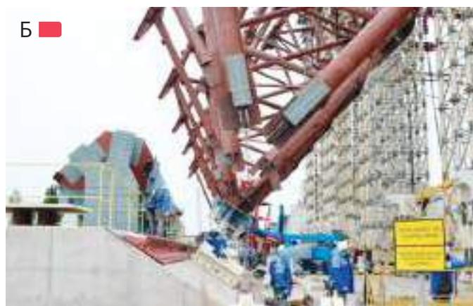
**Рис. 5.2.7** – Арочное стальное передвижное укрытие Чернобыльской станции, Украина, шириной 257, высотой 110 м, перемещено на 327 м за 33 часа, проект Bechtel, Battelle, EDF, КСК, передвижка «Novarka», 2016 г.
