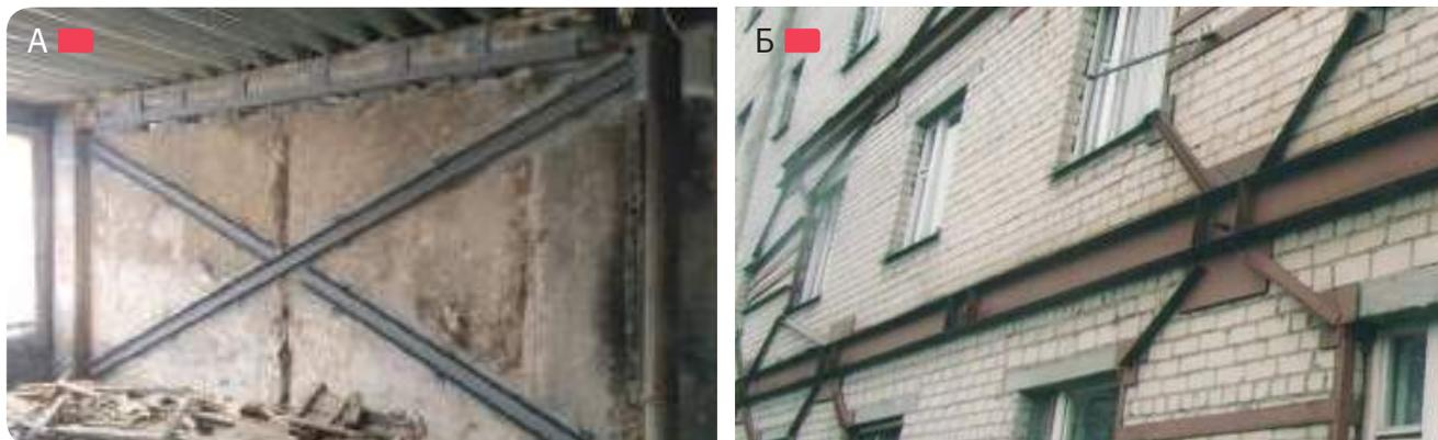
**Рис. 3.1.7** – Усиление стальными континуальными связями: А – сборных железобетонных стен-диафрагм; Б – кирпичных стен
