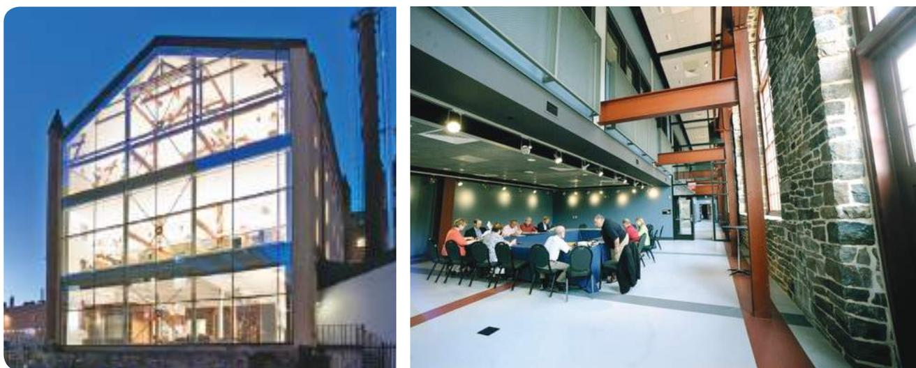
**Рис. 3.4.11** – А – замена фасадной стены на независимый стоечно-ригельный каркас в здании Ostarpharma в г. Стокгольм, Швеция, арх. бюро Joliark; Б – интерьер при введении независимого стоечно-ригельного каркаса с оставлением стен и последующим устройством дополнительного этажа
