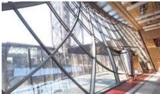
**Рис. 4.2.3** – Достройка торговых залов при опирании на существующий этаж Эйфелевой башни, Париж, Франция, проект бюро Moatti-Rivière, 2013 г.
