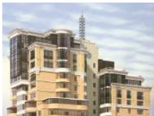
**Рис. 4.3.5** – Надстройка 3-уровневой мансарды из гнутосварных стальных профилей и перфорированных балок над существующим 17-этажным зданием по ул. Кропивницкого, г. Киев, Украина, 2016 г.
