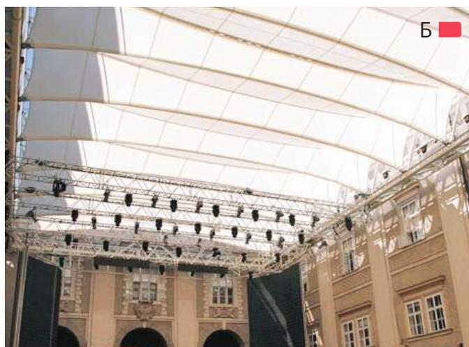
**Рис. 5.3.8** – Организация вантового складываемого покрытия с контурными фермами при реконструкции двора между зданиями в г. Зальцбург, Германия, проект бюро Kigel, 2012 г.
