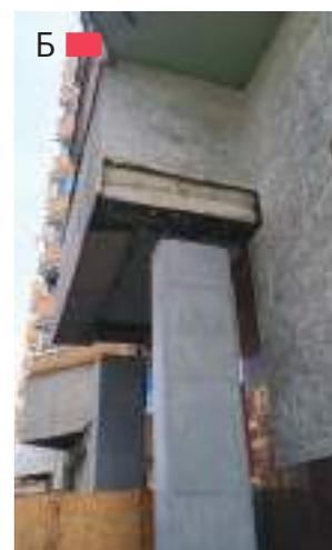
**Рис. 4.2.2** – А – достройка входной группы здания San Joaquin County с отдельными фундаментами, г. Stockton, США, 2008 г.; Б – подведение сталежелезобетонных пилонов для удержания консольной части здания с последующей достройкой в центре Киева, 2017 г. (см. также рис. 3.3.5, п. Г)
