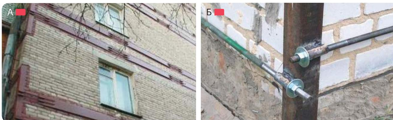
**Рис. 3.1.8** – Усиление кирпичных стен стальными тяжами: А – промежуточные узлы, Б – стяжные муфты на углах
