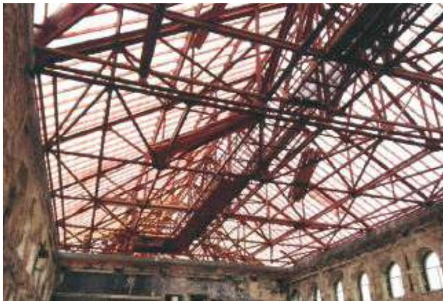
**Рис. 3.5.8** – А – замена покрытия в соборе на светопрозрачное (США); Б – замена после пожара кровли главного корпуса Национального университета биоресурсов и природопользования в г. Киеве, 2015 г., проект «Вартість»
