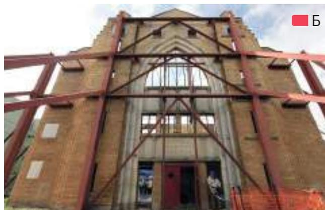
Рис. 1.2.5 – А – реставрация разрушенной церкви с введением металлокаркаса и частичным восстановлением стен в г. Хьюстон, США, арх. студия PGAL, 2009 г.; Б – пример консервации аварийного здания с введением внешних стальных опор
