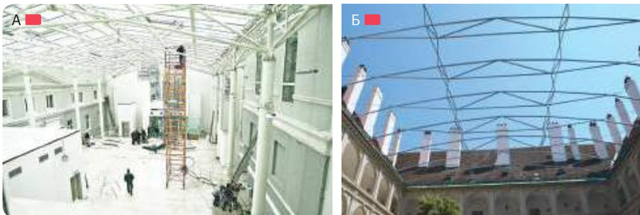
**Рис. 4.2.7** – Заполнение внутреннего двора атриумом со стальным покрытием фермами: А – на независимом каркасе в музее им. Т. Шевченко в г. Киеве, 2015 г.; Б – при опирании на существующие стены для накрытия светопрозрачным тентом во дворе королевского дворца в г. Вена, Австрия
