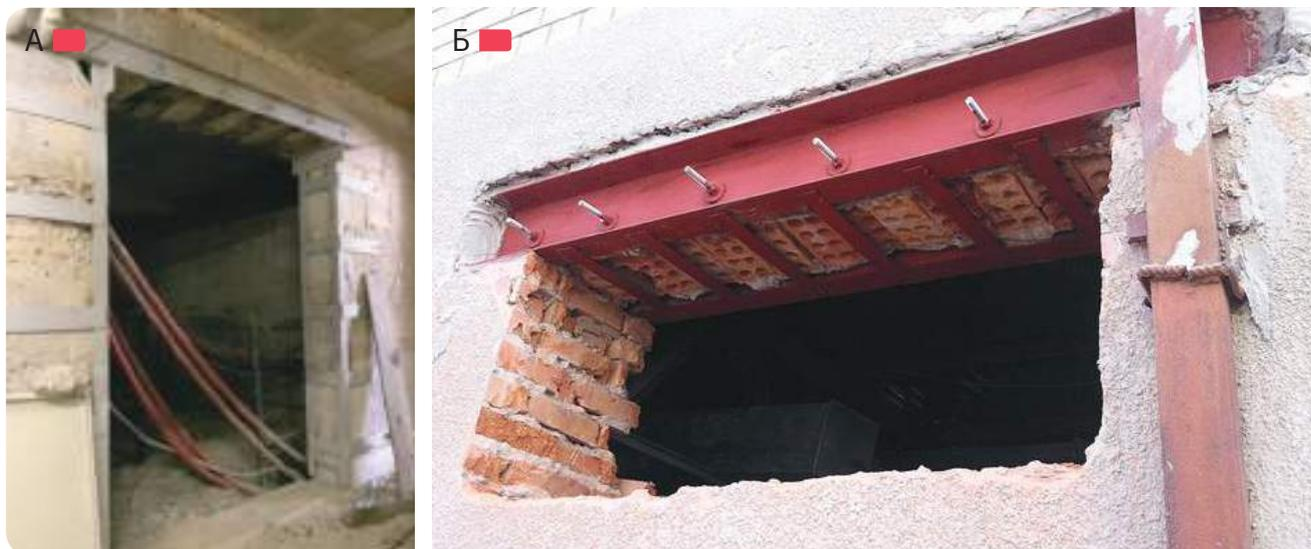
Рис. 3.3.2 – Обустройство: А – прохода в стене с помощью внешних перемычек из швеллеров с опиранием на полуобоймы; Б – оконного проема с помощью врезных перемычек с опиранием на кладку
