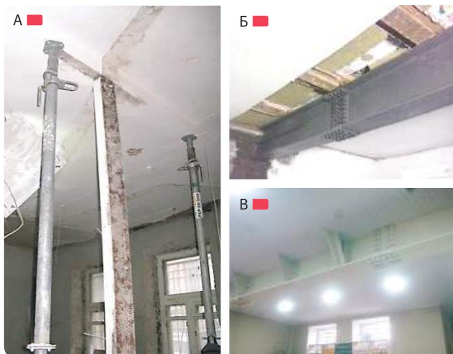
**Рис. 3.4.7** – Замена существующей аварийной колонны на балку в магазине в г. Киеве, 2013 г.: А – колонна с потерей общей устойчивости; Б – подведение балки под существующее деревянное перекрытие; В – вид в интерьере магазина
