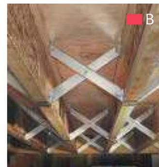
**Рис. 1.2.1** – переоснащение с заменой пожарных лестниц в здании; Б – добавление стальных элементов крепления утепления типового рамного каркаса; В – установка стальных связей из плоскости деревянных балок при увеличении нагрузки на перекрытия
