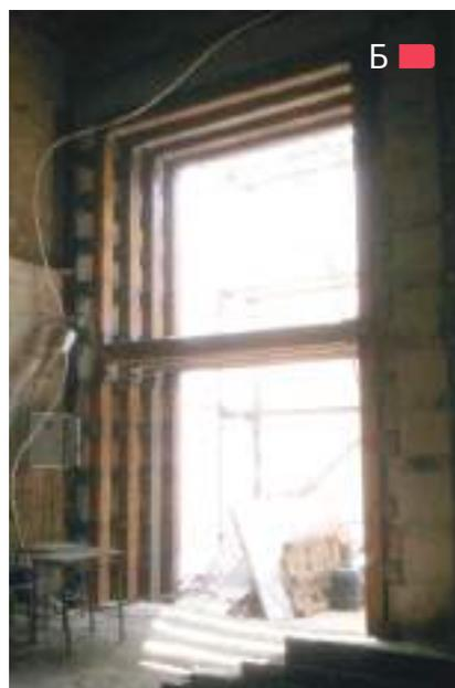
**Рис. 3.3.8** – Обустройство проемов с врезными рамами в стенах первого этажа 8-этажного здания по ул. Сечевых Стрельцов в г. Киеве, 2013 г. – А; врезные рамы замкнутого контура с перемычками для антресольного этажа фасадной стены, ул. Бассейная в г. Киеве, 2014 г. – Б
