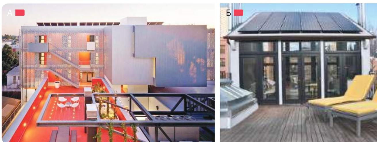
**Рис. 2.7.15** – А – солнечные батареи и озеленение на надстройке со стальным каркасом при реновации здания 1926 г. с сертификатом эффективности LEED Gold в г. Лос-Анджелес, проект бюро KEA, 2014 г.; Б – надстройка и солнечные батареи при реконструкции пентхауса на Манхэттене, Нью-Йорк, США
