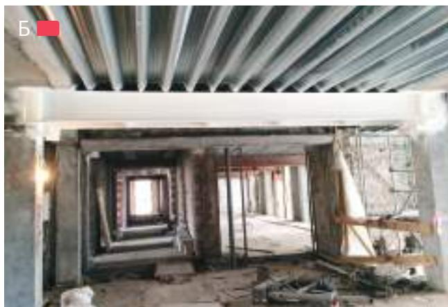
**Рис. 2.7.6** – Конструктивная огнезащита: А – сталебетонного ригеля обшивкой теплоизоляционным материалом с дальнейшим оштукатуриванием по сетке; Б – подведенного стального ригеля нанесением интумесцентного покрытия
