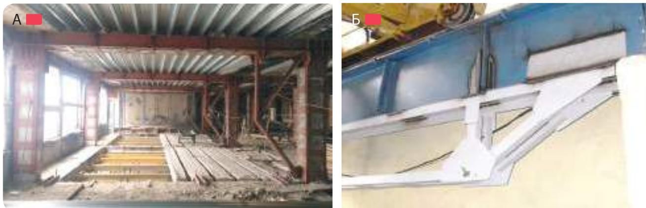
**Рис. 3.2.17** – А – усиление железобетонного ригеля с применением подкосов; Б – усиление стальной балки подвариваемым шпренгелем из уголков
