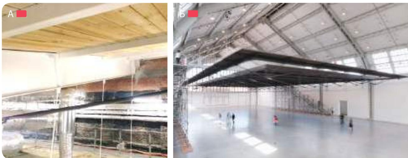
**Рис. 3.5.15** – А – подвешивание чердачного этажа на тросах к стропильным балкам при восстановлении кинотеатра «Жовтень», стропильные балки опираются на существующие стены через монолитный пояс, г. Киев, 2015 г.; Б – обустройство подвесных этажей при реконструкции в общественном здании Horizon Field Hamburg, 2012 г. (Rawson Hall 1904 г.)
