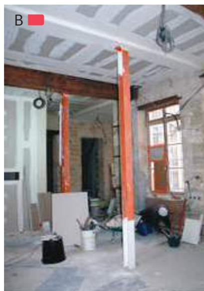
**Рис. 3.4.4** – Введение новых стальных колонн: А – поддержание архитрава Акрополиса в Афинах, Греция; Б – усиление балки перекрытия паркинга в Марселе, Франция; В – подкрепление существующего перекрытия в здании 18 века в Париже, Франция
