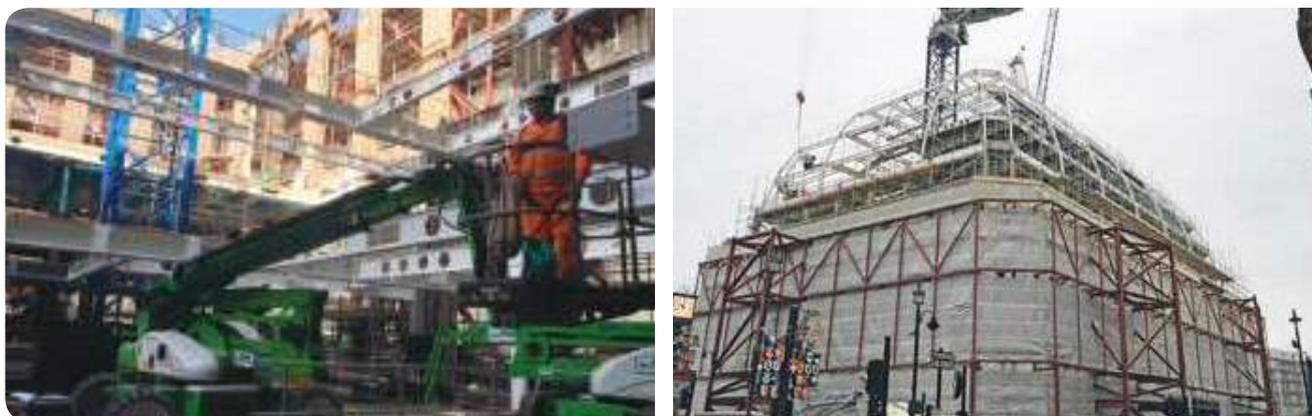
**Рис. 3.6.6** – Введение внутренних временных раскреплений (А) и постоянного каркаса (Б) с заменой кровли здания LSQ London, Великобритания, арх. бюро Make, конструктив бюро Waterman 2016 г.
