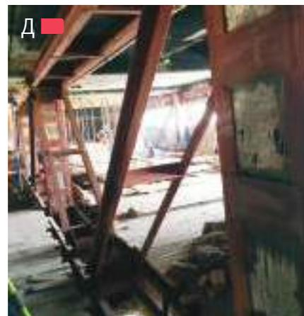
**Рис. 3.1.9** – Схема усиления колонн первых этажей: А – приставные стойки; Б – установка связей; В – введение дублирующих стальных рам; Г – крестовые связи из круглой стали в интерьере при реновации здания 1930 г. в г. Бухаресте, Румыния, арх. бюро TECON; Д – связи по колоннам, разнесенные в нижних узлах с целью обустройства проходов
