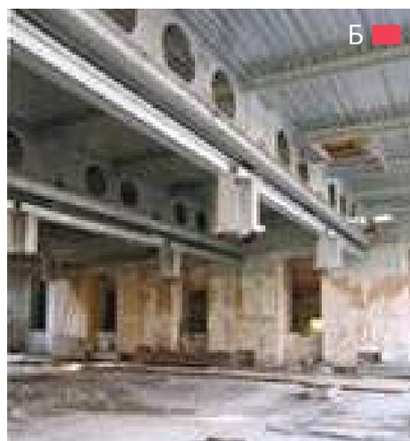
**Рис. 3.5.7** – А – замена покрытия и перекрытий в Мыстецьком Арсенале 18 в., г. Киев, 2010 г.; Б – замена деревянного перекрытия на композитное с перфорированными балками пролетом 24 м в Bernardine convent 16 века, проект J. Wilmotte
