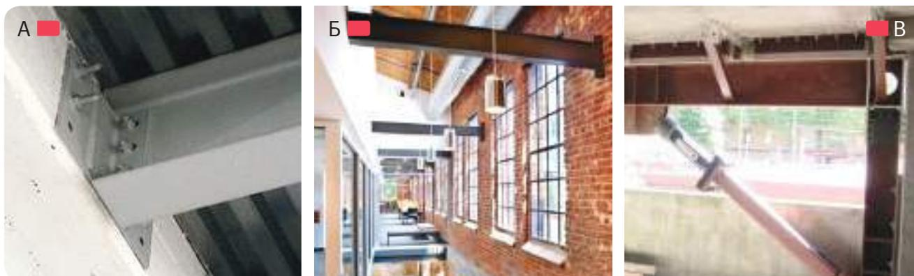
**Рис. 2.5.12** – А – крепление стальных прогонов к железобетонной балке перекрытия хим. анкерами; Б – крепление балок хим. анкерами к кирпичной стене при реконструкции здания Park Shops в г. Raleigh, North Carolina, США, арх. С. Nexsen; В – крепление связевых систем противосейсмического усиления с помощью механических анкеров, США
