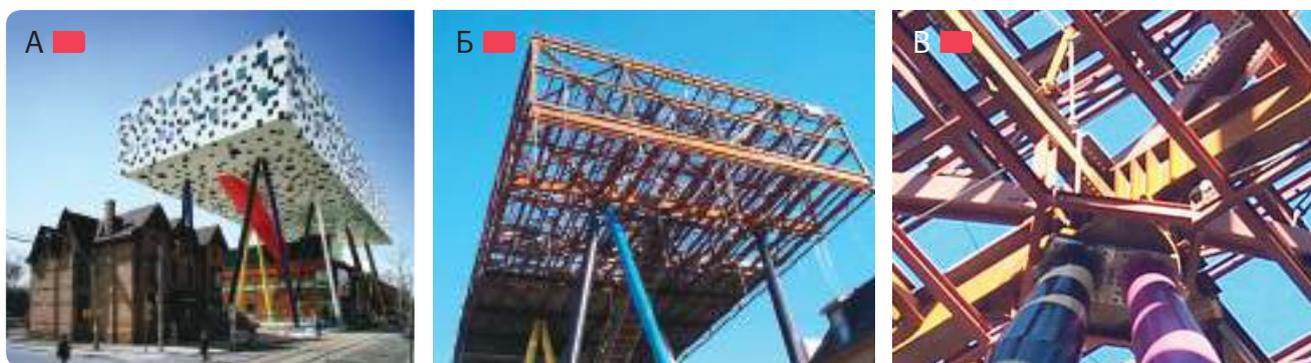
**Рис. 5.4.8** – Нависание над формой здания колледжа искусств и дизайна OCAD, Торонто, Канада, арх. W. Alsop 2004 г.: А – внешний вид; Б – каркас с консолями; В – узел опирания на пилоны
