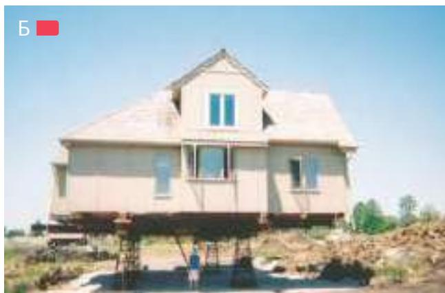
**Рис. 5.1.6** – Подъем здания: А – комбинированный, с помощью подъемного крана двумя частями через пространственную систему в г. Сан Антонио, США, компания «Dodson House Moving» 2013 г.; Б – на решетчатых стойках через стальную балочную клетку, США
