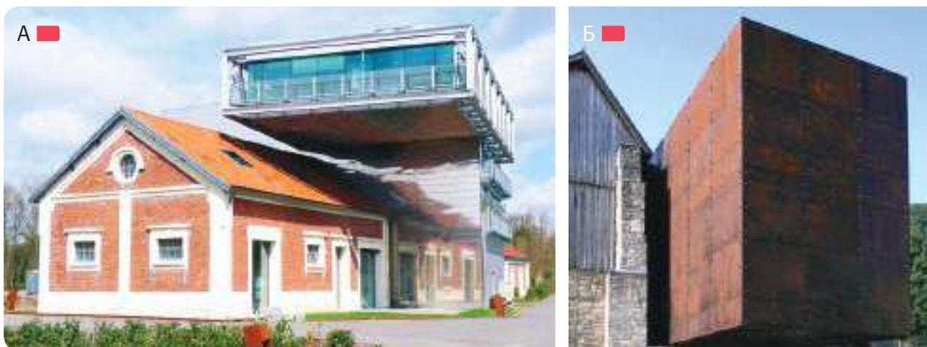
**Рис. 4.1.7** – А – организация консоли с помощью аутригеров при реконструкции старого кирпичного гаража в современный офис, Франция, арх. Н. Arnod, 2014 г.; Б – консольный аутригер с обшивкой листами атмосферостойкой стали в реконструированном Музее Соли в Salins-les-Bains, Франция, арх. Malcotti Roussey, 2009 г.
