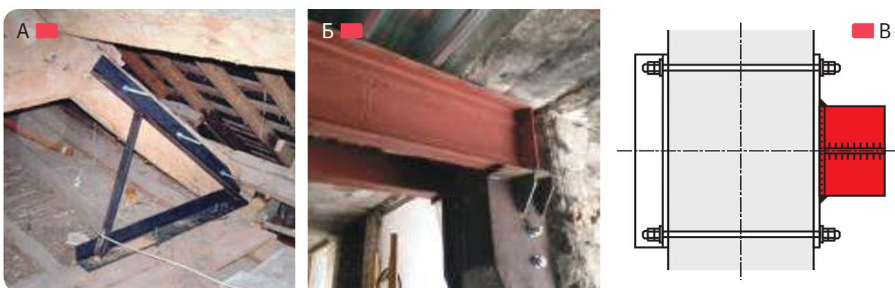
**Рис. 2.5.7** – А – усиление опорного узла стропильной деревянной системы путем установки стального элемента на шпильках; Б – крепление ригеля к железобетонной колонне с помощью сквозных шпилек; В – схема крепления опорного кронштейна к стене с помощью шпилек и уголка
