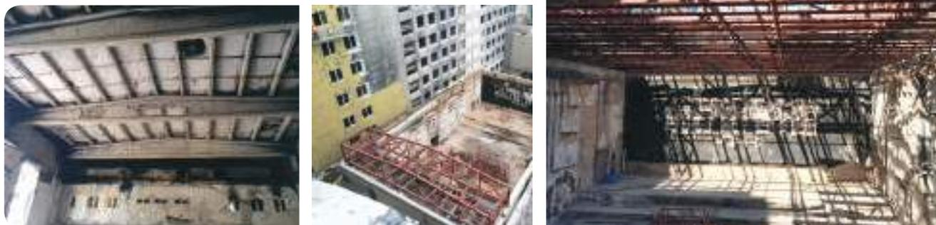
**Рис. 3.5.9** – Замена аварийного железобетонного покрытия актового зала Дома Профсоюзов в г. Киеве после пожара на новое по металлическим фермам, 2017 г. проект «Вартість»
