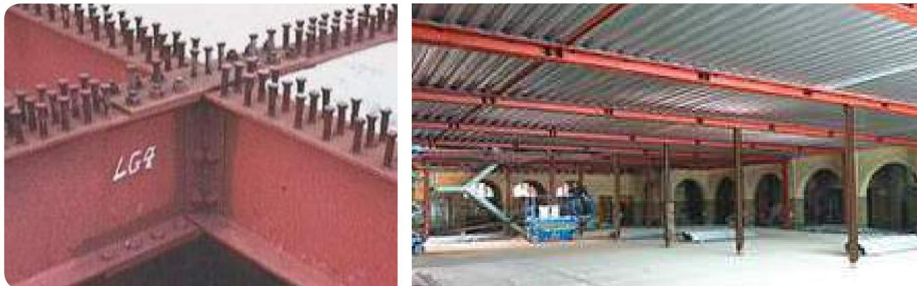
**Рис. 3.5.3** – Применение композитной работы балок с плитами по профилированному настилу, пример при реконструкции церкви Chasséstraat в г. Амстердам, Голландия, 2013 г.
