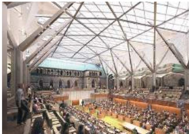
**Рис. 6.1.2** – Объединение форм структурной системой с деревовидными колоннами Парламента Канады, г. Оттава Арх. ARCOP/FGMDA, конструктив Ojdrovic + Cooke, 2017 г.
