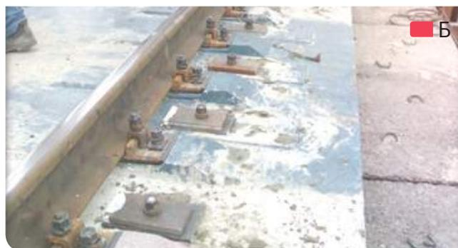
**Рис. 2.5.9** – Капитальный ремонт стального моста с установкой железобетонных плит железнодорожного полотна на приваренные к верхнему поясу балок анкеры шпильки
