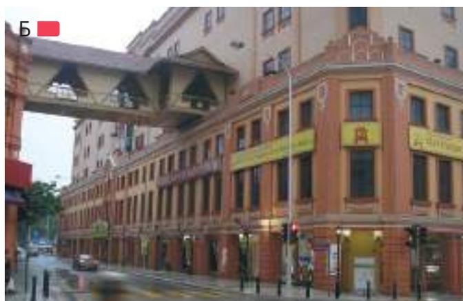
Рис. 5.3.2 – Соединение существующих зданий стальными переходами: А – Хай-Лайн в Нью-Йорке, США, 2009 г.; Б – реконструкция магазина с образованием перехода в центре г. Куала-Лумпур, Малайзия
