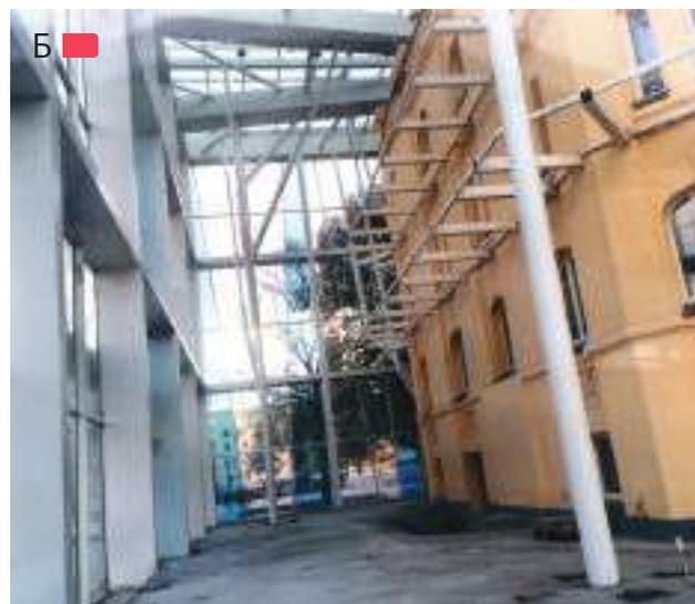
**Рис. 4.4.2** – Пристройка к Музею в г. Харькове стального каркаса с остеклением и дополнительными внутренними колоннами в процессе строительства, проект «Ароф», 2016 г.
