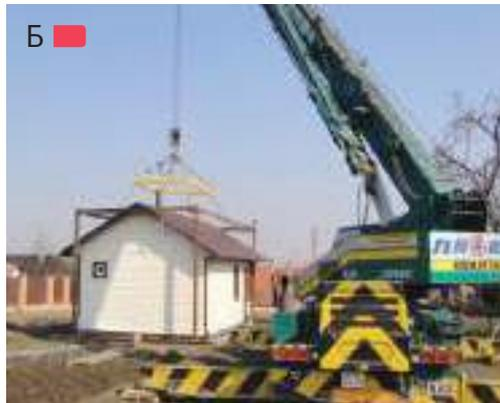
**Рис. 5.2.5** – А – перемещение здания по частям на автоплатформе в штате Каролина, США; Б – перемещение небольшого дома автокраном с применением окармливающего временного каркаса
