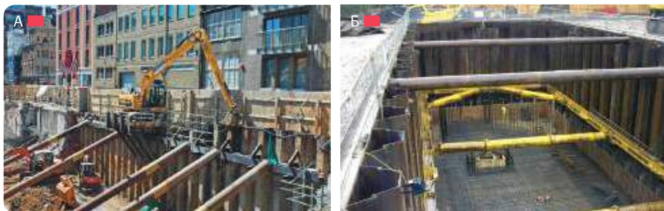
**Рис. 4.5.9** – А – подкосы укрепления шпунта при освоении подземного пространства в St. James Square, г. Лондон, Великобритания, компания «Johnfhunt»; Б – распорки шпунтовых стен
