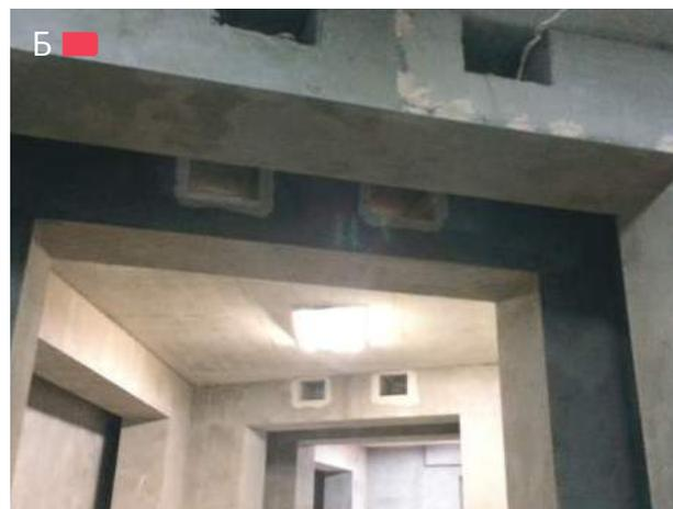
**Рис. 3.3.6** – Организация пропуска коммуникаций в сталекирпичных и сталебетонных ригелях с помощью ввариваемых в боковые листы труб и коробов с дальнейшей отделкой
