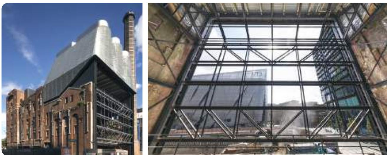
**Рис. 3.4.10** – Замена части кирпичных стен на независимые стоечно-ригельные каркасы здания Irving Street Brewery 1912 г., арх. бюро Tzannes Associates
