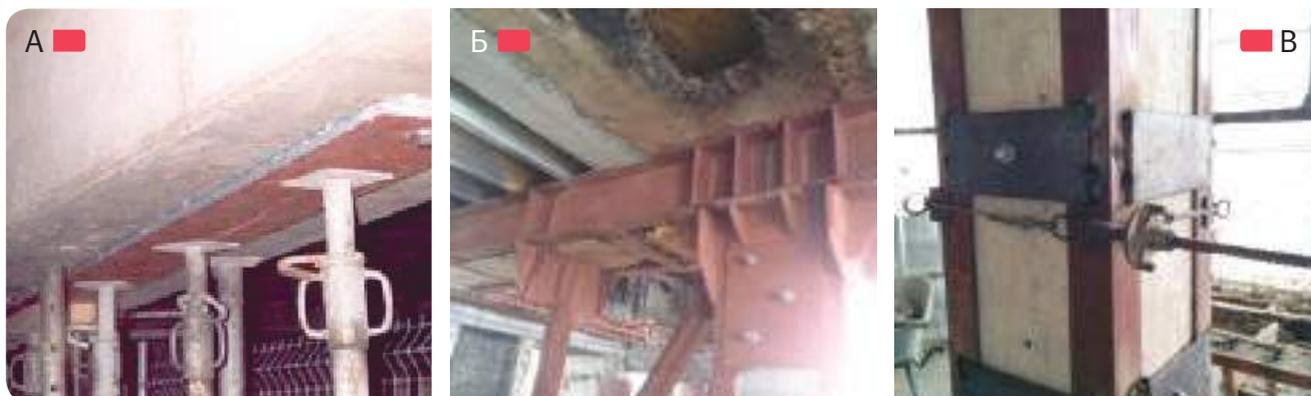
**Рис. 2.6.1** – А – включение в работу стального листа усиления железобетонной балки перекрытия на опалубочных стойках; Б – подклинивание металлических балок на опорных узлах пластинами с целью включения в работу; В – наваривание планок на обойму после стягивания струбцинами
