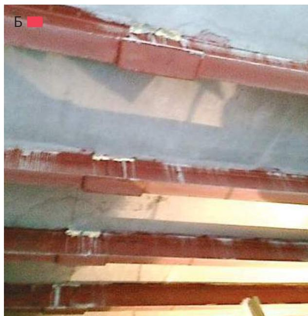
**Рис. 3.5.13** – Перекрытия пониженной высоты: А – с плитами по профнастилу при опирании на нижнюю полку сварных балок; Б – с монолитными плитами при опирании в одном уровне по прокатным балкам с подваренной средней полкой
