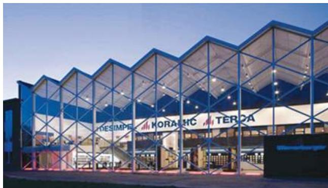
**Рис. 6.1.4** – Перенос на новое место здания со стальным каркасом 1958 г. из Брюссель в г. Бриндонк (Бельгия), 2008 г.
