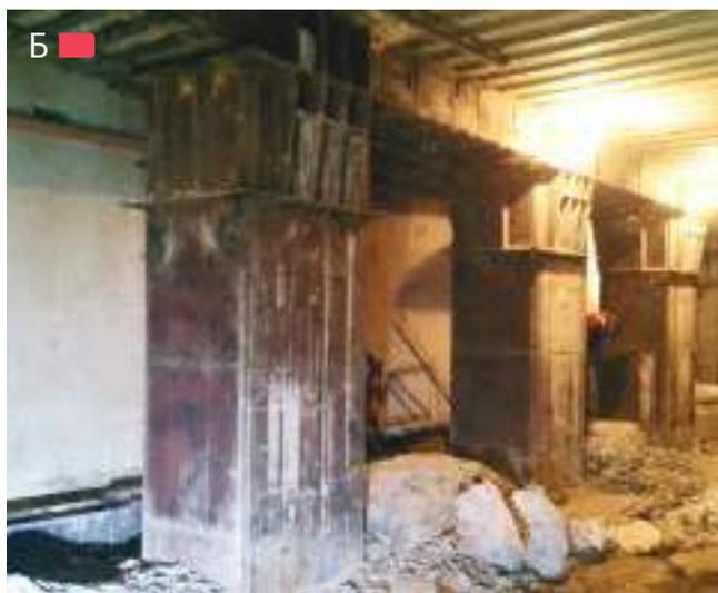
**Рис. 5.1.3** – Пересадка здания на вдавливаемые сваи через сталекирпичный пояс жесткости для подъема и дальнейшей замены фундаментов, а также освоения подземного пространства, г. Киев, 2014 г., проект «Вартість»
