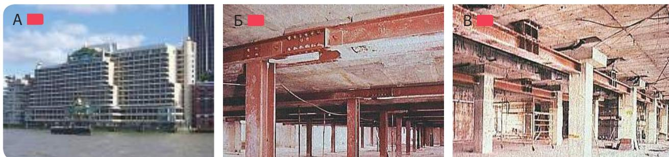
**Рис. 3.4.8** – Смещение сетки колонн с целью надстройки здания Sea Containers Ltd., Лондон, Великобритания, 1989 г.
