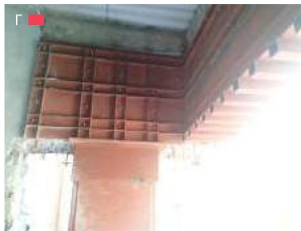
**Рис. 3.3.5** – Примеры обустройства ригелей: А – сталекирпичного с внутренними уголками; Б – сталебетонного с верхними внешними уголками; В – решетчатого; Г – ортотропного (см. также рис. 4.2.2 Б)
