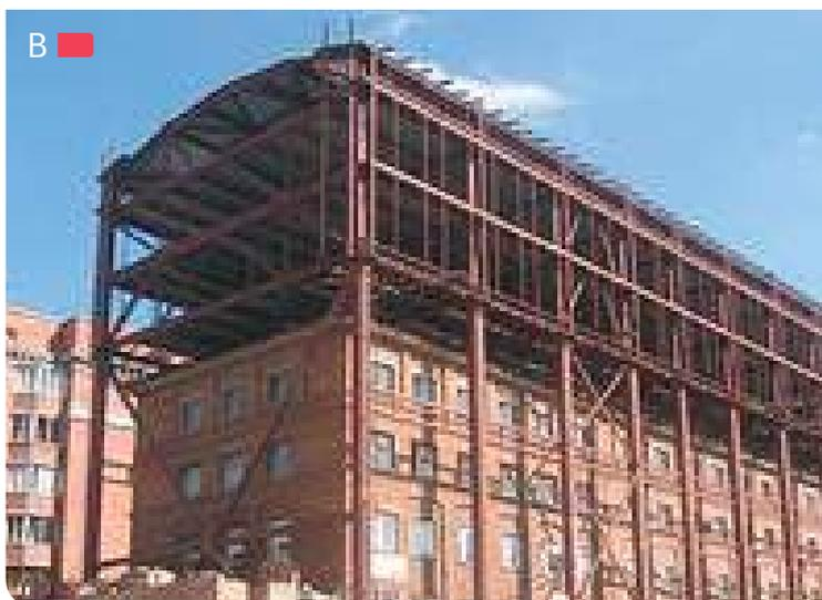
**Рис. 4.3.9** – А – вид и разрез (Б) рамного каркаса над промышленным цехом при реконструкции под оперный театр О.Т. в г. Роттердам, Нидерланды, проект бюро Ziegler | Branderhorst, 2015 г.; В - возведение над зданием рамно-связевого каркаса для организации дополнительных этажей и площадей в жилой старой застройке без отселения жильцов
