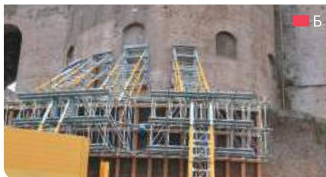
**Рис. 1.3.4** – Контраварийные стальные системы тяжёлой и временного подкрепления конструкций контрфорсами храмового комплекса в Риме, Италия 2014 г.
