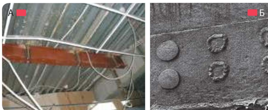
**Рис. 2.5.1** – А – приваривание усиливающих ребер в существующей стальной балке; Б – усиление элементов, соединенных на заклепках, путем их высверливания и точечного заваривания
