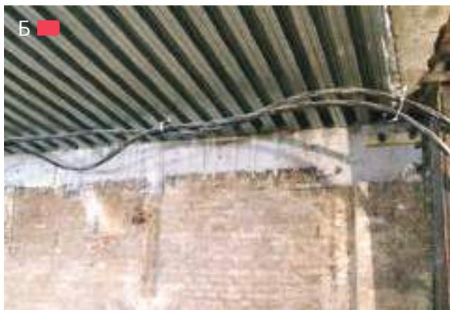
**Рис. 2.5.14** – А – пример омоноличивания опорных зон балок в гnezдах при замене перекрытия; Б – организация монолитного пояса при опирании и анкерровке плиты по стальному профнастилу
