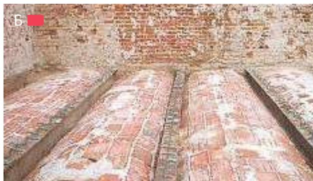
**Рис. 3.2.15** – Усиление сталекирпичных перекрытий путем обеспечения совместной работы с монолитной плитой с постановкой анкерных упоров по верхним поясам балок
