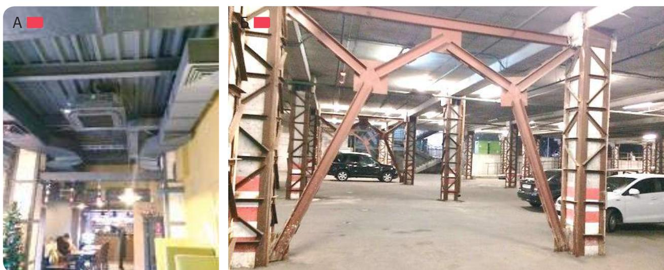
**Рис. 3.1.3** – Оформление усиления колонн обоймами: А – на планках в интерьере ресторана; Б – в открытом паркинге с решеткой из уголков и связями из швеллеров
