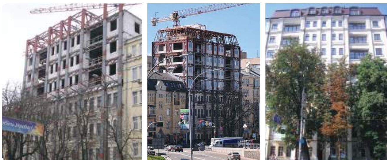
**Рис. 4.3.10** – Возведение над существующим зданием пяти этажей без отселения жильцов на пл. Славы в Киеве, 2010 г.: А, Б – процесс выполнения, В – готовое здание, проект «Основа»
