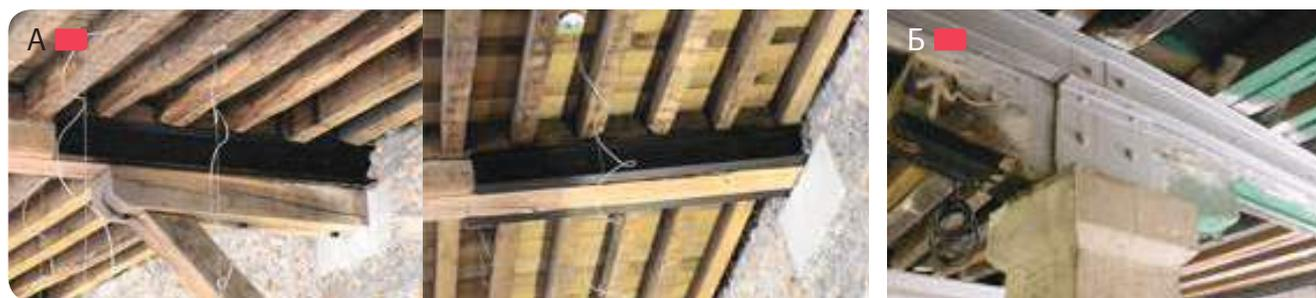
**Рис. 3.2.6** – Примеры увеличения сечения деревянных балок: А – в опорной зоне с последующим демонтажем существующего подкоса; Б – у оголовка колонны
