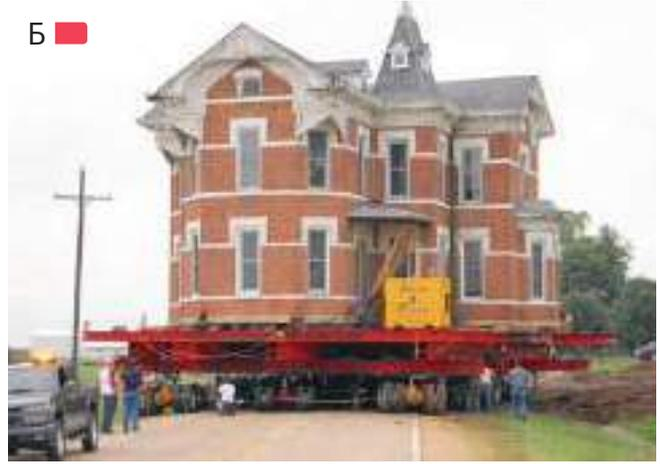
**Рис. 5.2.4** – Стальная балочная клетка из двутавров и пневмошинные тележки для перемещения здания в штате Айова, США
