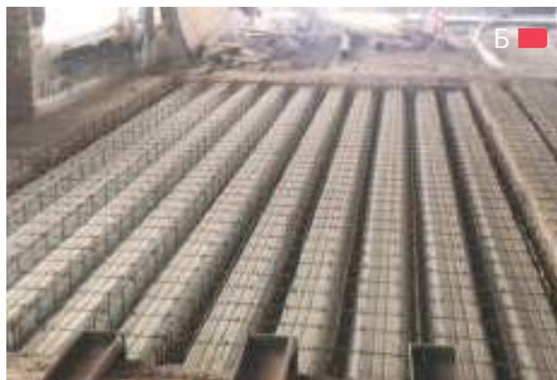
**Рис. 3.5.12** – Обустройство новых плит по профнастилу:
