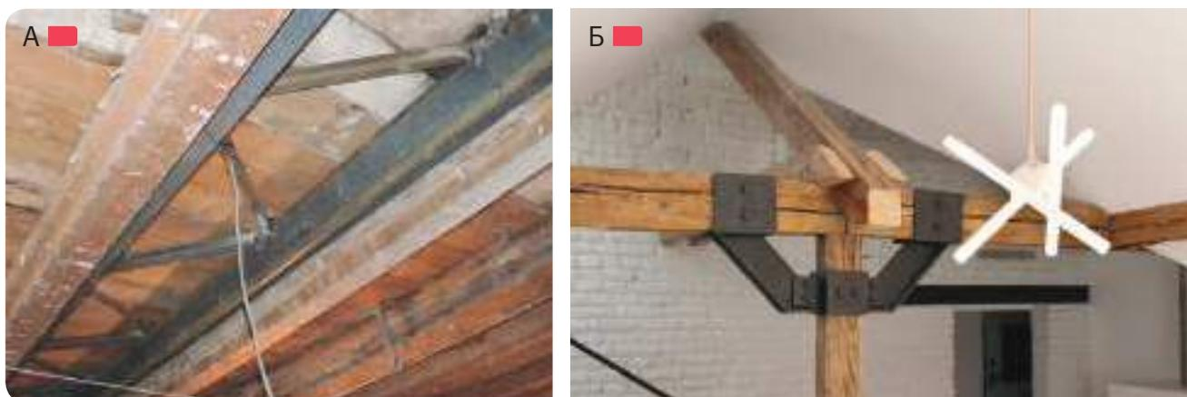
**Рис. 3.2.13** – А – подведение стальных швеллеров под деревянный дощатый настил по существующему перекрытию с установкой горизонтальных связей; Б – усиление узлов деревянных балок с обеспечением неразрезной работы
