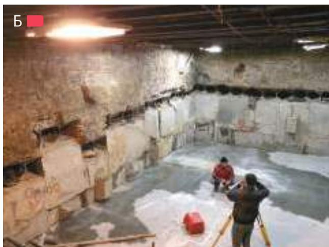
**Рис. 4.5.4** – Освоение подземного пространства с вывешиванием стен подвальной части здания на стальных элементах фиксации усилий поддомкрачивания, г. Киев, 2015 г.
