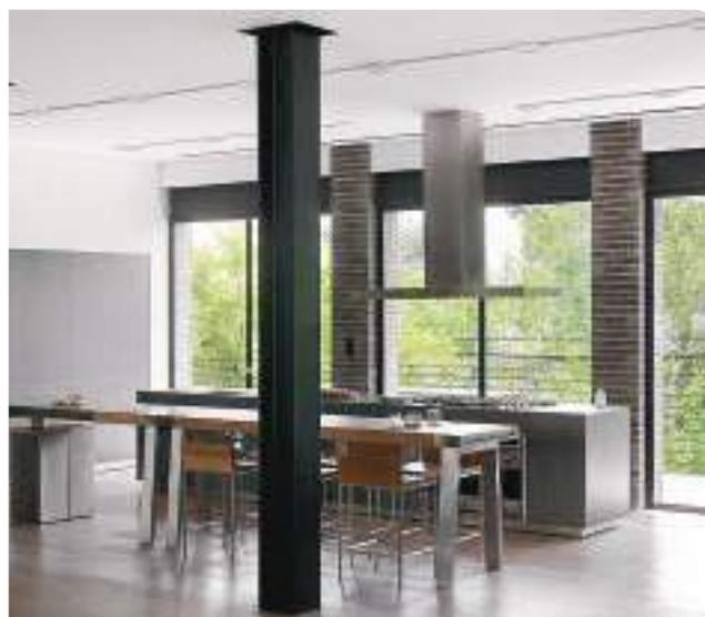
Рис. 3.4.5 – Вид в интерьере усиления путем введения новых дополнительных колонн
