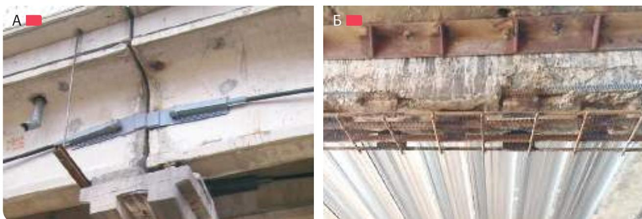
**Рис. 3.2.3** – Увеличение сечения железобетонных балок: А – внешними тяжами со стягиванием шпильками; Б – преобразованием элемента в сталежелезобетонный с присоединением к существующей арматуре в процессе выполнения работ
