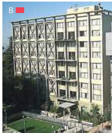
**Рис. 1.1.1** – А – реконструкция Музея Природы в Онтарио, Канада, 2010 г., арх. бюро КРМВ; Б – надстройка Оперы в г. Лион, Франция, 1993 г., арх. Ж. Нувель; В – введение стальной связевой системы в каркас университета в г. Беркли, США при изменении сейсмических требований, 1989 г.
