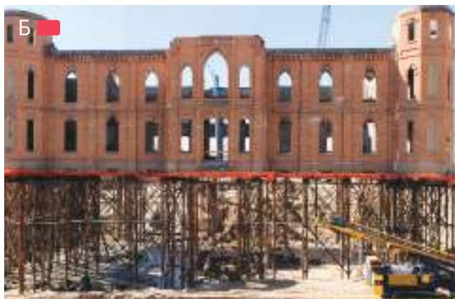
**Рис. 5.1.7** – Реконструкция храма Provo 1870 г. после пожара – А; с подъемом на 12 м вверх на домкратах и решетчатых стальных стойках – Б, США, 2013 г.
