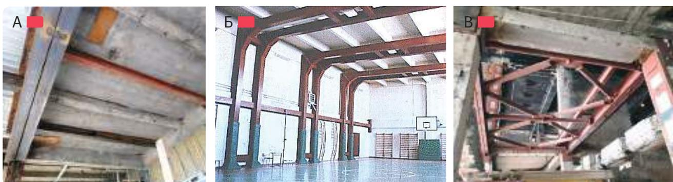
**Рис. 3.2.11** – Введение дублирующих стальных элементов для железобетонных перекрытий: А – плит многоэтажного здания в Нью-Джерси (США, 2014 г.) с промежуточными стальными прогонами; Б – балок спортивного зала путем подведения стальных рам в г. Канту, Италия, 1990 г.; В – введение блока горизонтальных связей при усилении после пожара, Дом Профсоюзов, Киев 2017 г.
