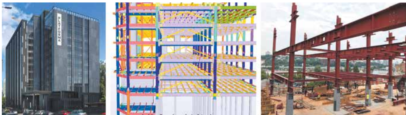
Рис. 3.17. Фасад БЦ Platforma.
