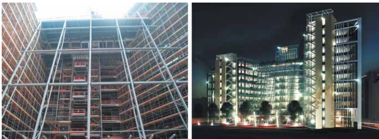
Рис. 2.1. Офісна 12-поверхова будівля площею 20 400 м 2 зі сталевим каркасом (м.Лідс, ВБ), що отримала рейтинг «Чудово» згідно BREEAM у 2017 році. Конструкції важать біля 2000 тонн, а завдяки великим прольотам створено більшу гнучкість планувань для орендарів
