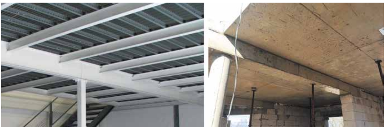
Рис.5.1. Ілюстрація до прикладу 1: перекриття із застосуванням зварних балок (a) і монолітного залізобетону (b) за умови короткого прольоту
