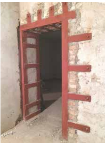
Рис. 5.11. Основні конструктивні прийоми, що були застосовані під час відновлення будівлі: а) улаштування, розширення та підсилення просвітів – врізані перемички і рами замкнутого контуру; б) здійснено підсилення і дублювання консолей металевими елементами; в) у місцях заміни і доповнення перекриттів застосовані ефективні композитні балки
