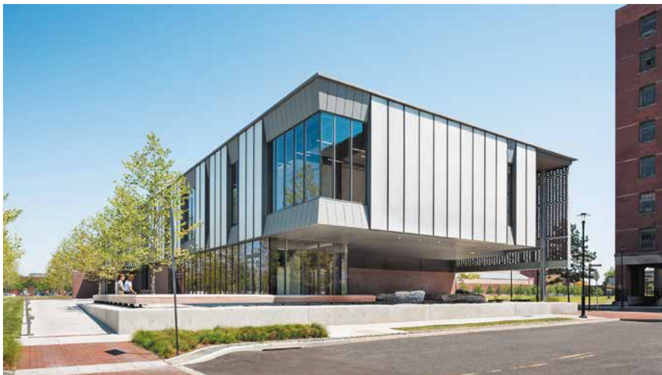
Рис. 2.10. Використання інструментів аналізу життєвого циклу Tally дозволило вибрати опорядження для будівлі Consortium for Building Energy Innovation (США) із металевих сандвіч-панелей, яке виявилось оптимальним за екологічними показниками (проект Michael Moran/OTTO Kieran Timberlake) [2.36]
