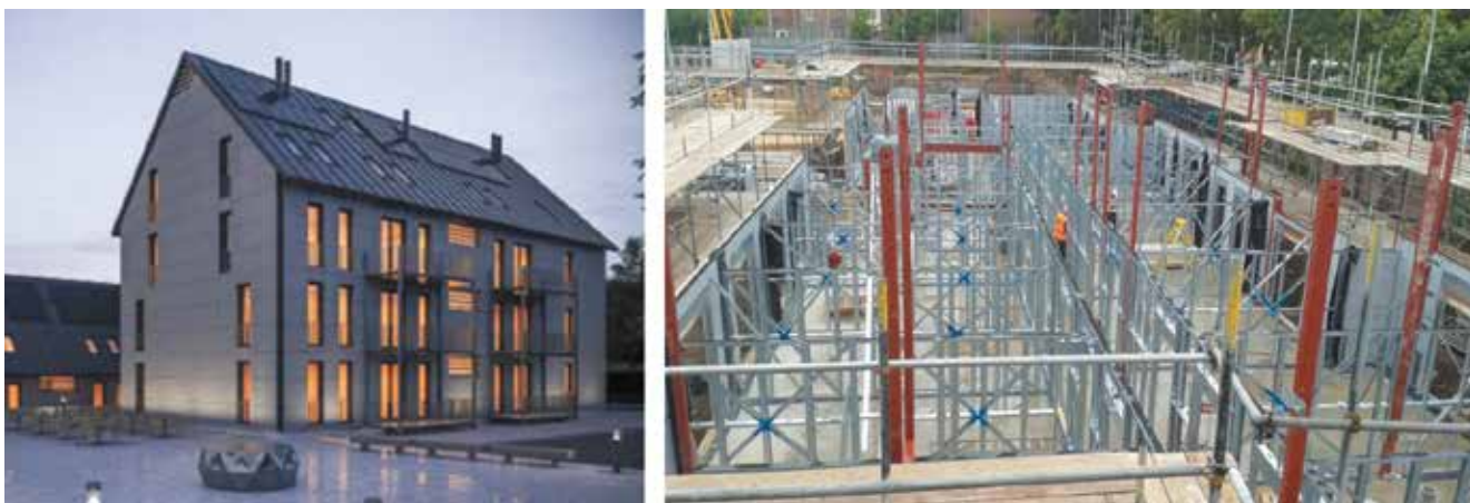
Рис. 3.4. Уряд Британії постановив до 2022 року збудувати 25 000 збірних модульних будинків, де за результатом аналізу життєвого циклу для зменшення вуглецевого сліду було обрано легкі сталеві конструкції у якості несучого каркасу [3.41]
