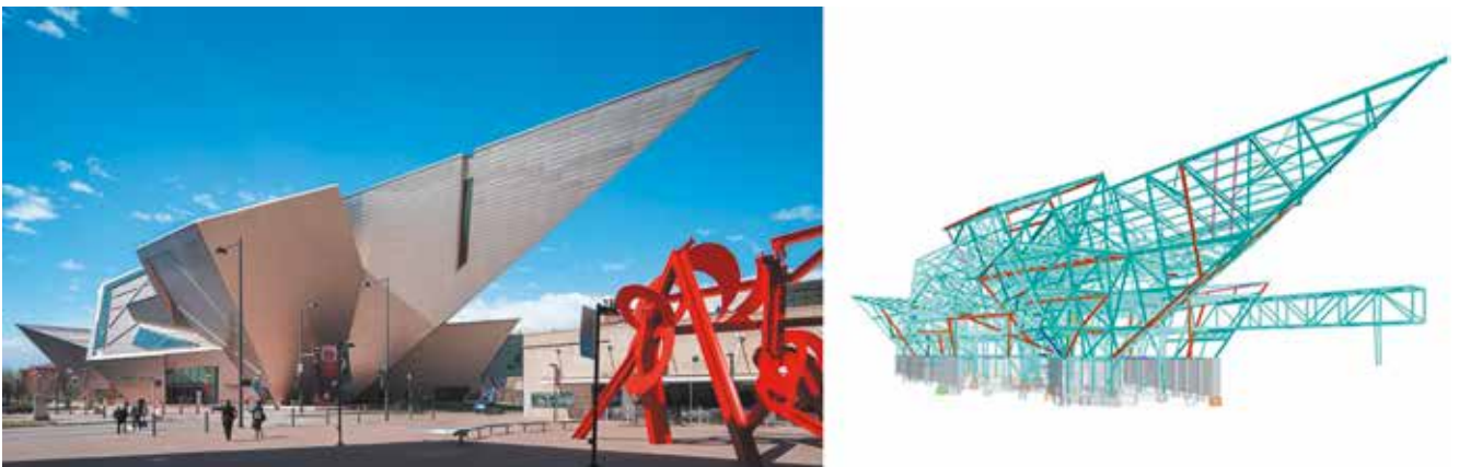
Рис. 3.12. Фасад та BIM-модель сталевого каркасу Музею мистецтв у м.Денвер, США (архітектурне бюро Studio Libeskind, 2006 рік). Застосування BIM дозволило скоротити термін будівництва на 14 місяців і призвело до економії приблизно 400 тисяч доларів США
