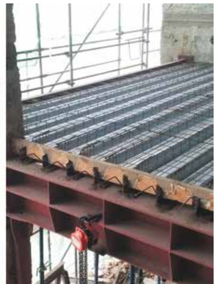
Рис. 5.11. Основні конструктивні прийоми, що були застосовані під час відновлення будівлі: а) улаштування, розширення та підсилення просвітів – врізані перемички і рами замкнутого контуру; б) здійснено підсилення і дублювання консолей металевими елементами; в) у місцях заміни і доповнення перекриттів застосовані ефективні композитні балки
