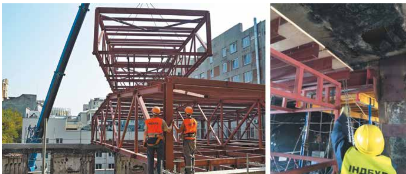
Рис. 5.13. А) укрупнення і блочний монтаж ферм актової зали з улаштуванням технічного поверху; б) технологічні конструкції для ведення робіт з підсилення зверху вниз
