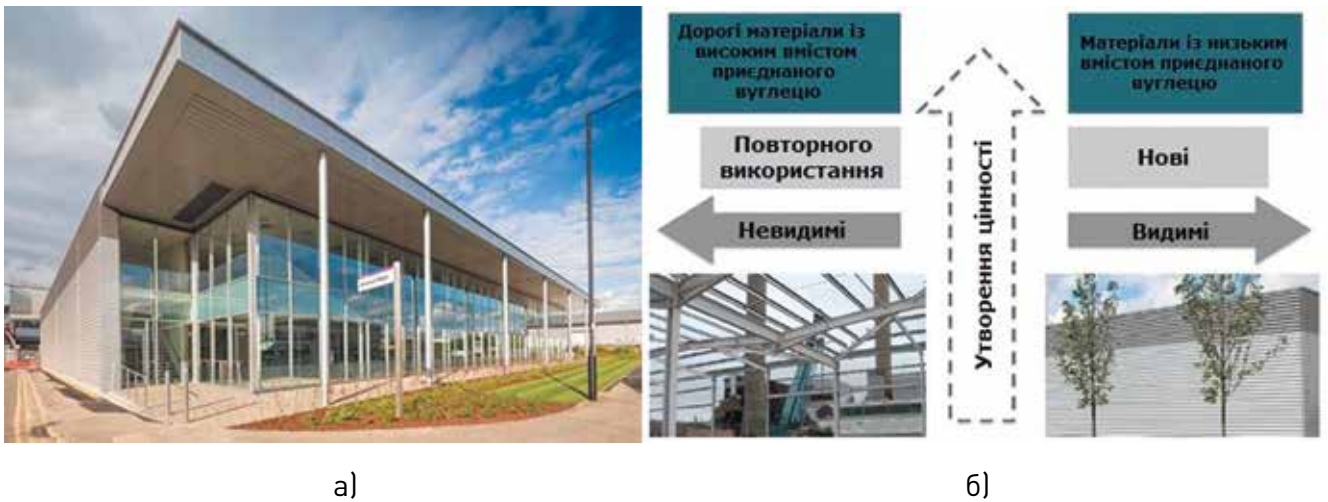
Рис. 6.13. Внаслідок оцінки життєвого циклу було вирішено перемістити і використати виробничу будівлю у м.Слау, ВБ повторно замість знесення і утилізації (а); схема генерації вартості проекту (б).
