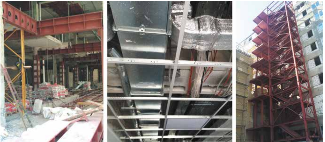
Рис. 5.14. А) ефективні балки перекриттів з перфораціями для пропуску комунікацій, б) проходження мереж під підсиленими балками у коридорах будівлі; в) сходи Н1, прибудовані в межах плями забудови
