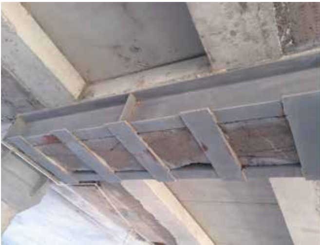
Рис. 5.10. Основні конструктивні прийоми, які були застосовані під час відновлення будівлі: а) горизонтальні сталеві в'язеві системи; б) підсилення стін-діафрагм сталевими в'язями; в) підсилення перекриттів сталевими балками і збільшення перерізів; г) підсилення ригелів сталевими розкосами з метою зменшення прольотів
