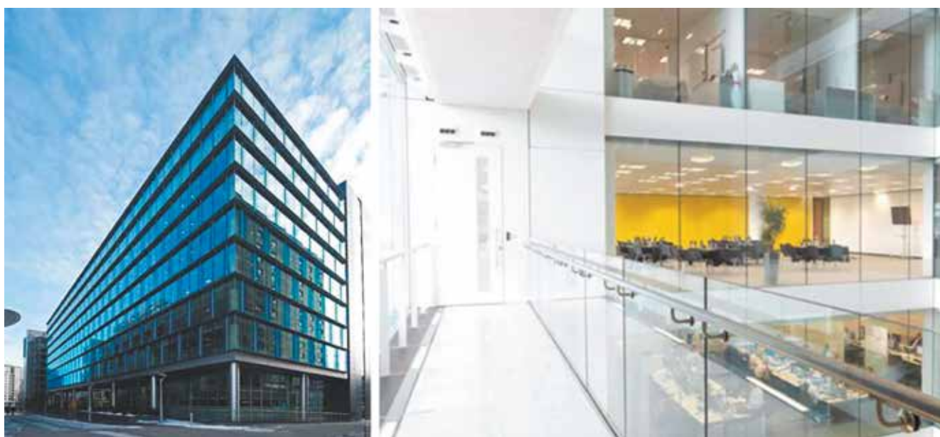
Рис. 1.19. Офісна будівля із сталевим каркасом «One Kingdom Street» (м.Лондон, ВБ)
