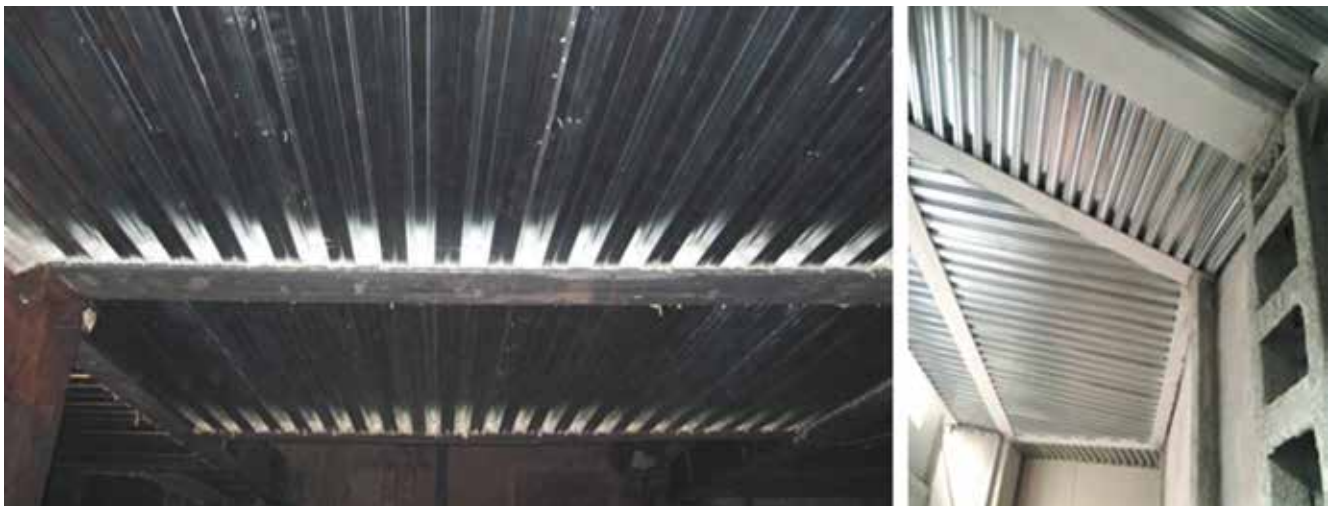
Рис. 3.27. Ілюстрації перекриттів пониженої висоти із монолітними перекриттями по профнастилу
