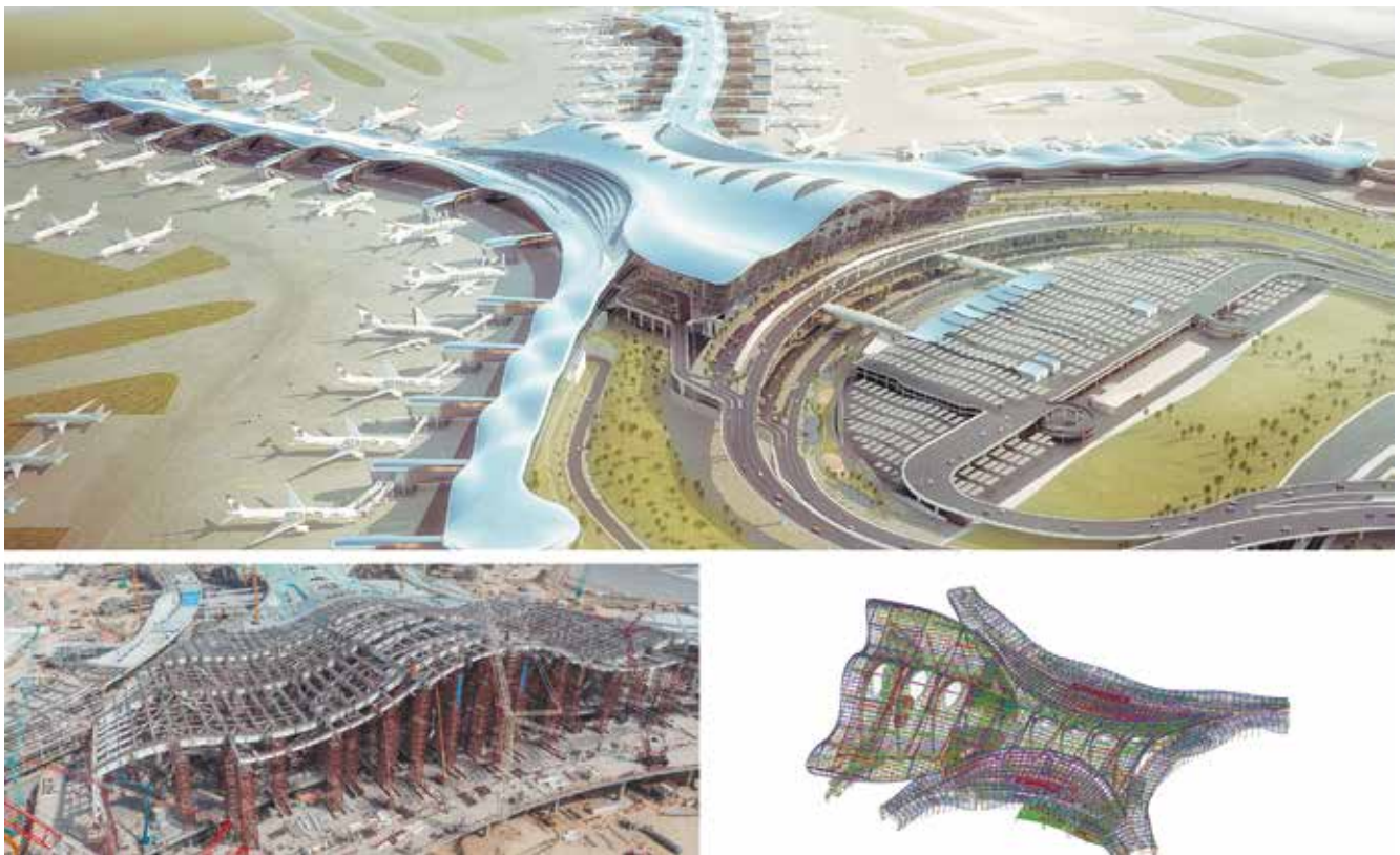
Рис. 2.7. Новий, найбільший на планеті термінал Midfield в м.Абу-Дабі, ОАЕ площею 700 000 м 2 має каркас вагою понад 269 000 тонн сталі з високим вмістом брухту, а понад 20% всіх матеріалів у проекті мають регіональне походження. Всі розробки, зокрема і розрахунки конструкцій, велися тільки на основі однієї платформи BIM, щоб всі зацікавлені сторони могли обмінюватися інформацією і співпрацювати [2.37]
