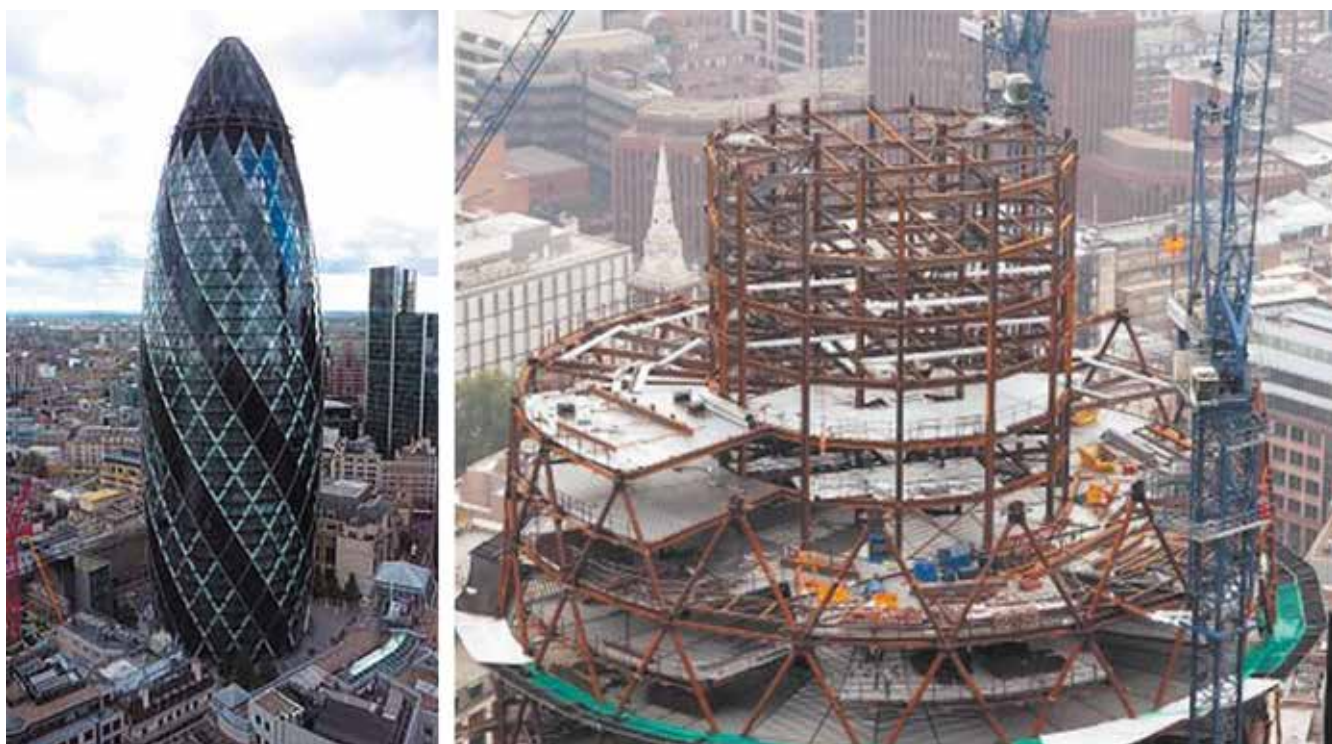
Рис. 4.2. Будівля «30 St. Mary Axe», Лондон, ВБ (проект бюро «Foster + Partners») показала значення приєданого вуглецю 955 кг CO 2 на 1 м 2 загальної площі підлоги
