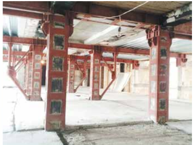
Рис. 5.10. Основні конструктивні прийоми, які були застосовані під час відновлення будівлі: а) горизонтальні сталеві в'язеві системи; б) підсилення стін-діафрагм сталевими в'язями; в) підсилення перекриттів сталевими балками і збільшення перерізів; г) підсилення ригелів сталевими розкосами з метою зменшення прольотів
