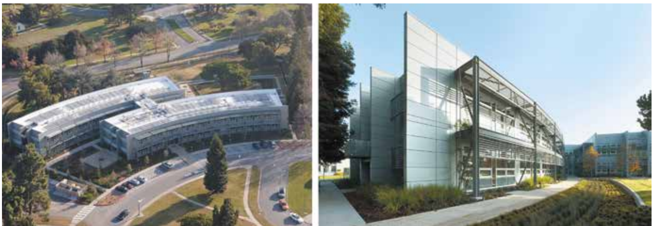
Рис. 6.12. Енергопасивні корпуси НАСА зі сталевим каркасом, що враховує майбутні добудови (США, 2011 рік)
