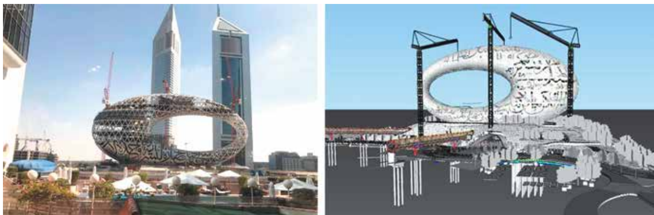
Рис. 3.13. BIM-модель циклу спорудження і реалізація сталевого каркасу Музею майбутнього у м.Дубаї, (ОАЕ, 2020 рік). Проект бюро Killa Design. Фото: CNN
