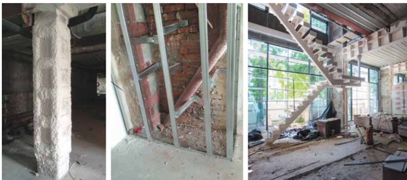
Рис. 5.12. А) використання вогнестійких штукатурок для захисту колон; б) конструктивний вогнезахист підкосів гіпсокартонними листами; в) вогнезахист балок і нових внутрішніх сходів інтумесцентними покриттями
